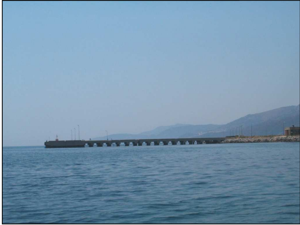
Şekil 4.2 Kemerköy Ağır Yük İskelesi genel görünümü
