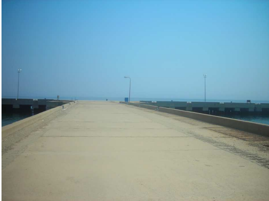
Şekil 4.11 İskele döşeme betonu
