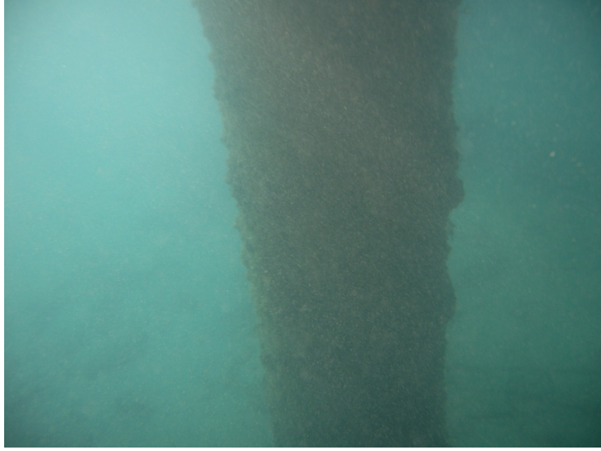
Şekil 4.9 Kazıkların sürekli su içinde kalan bölümü
