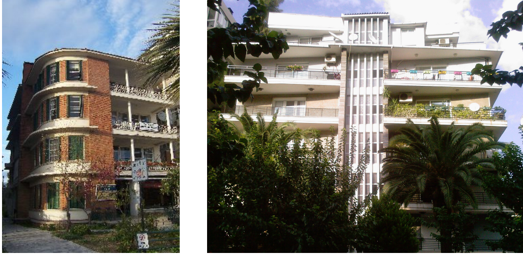
Şekil 3.20 1952 planından sonra tasarlanan dönemin önemli 4, 5 katlı kira evlerinden, soldaki Paya Apartmanı, Yalı Caddesi, Mimarı Ziya Nebiloğlu, 1957 (Özkaban, 2008, s.62), sağdaki Tikveşli Apartmanı, Alsancak, Mimarı Özcan Özşişman, 1957 (Özgecan Akbayırlı Arşivi).
