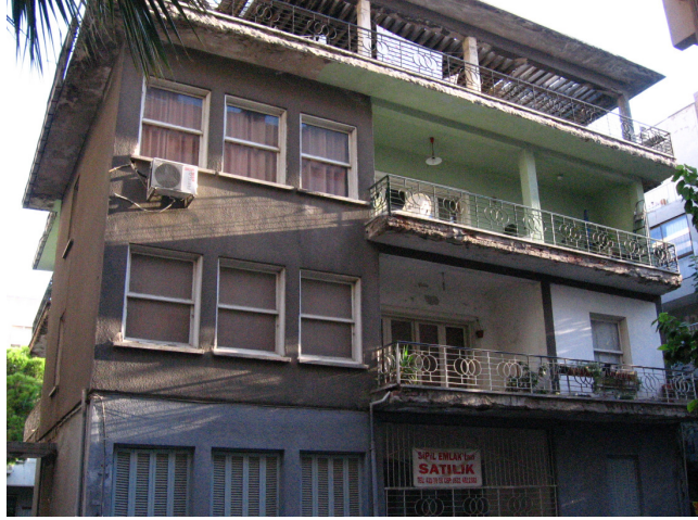
Şekil 3.27 Kahramanlar'daki Eshot ve Bel. Mem. ve Müs. Modern Ev. Yapı Kooperatifi'nden sonradan kat eklenerek günümüze ulaşmış bir örnek (Özgecan Akbayırlı arşivi).
