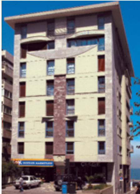
Şekil 4.23 Venüs Apartmanı görünüş ve kat planı, Mimarlar: Erbil Coşkuner ve Sedef Tunçağ, Mithatpaşa Caddesi, 1993, (Terim, 2006).
