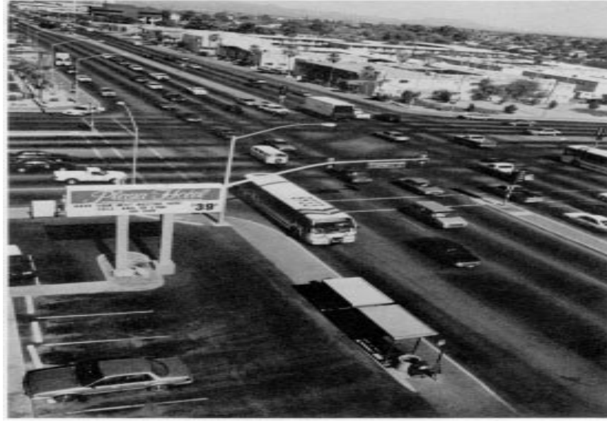
Şekil 3.27 Kuyruk atlatmalı durak örneği (TCRP, 1996).
