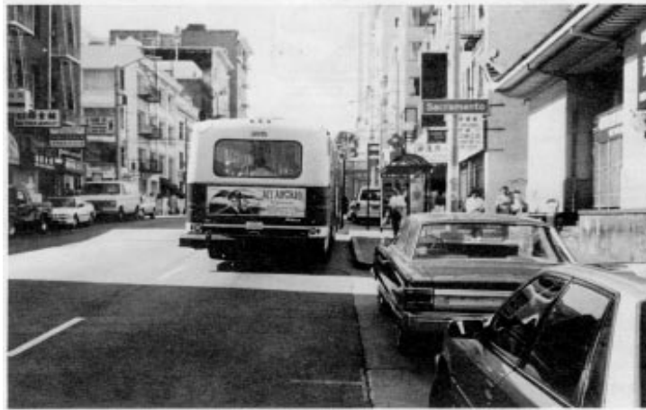
Şekil 3.28 Ters cepli durak uygulaması (TCRP, 1996).
