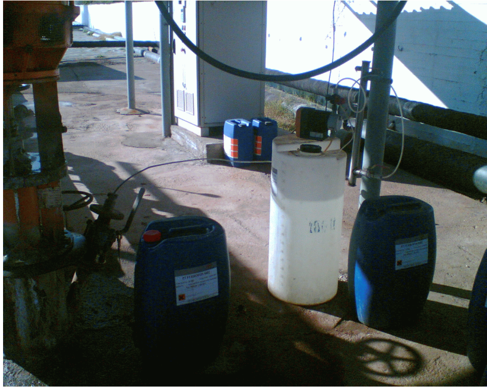
Şekil 5.12 İnhibitör dozaj sistemi ve kuyu başı donanımı
