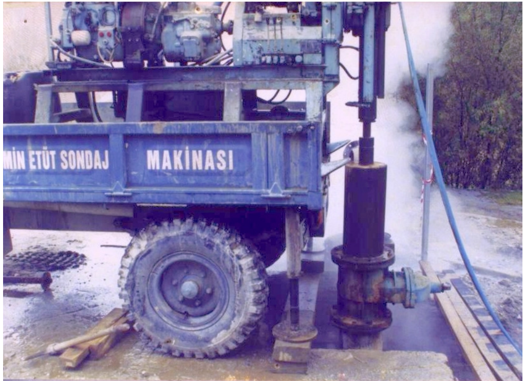
Şekil 5.14 K2 Kuyusunda mekanik temizleme ve asitleme işlemi
