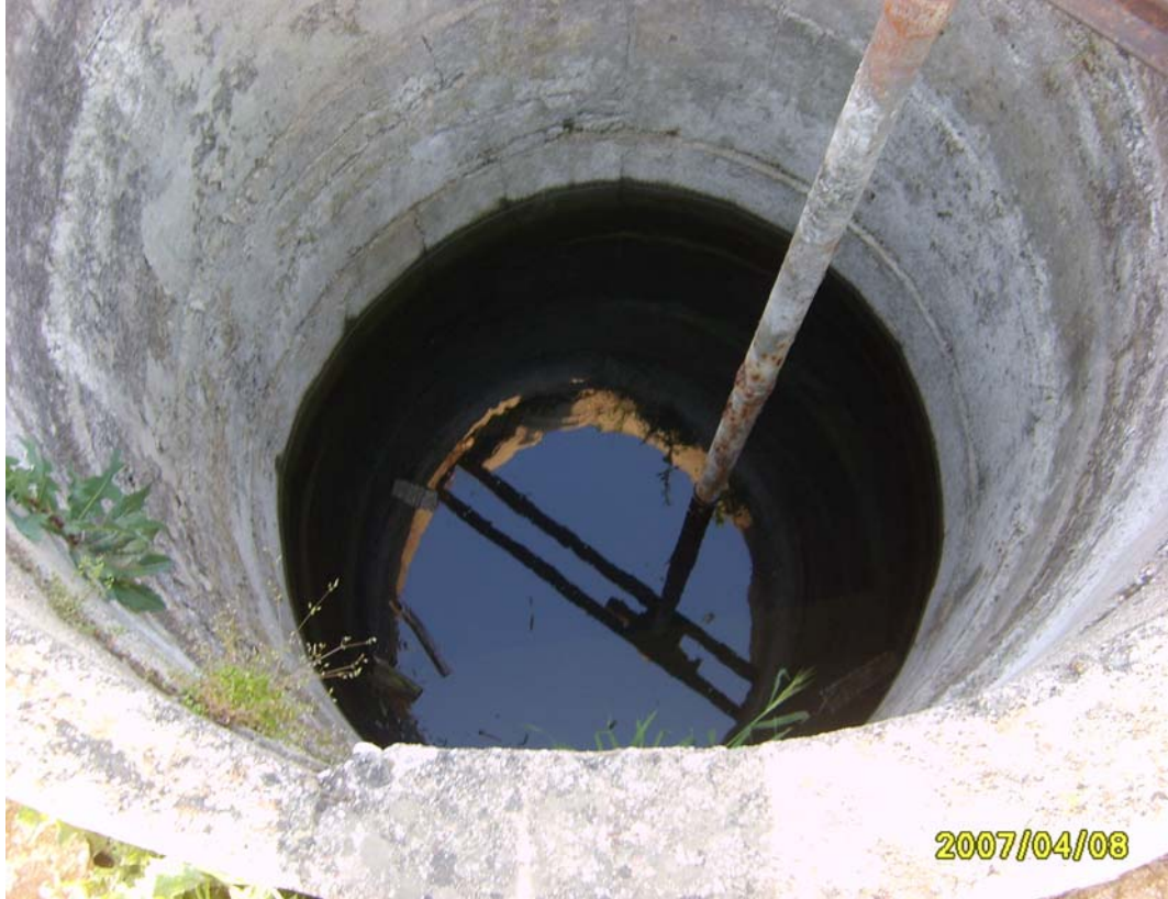
Şekil 3.2 Beton dökme tipi sığ kuyu.
