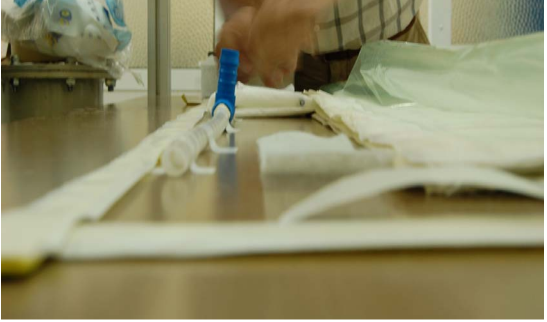
Şekil 3.13 Vakum hattına ait spiral borunun T boru ve havalandırıcı kumaş ile vakum bölgesine yapıştırılması
