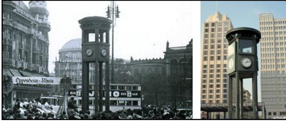
Şekil 4.4 Ampul Kulesi, eski ve günümüzdeki görünüşü
