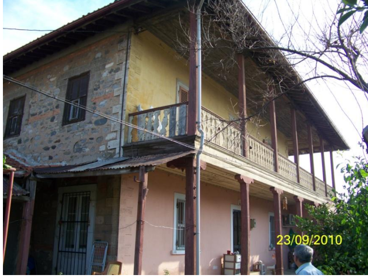
Şekil 4.224 İstasyon şefi lojmanı dış görünüşü, Nazilli yerleşkesi, 2010.
