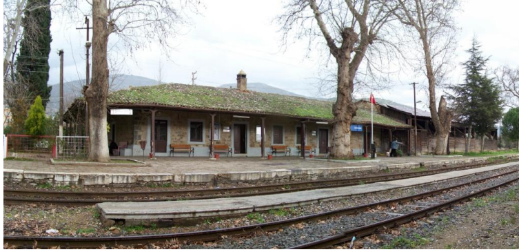
Şekil 4.113 Yolcu bekleme/idare yapısı ve ürün depolama yapısı, Bayındır yerleşkesi, , 2010.
