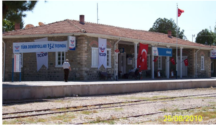
Şekil 4.105 Yolcu bekleme/idare yapısı, Dinar yerleşkesi, 2010.
