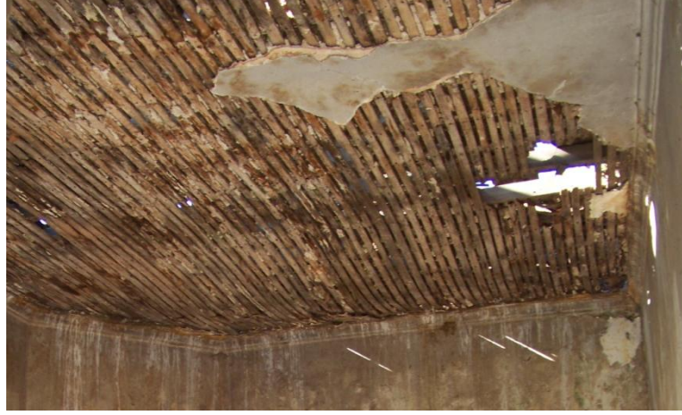
Şekil 4.186 Bağdadi çıta üzeri sıva kaplama tavan, Şamlı (Üzerlik) yerleşkesi, 2010.
