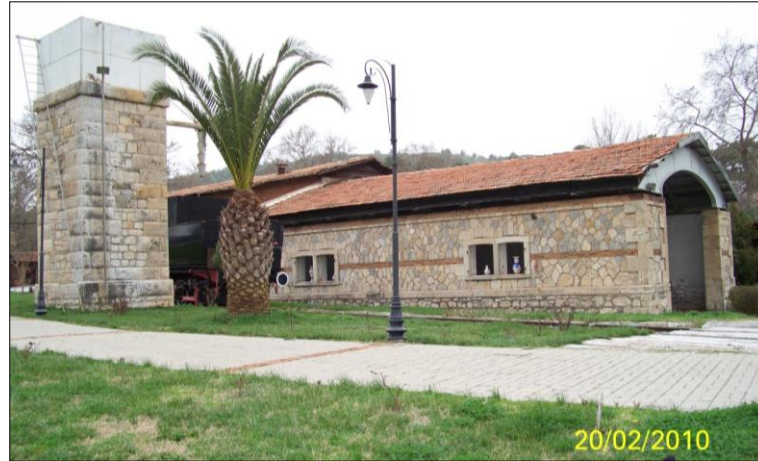
Şekil 4.244 Teknik bakım yapısı günümüzdeki durumu, Aziziye (Çamlık), 2010.
