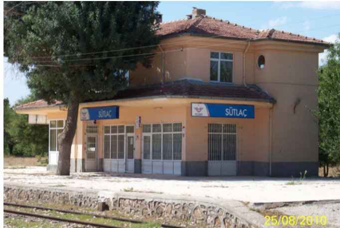
Şekil 4.104 Yenilenmiş olan yolcu bekleme/idare/ikamet (istasyon şefi lojmanı) yapısı, Sütlaç yerleşkesi, 2010.
