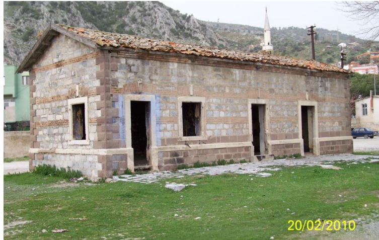
Şekil 4.126 Yolcu bekleme/idare yapısı, Kemer yerleşkesi, 2010.
