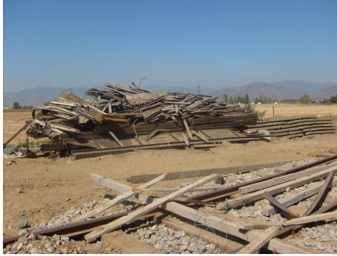
Şekil 5.72 Söküldükten sonra hurda halindeki çelik köprü kirişleri- TCDD 3.Bölge Köprü Birimi Arşivi.
