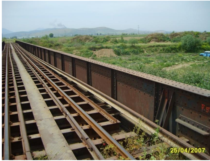
Şekil 5.74 89.km Tire köprüsünün yenilenmeden önceki durumu – TCDD 3.Bölge Köprü Birimi Arşivi.
