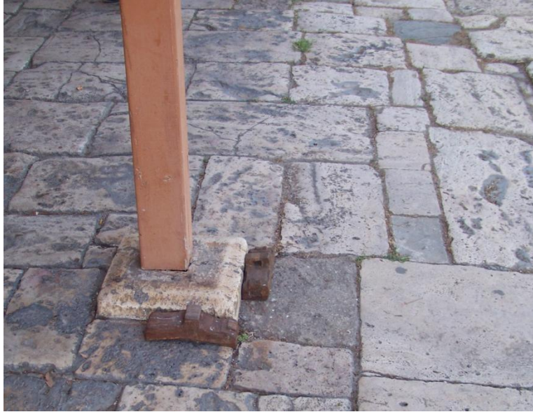
Şekil 4.185 Sundurma altı yer döşemesi, Goncalı yerleşkesi, 2010.
