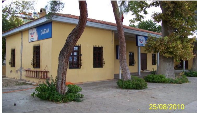
Şekil 4.98 Yolcu bekleme/idare yapısı, Çardak yerleşkesi, 2010.
