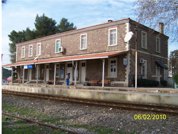
Şekil 4.25 Yolcu bekleme/idare/ikamet yapısı, Kabas (Pancar) yerleşkesi, 2010.
