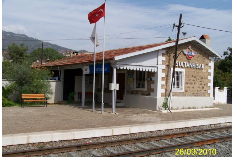
Şekil 4.66 Yolcu bekleme/idare yapısı, Sultanhisar yerleşkesi, 2010.
