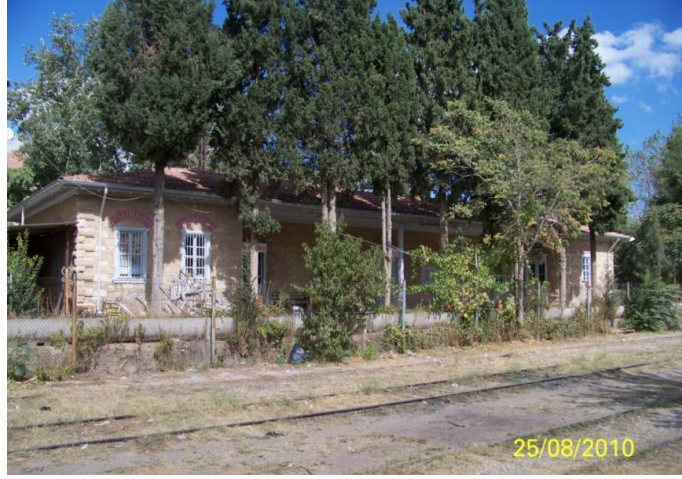
Şekil 5.81 Atıl durumdaki yolcu bekleme/idare yapısı, Çivril yerleşkesi, 2010.
