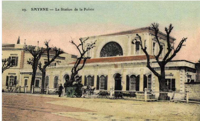
Şekil 5.93 Alsancak Garı önündeki isstasyon kahvesi, APİKAM arşivi.
