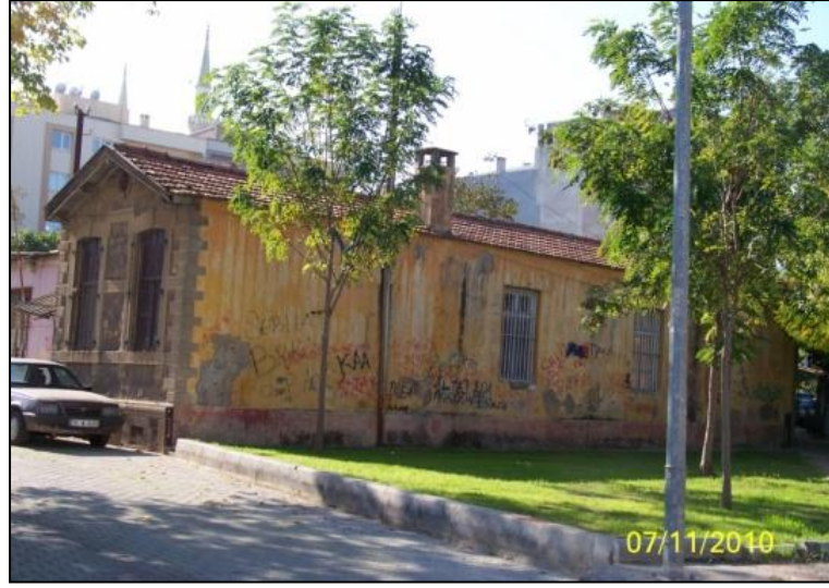
Şekil 4.159 Yolcu bekleme/idare yapısı, Seydiköy Yerleşkesi, 2010.
