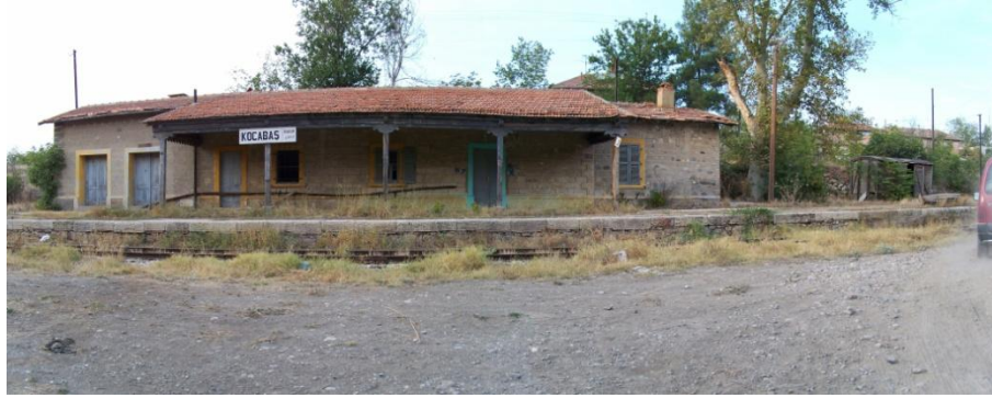
Şekil 4.91 Yolcu bekleme/idare ve ikamet yapısı, Kocabaş yerleşkesi, 2010.
