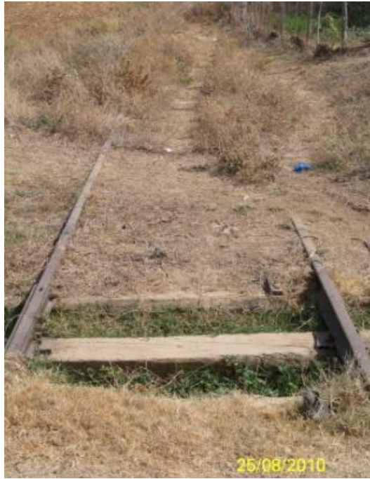
Şekil 4.136 Kısmen yok olmuş demiryolu hattı, Sundurlu yerleşkesi 2010.
