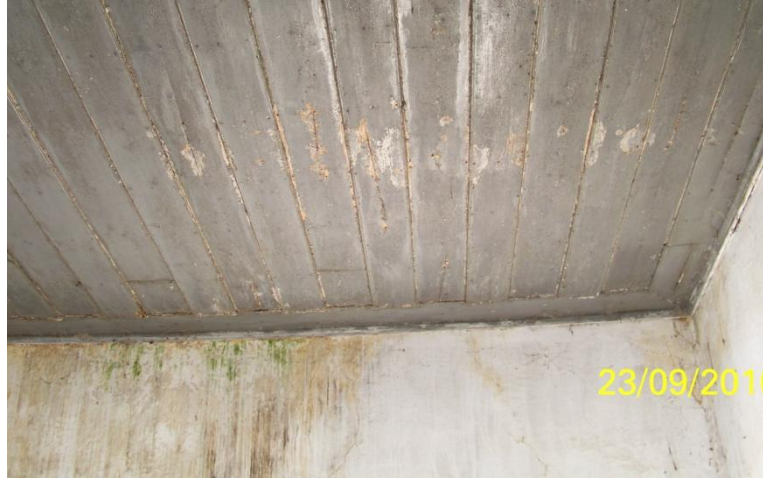
Şekil 4.187 Pasalı ahşap tavan kaplaması, Kozpınar yerleşkesi, 2010.
