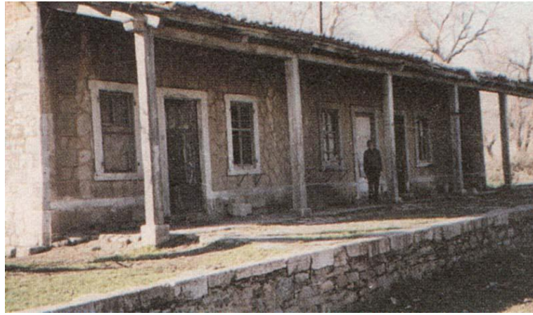
Şekil 4.34 Yolcu bekleme/idare yapısı, Kozpınar yerleşkesi, http://www.modeltreciler.com/site/content/view/95/9/ .
