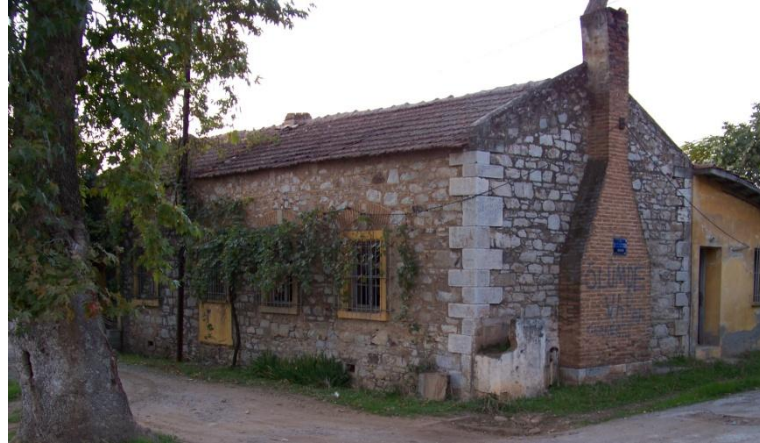
Şekil 4.228 İşçi yatakhaneleri, Arıkbaşı yerleşkesi, 2011.
