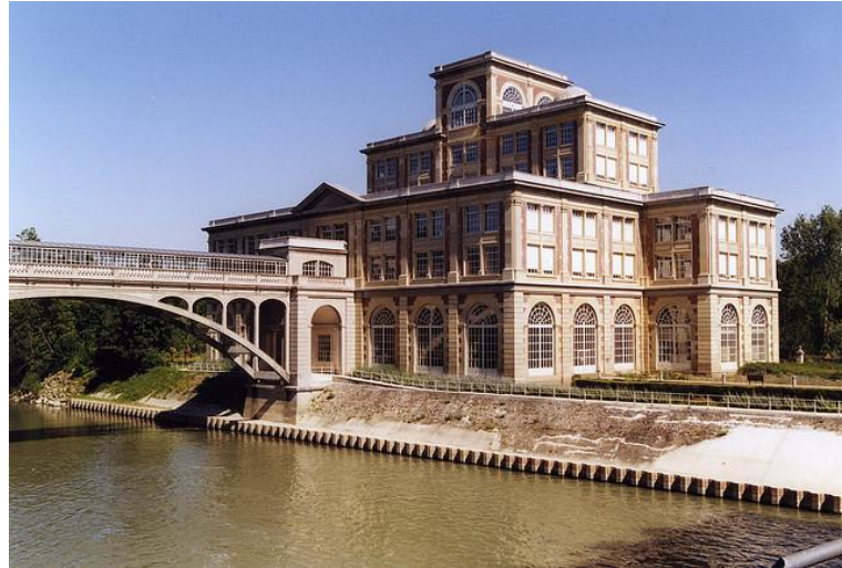
Şekil 2.3 Noisel- Nestle Genel Müdürlük binası, http://farm4.staticflickr.com
