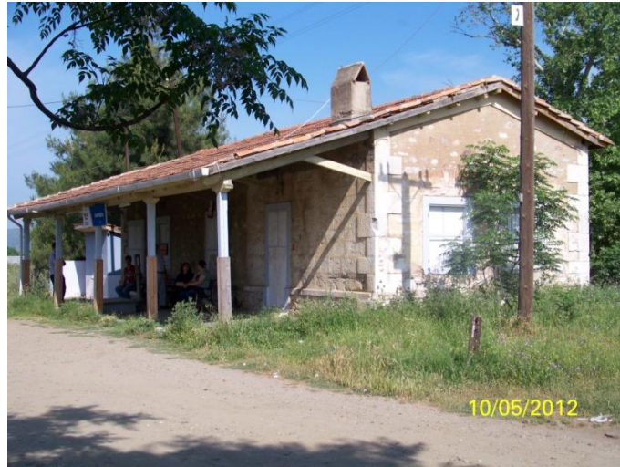
Şekil 4.111 Yolcu bekleme/ idare yapısı, Çaylak yerleşkesi, 2012.
