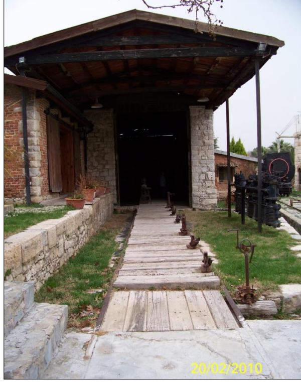
Şekil 4.246 Teknik bakım yapısı günümüzdeki durumu, Aziziye (Çamlık) Yerleşkesi, 2010.
