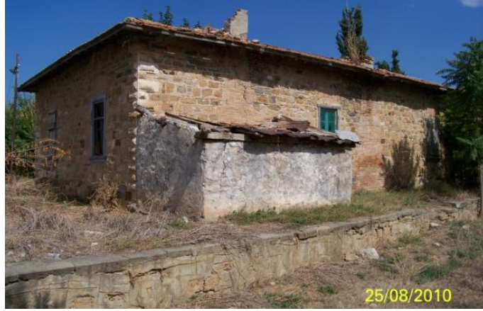
Şekil 4.135 Yolcu bekleme/idare yapısı, Sundurlu yerleşkesi, 2010.
