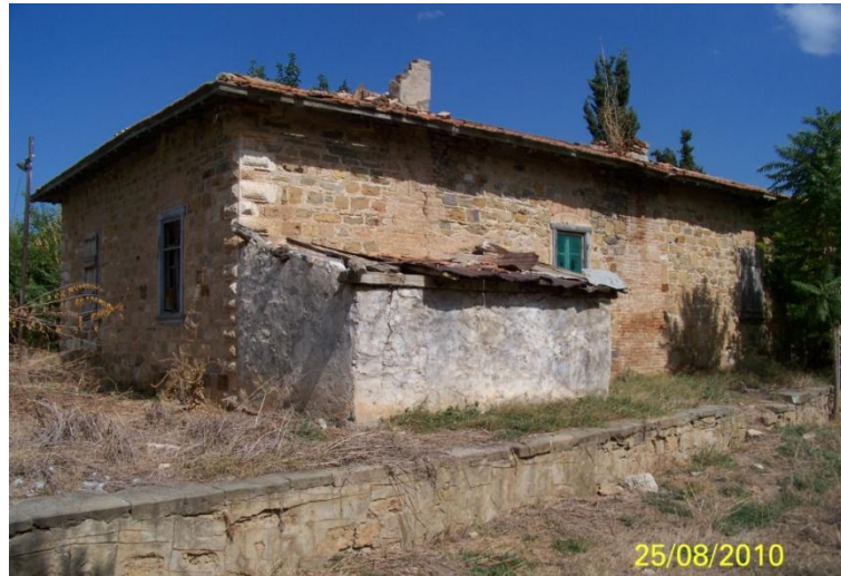
Şekil 5.69 Atıl durumdaki yolcu bekleme ve idare yapısı, Sundurlu Yerleşkesi, 2010.
