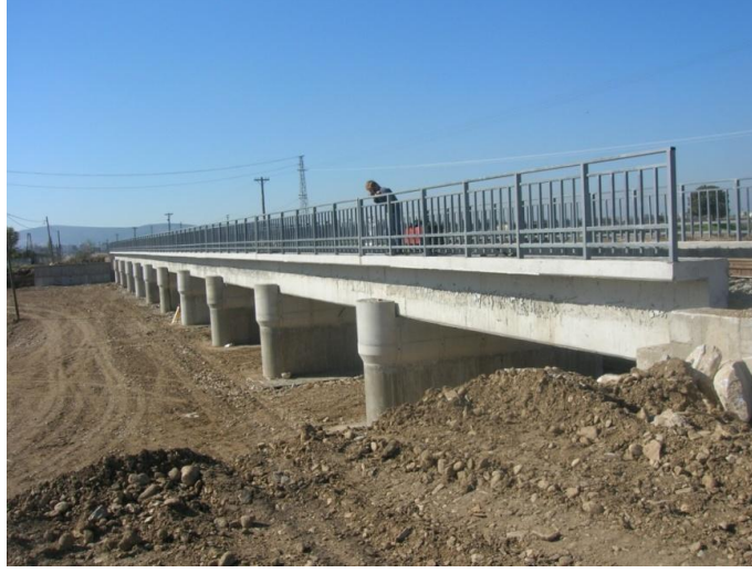
Şekil 5.75 Betonarme olarak yenilenen 89.km Tire köprüsü-TCDD 3.Bölge Köprü Birimi Arşivi.
