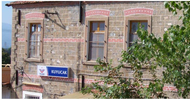
Şekil 4.176 Moloz taş üzerine uygulanmış olan kabartma derzli kesme taş görünümlü sıva, Kuyucak Yerleşkesi.
