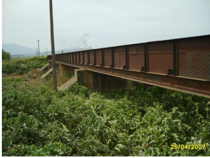
Şekil 5.73 89.km Tire köprüsünün yenilenmeden önceki durumu- TCDD 3.Bölge Köprü Birimi Arşivi.
