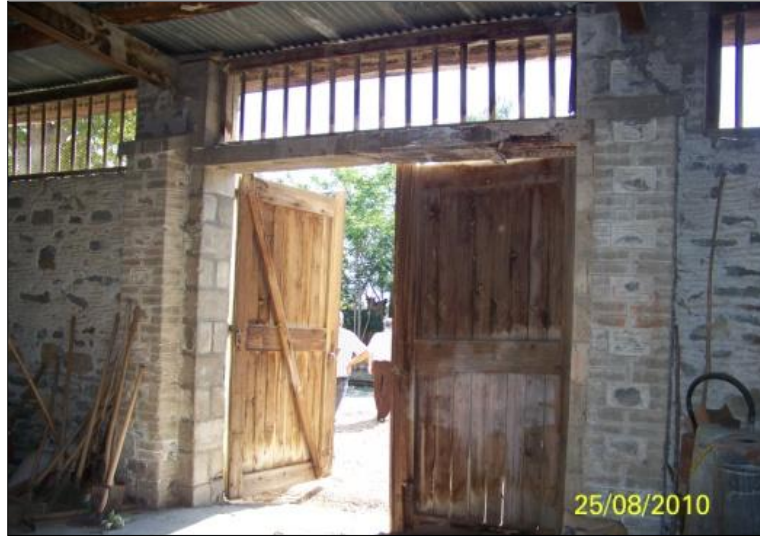
Şekil 4.202 Kapalı depolama yapısı tip giriş kapısı, Apa Yerleşkesi, 2010.
