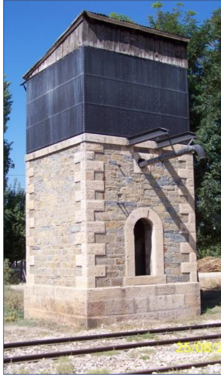
Şekil 4.196 Kâgir su deposu, Gancalı Yerleşkesi, 2010.
