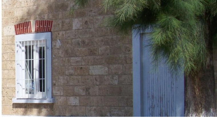
Şekil 4.177 Kesme taş kaplama, Sarayköy yerleşkesi.
