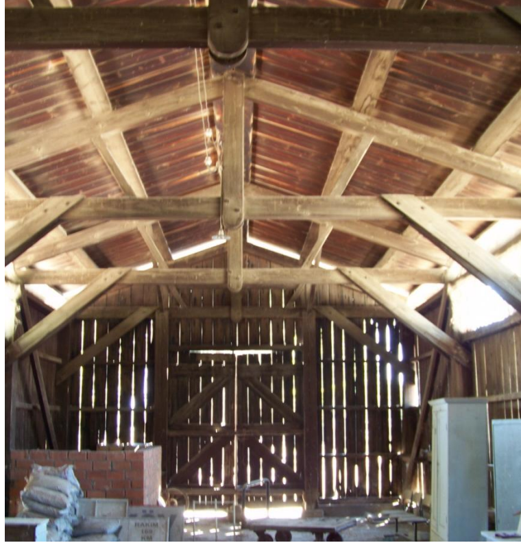
Şekil 4.205 Paketleme-depolama birlikteliği yapısı iç mekânı Sarayköy yerleşkesi, 2010.
