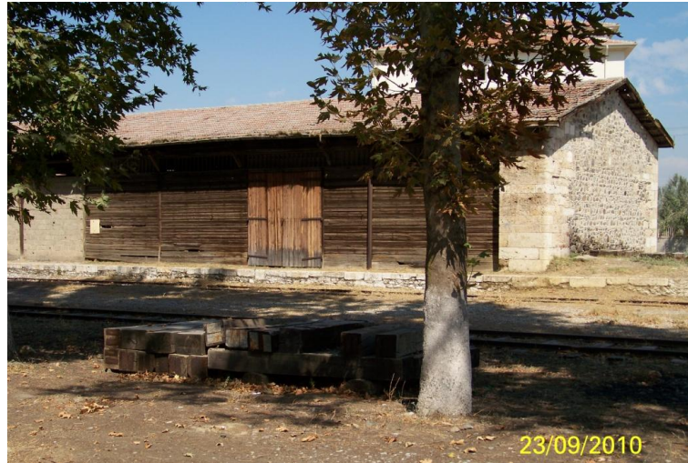
Şekil 4.154 Ürün depolama yapısı, Sarayköy yerleşkesi, 2010.
