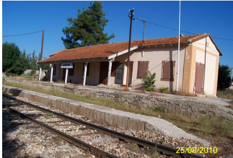
Şekil 4.96 Yolcu bekleme/idare yapısı/ikamet, Hamidiye (Bozkurt) yerleşkesi, 2010.
