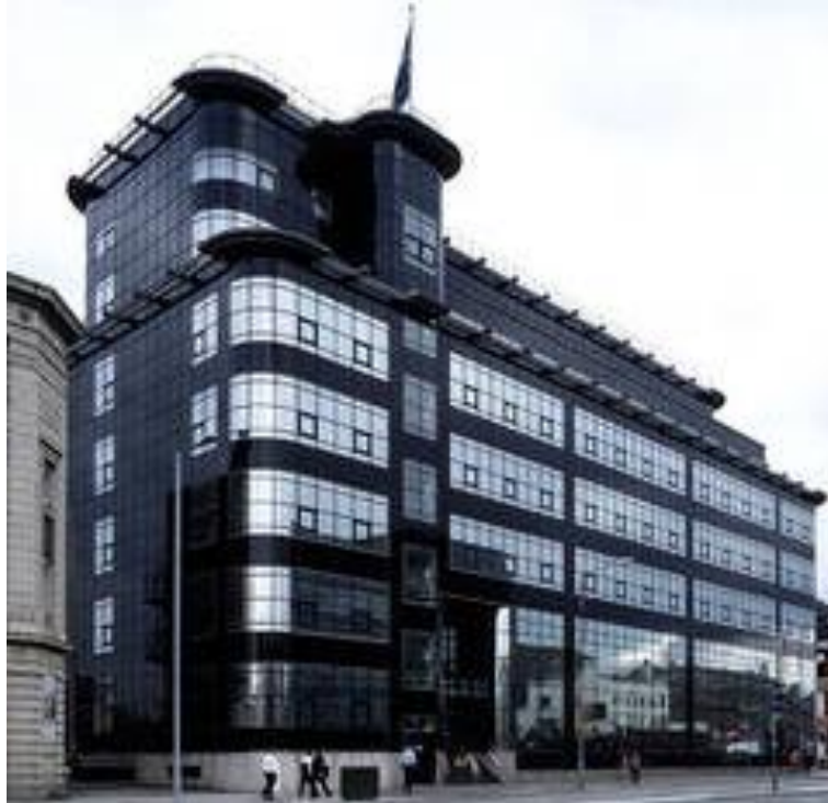
Şekil 2.5 Ofise dönüştürülen Manchester Daily Express matbaa binası, http://www.lookingatbuildings.org.uk
