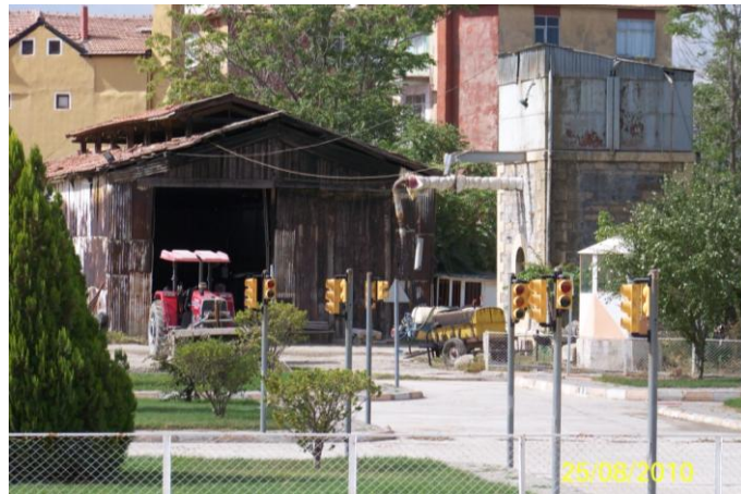
Şekil 4.140 İtfaiye olarak işlevlendirilmiş olan teknik bakım ve su depolama yapısı, Çivril yerleşkesi, 2010.
