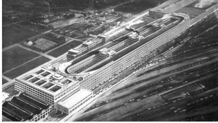
Şekil 2.7 Yeniden işlevlendirme öncesi Fiat Lingotto Tesisleri, Torino, http://en.wikipedia.org
