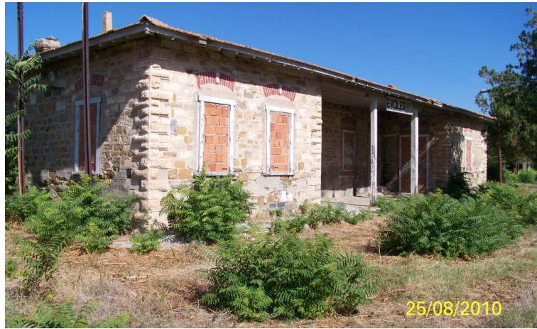
Şekil 4.101 Yolcu bekleme/idare yapısı-ikamet (istasyon şefi lojmanı), Avcılar (Evciler) yerleşkesi 2010.
