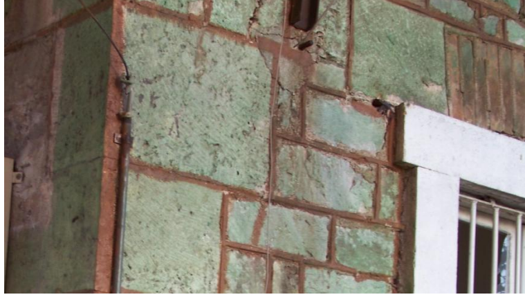
Şekil 4.178 Kesme taş kaplama, Buca yerleşkesi.
