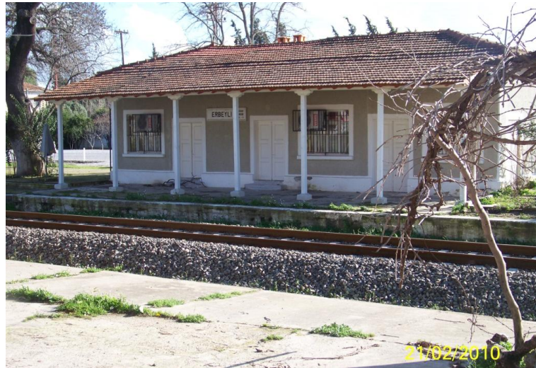
Şekil 4.48 Yolcu bekleme/idare yapısı, Erbeyli yerleşkesi, 2010.
