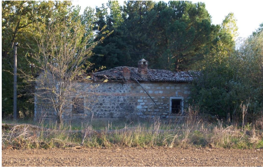
Şekil 4.117 Hacılyas yerleşkesi yolcu bekleme- idare yapısı, 2011.
