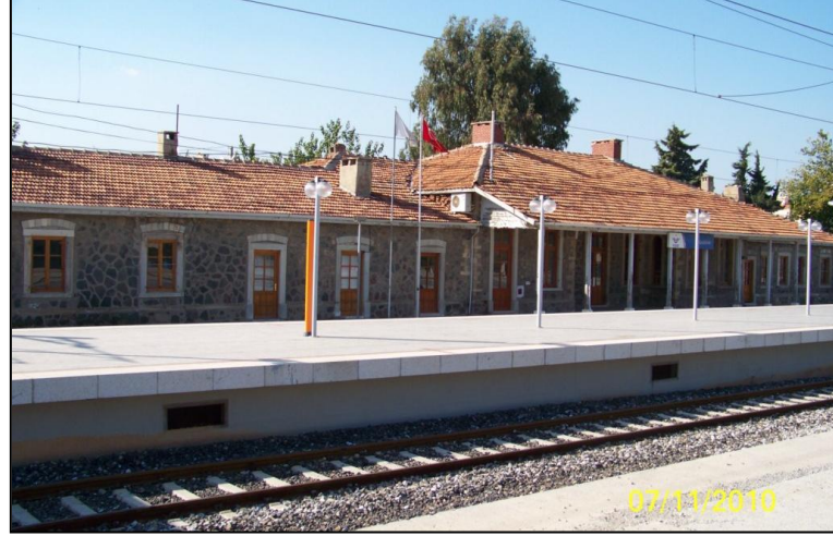
Şekil 4.161 Yolcu bekleme/idare yapısı, Gazimir Yerleşkesi, 2010.
