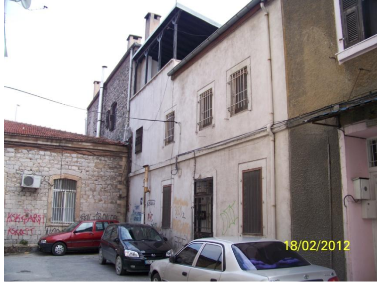
Şekil 4.215 42 no'lu yönetici lojmanı, (servis giriş) batı cephesi, Alsancak, 2012.
