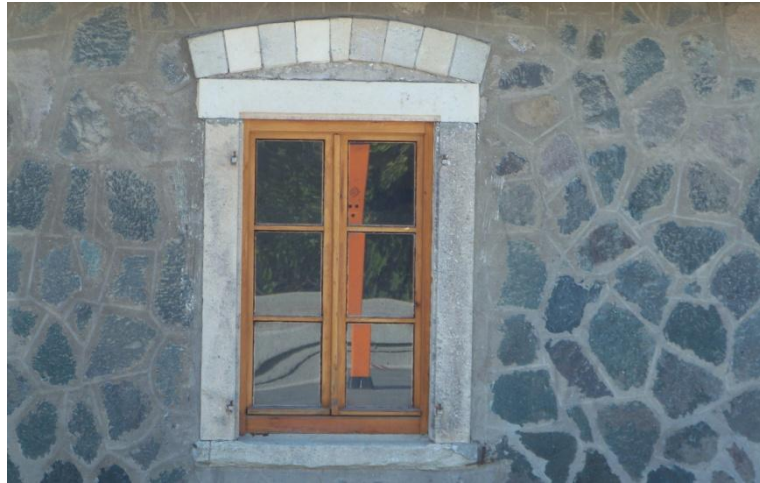
Şekil 4.179 Gaziemir yerleşkesi poligonal taş kaplama.
