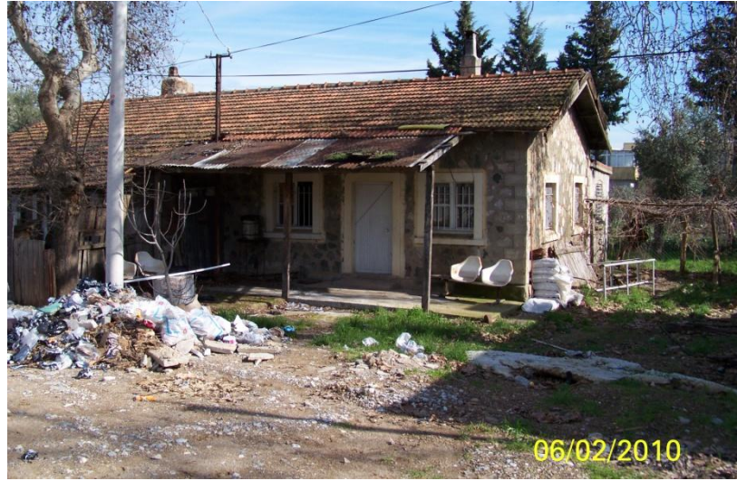
Şekil 4.20 Eski yolcu bekleme yapısı, Cumaovası yerleşkesi, , 2010.
