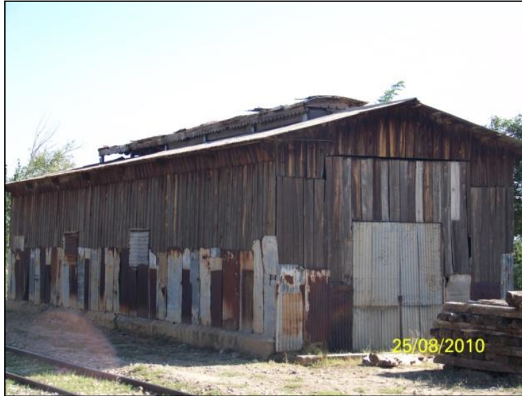
Şekil 4.249 Teknik bakım yapısı, Apa, 2010.
