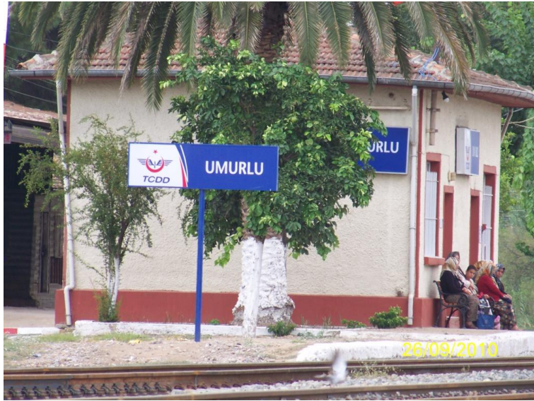
Şekil 4.58 Yeni yolcu bekleme/ idare yapısı, Umurlu yerleşkesi, 2010.
