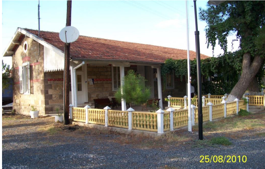
Şekil 4.93 Yolcu bekleme/idare ve ikamet yapısı, Kızılkaplık (Kaklık) yerleşkesi, 2010.
