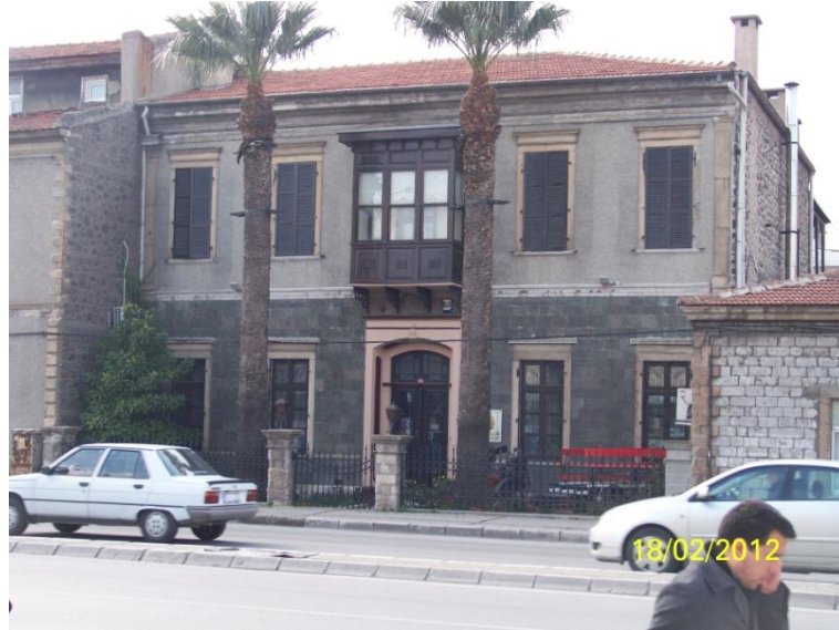
Şekil 4.214 42 no'lu yönetici lojmanı, (ön giriş) kuzey cephesi, Alsancak, 2012.
