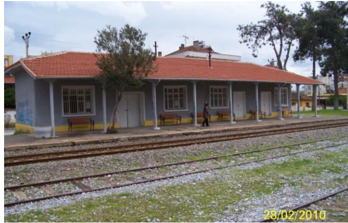
Şekil 4.31 Yolcu bekleme/idare- ikamet (istasyon şefi) yapısı, Tepeköy yerleşkesi, 2010.
