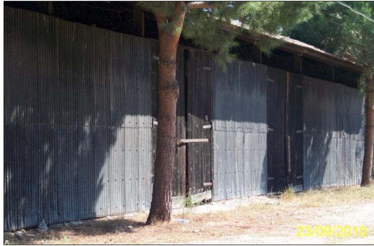
Şekil 4.203 Kapalı depolama yapısı, Burhaniye (Buharkent) Yerleşkesi, 2010.
