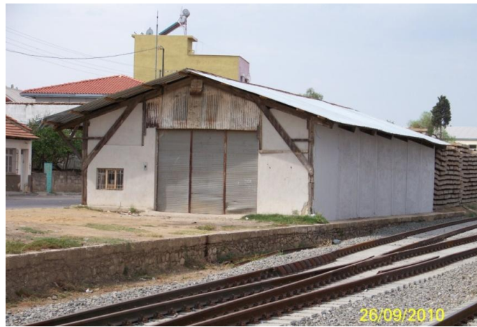
Şekil 5.86 Niteliksiz malzeme ile kapatılmış yarı açık depolama yapısı, Köşk yerleşkesi, 2010.
