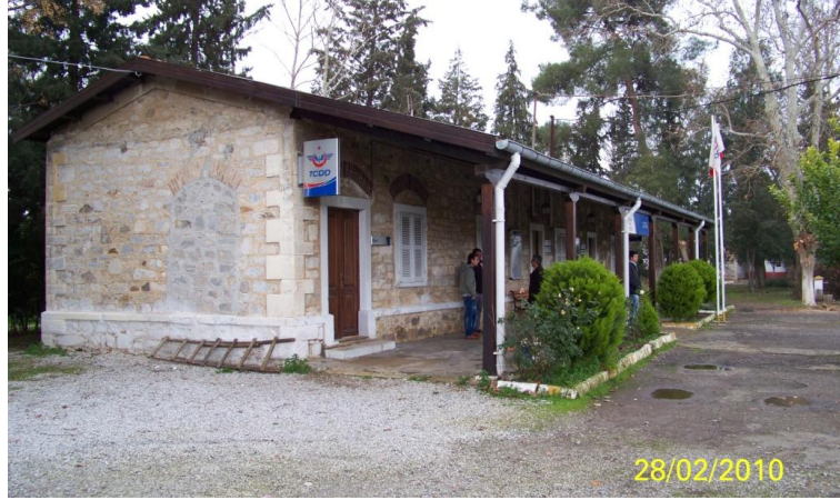
Şekil 4.115 Yolcu bekleme/idare-ikamet yapısı, Çatal yerleşkesi, 2010.
