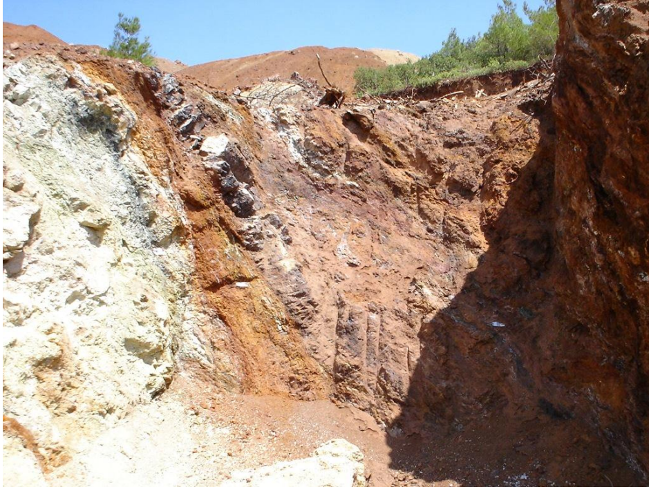
Şekil 3.7 Laterit–serpantinit dokanağında sıkışmaya bağlı ezilmeler, Güney Ocak
