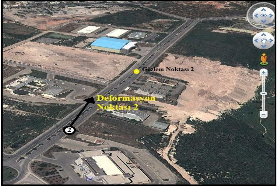
Şekil 3.3 DN-2'nin Tınaztepe kampüs üzerindeki konumuna ait uydu görüntüsü.
