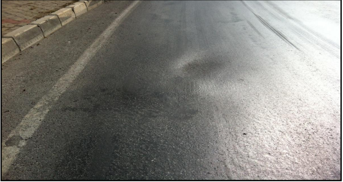
Şekil 5.2 Ondülasyon ve çökme oluşumu (İzmir çevreyolu Buca girişi).
