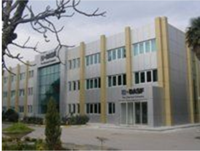
Şekil 3.9 BASF yönetim binası ( http://www.cedbik.org/ )
