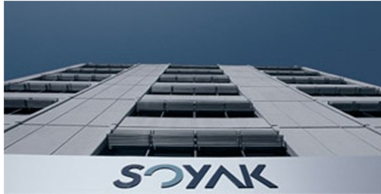
Şekil 3.15 Soyak Holding merkez binası
