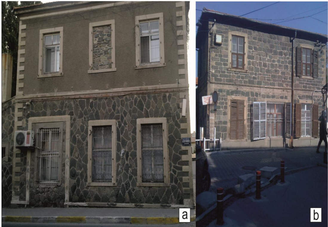
Şekil 1.3 Buca ilçesinde Uğur Mumcu Caddesi'nde yer alan dış cephesi yeşil andezitlerle kaplanmış bir Levanten evi (a), Alsancak Garı yanında yer alan tarihi bina (b).
