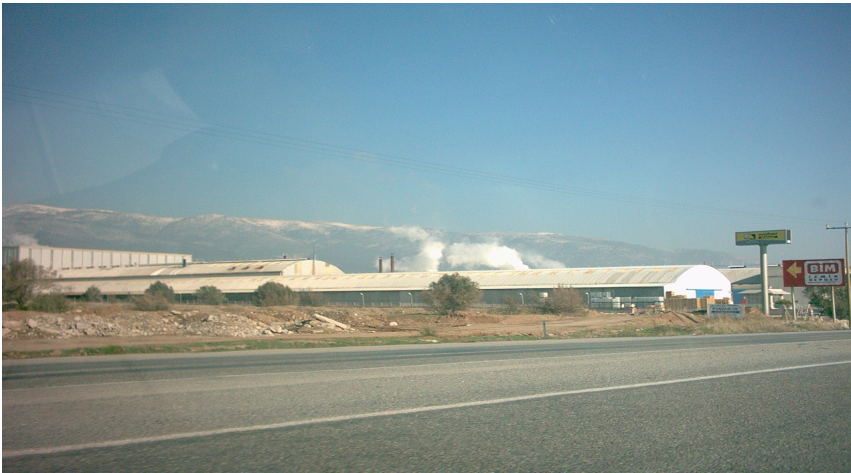
Şekil 108: Sanayi tesislerince filtrenmeden ortama bırakılan fabrika baca gazları.
