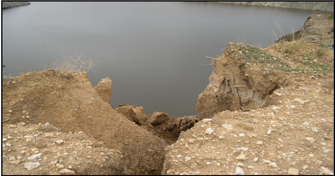
Foto 3: Bağıyaka Hafriyat Sahası Yarıkları-Heyelan Risk Alanı (Su yüzeyinden çukurlukların kenarına kadarki yükseklik 5 m'dir.)
