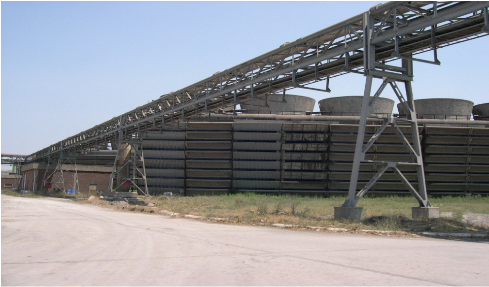
Foto 11: Kmr Bandı ve Soğutma Kuleleri
