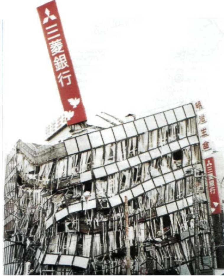
Resim-19 Kobe (Japonya) depreminde hasar gören yüksek bir bina
