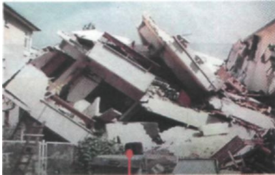
Resim-7 “Yapılar üzerindeki yıkıcılık ve hasar, depremin en önemli etkileridir” ifadesi eklenmiştir ve yıkımdan sadece deprem sorumlu tutulmuştur, böylelikle hasarın faturası sadece depreme çıkarılmıştır.
