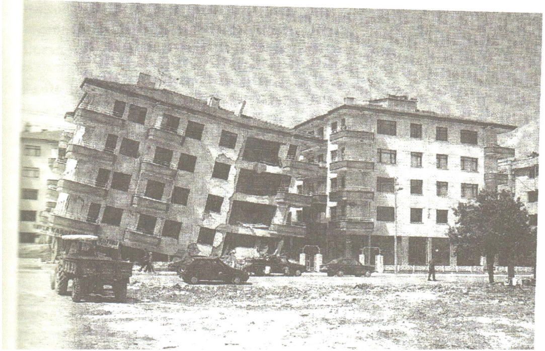
Re sim-2 Alüviyal topraklarda inşa edilen ve/veya depreme uygun inşa edilmemiş binaların akıbeti (Atalay ve diğerleri, 2006)
