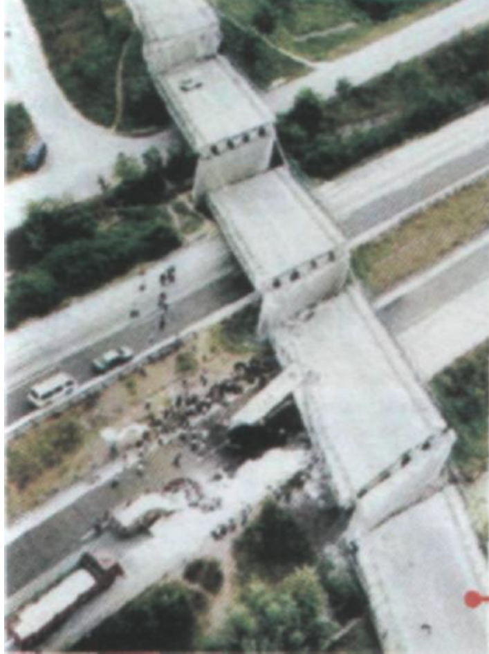
Resim-5 “17 Ağustos 1999 Marmara depreminden sonra Arifiye'den bir görünüm. (Sakarya) Magnitüd: 7,4”
