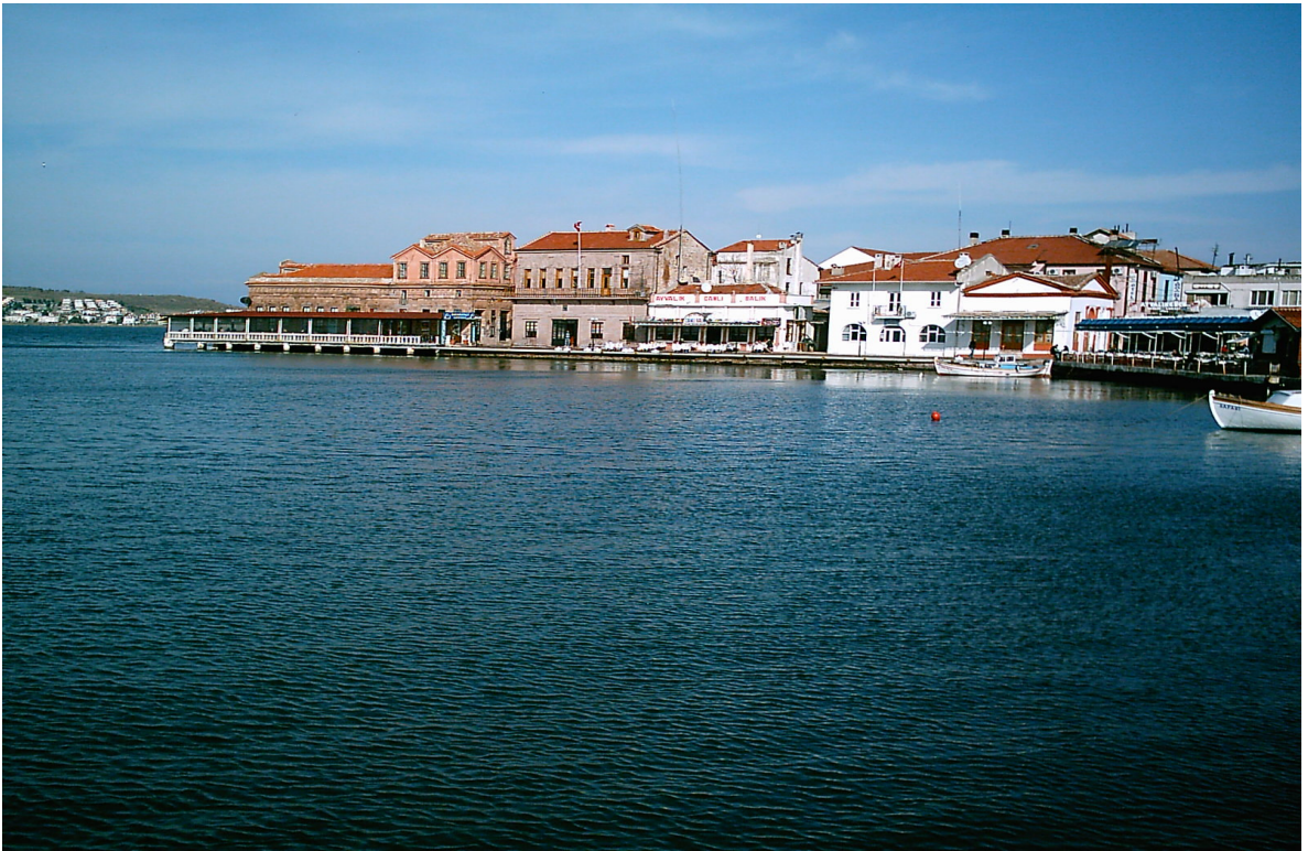
Ayvalık Belediyesi Binası ve Kahveler- Günümüzde Aynı Şekilde Muhafaza Edilmektedir
