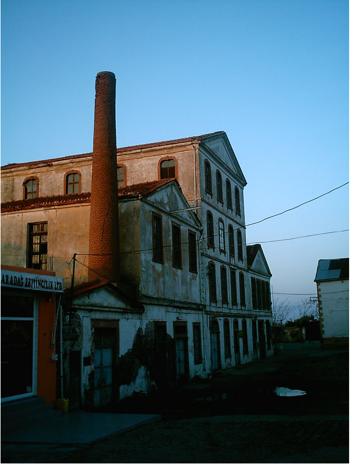
19. Yüzyıla Ait Zeytinyağı Fabrikası
