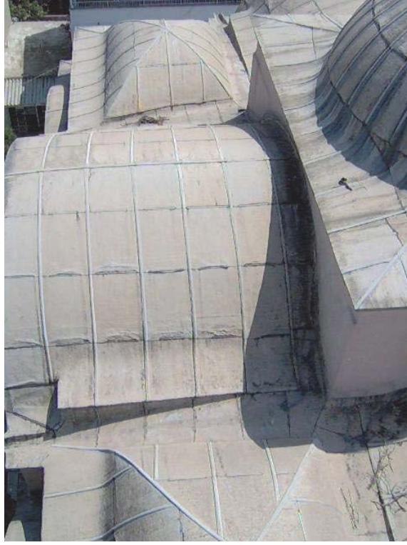
45. Resim: Koca Camii , Üst Örtü Sistemi
