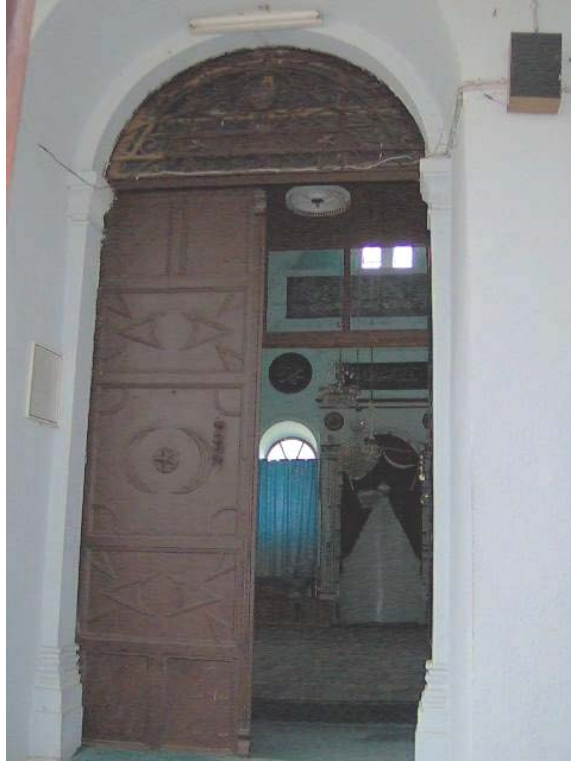
86. Resim: Hacı Ahmed Camii , Kuzey Girişi
