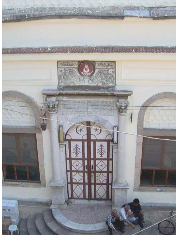
52. Resim: Koca Camii , Batı Giriş Kapısı
