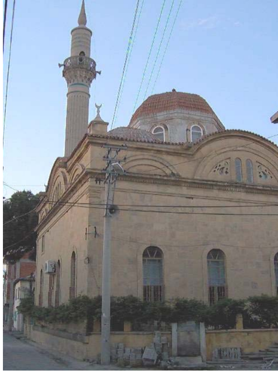
71. Resim: Hacı Ahmed Camii , Güneybatıdan Genel Görünüş
