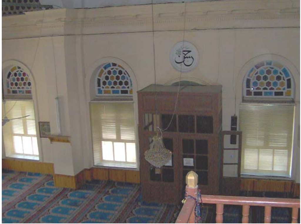
61. Resim: Koca Camii , Harim Batı Duvarı
