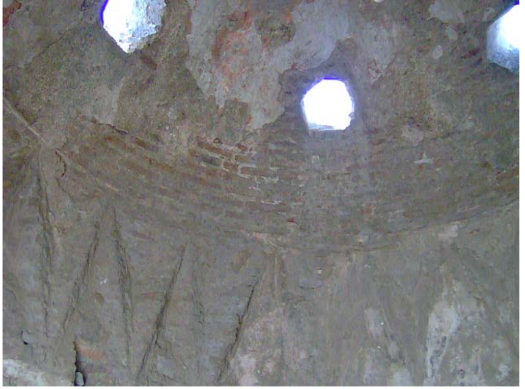
219. Resim: Burhaniye Hamamı , Kuzeydeki Halvetin Kubbesi ve Geçiřleri
