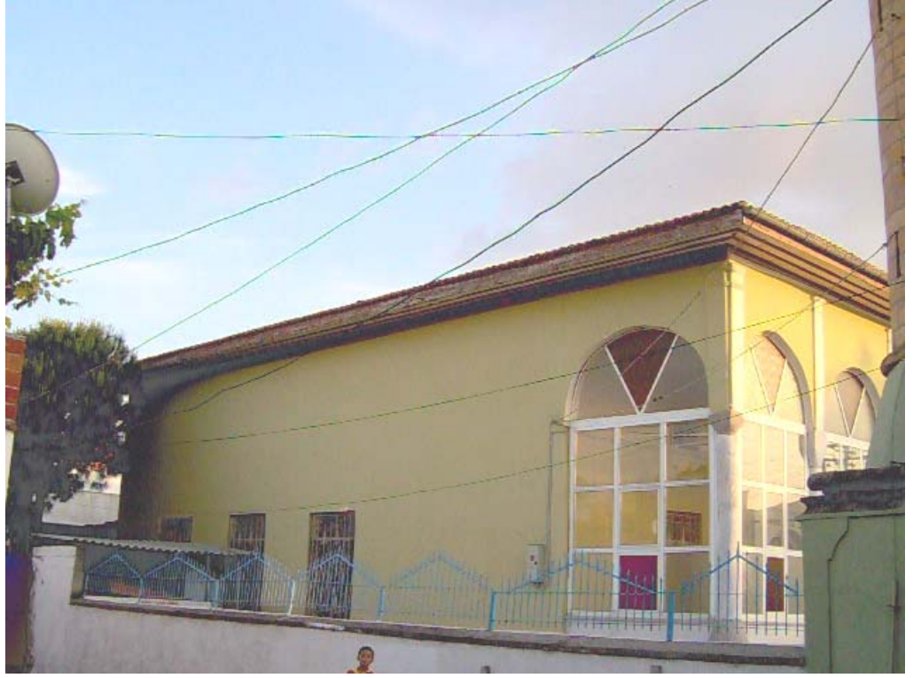
25. Resim: Hasan Ağa Camii , Doğu Cephe
