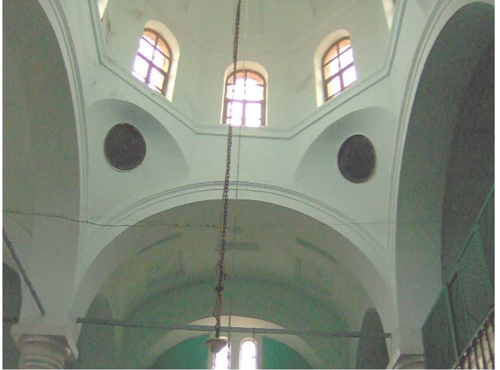
82. Resim: Hacı Ahmed Camii , Kubbe Geçişleri
