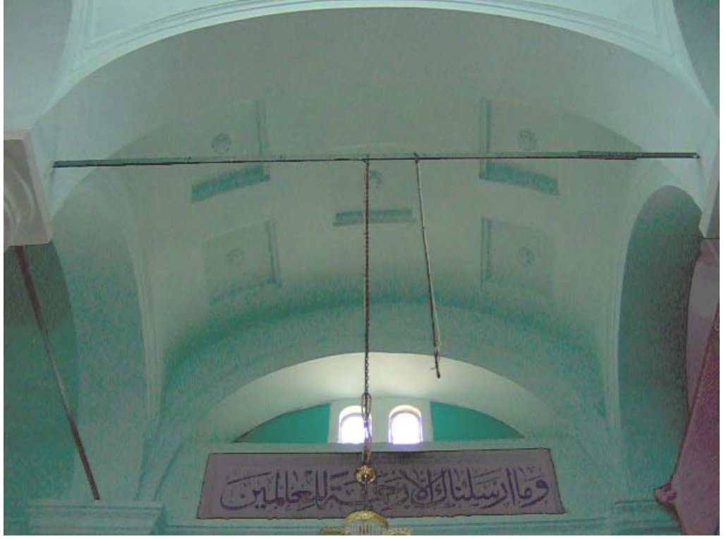
83. Resim: Hacı Ahmed Camii , Kasetli Beşik Tonoz Örtüsü
