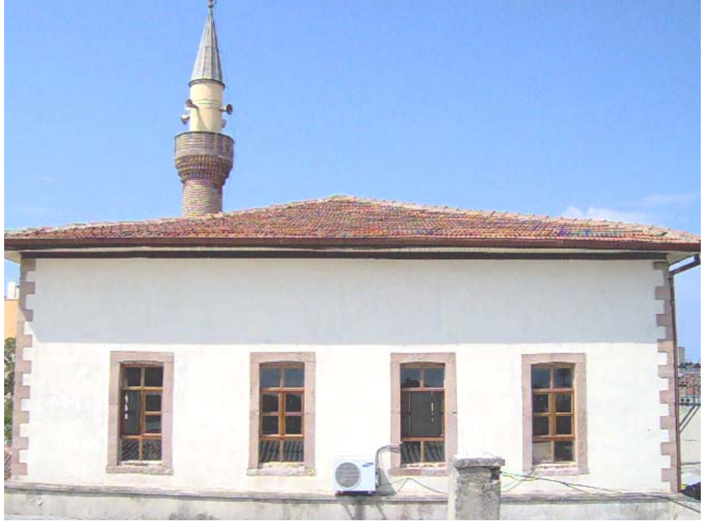
5. Resim: Hanay Camii , Dođu Cephe
