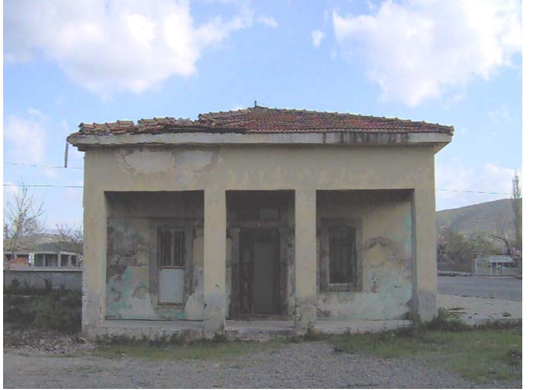
174. Resim: İskele Camii , Kuzey Cephe
