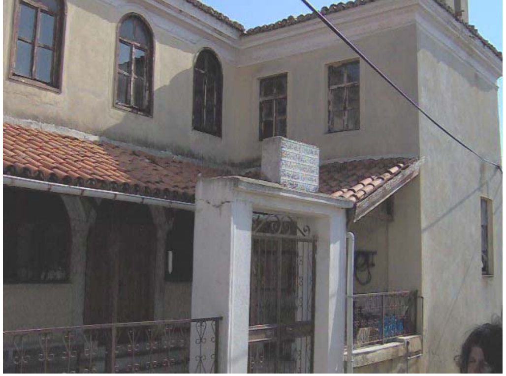
103. Resim: Şahinler Köyü Camii , Avlu, Avlu Girişi ve Son Cemaat Yeri
