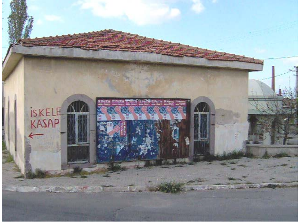
171. Resim: İskele Camii, Güney Cephe
