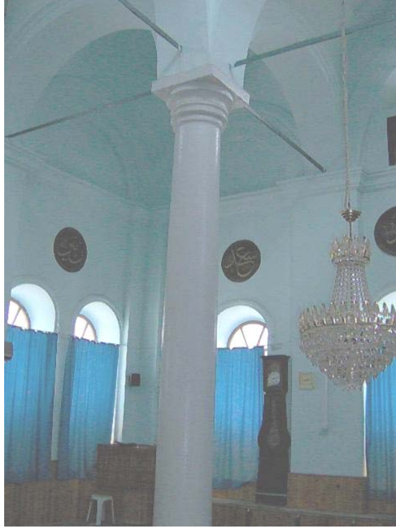
85. Resim: Hacı Ahmed Camii , Duvar Saçakları Üzerine Oturan Kemer Ayakları
