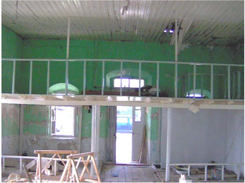
176. Resim: İskele Camii , Harim Kuzey Duvar
