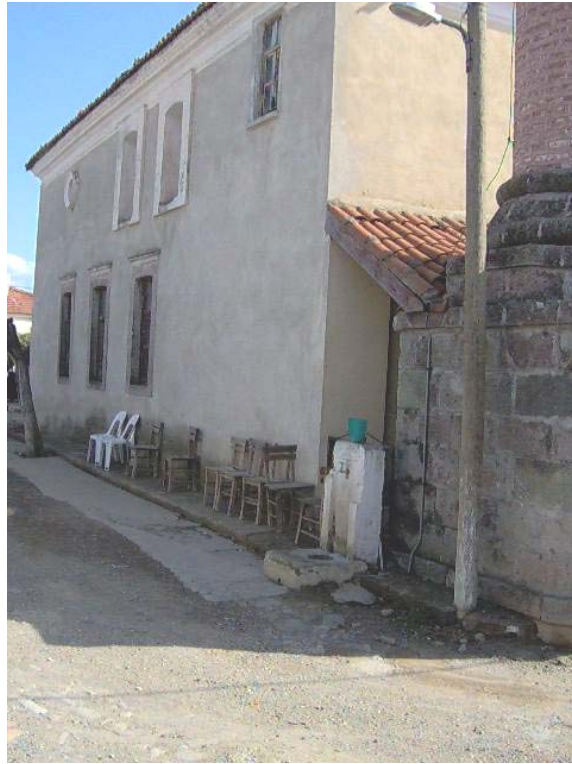
98. Resim: Şahinler Koyü Camii , Doğu Cephe
