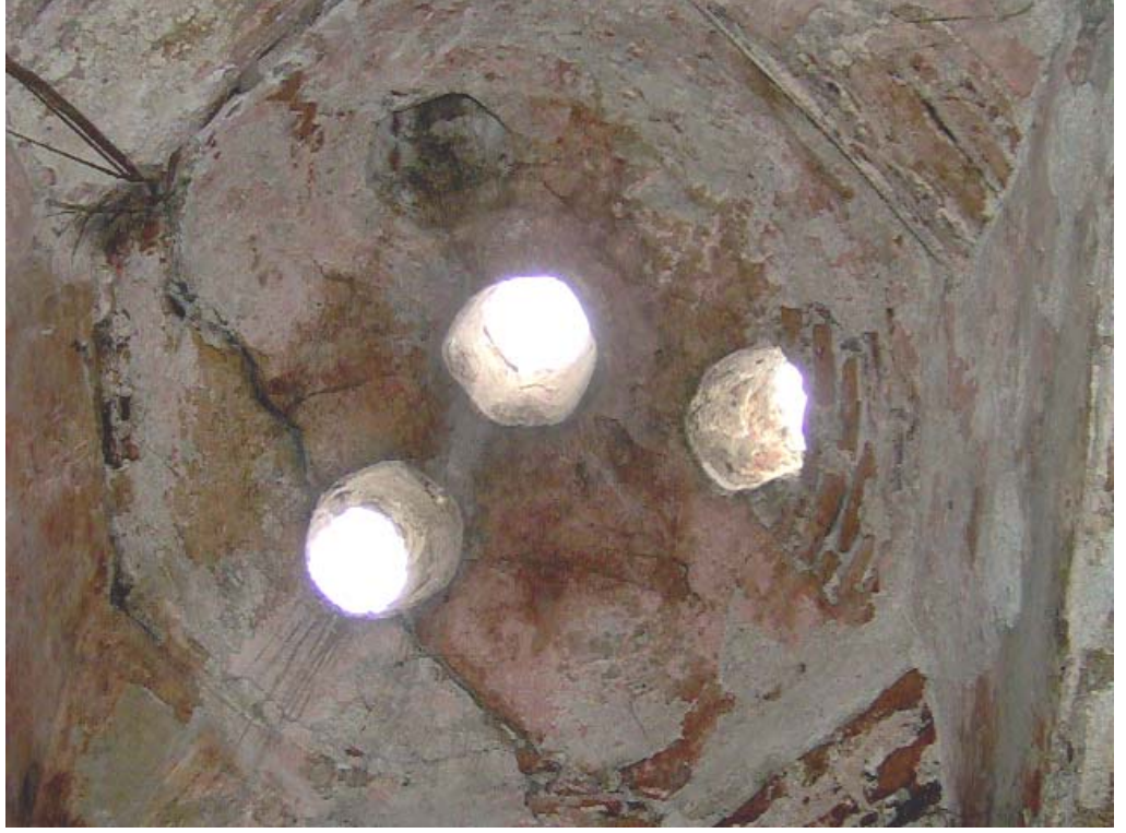
213. Resim: Burhaniye Hamamı , Ilıklık, Güneydeki Dikdörtgen Kısmı Örtün Kubbe
