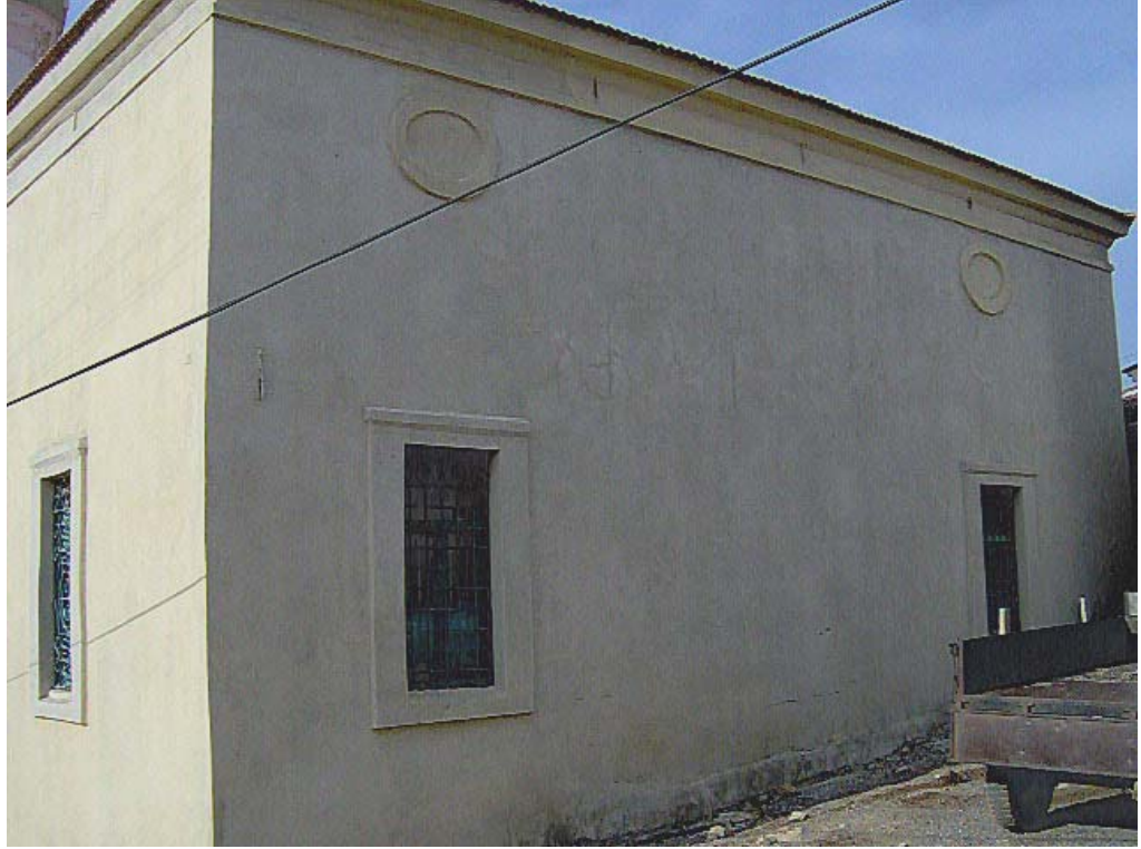
181. Resim: Ağacık Camii, Güney Cephe
