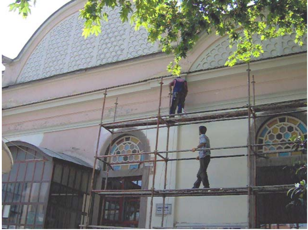
51. Resim: Koca Camii , Kuzey Cephe
