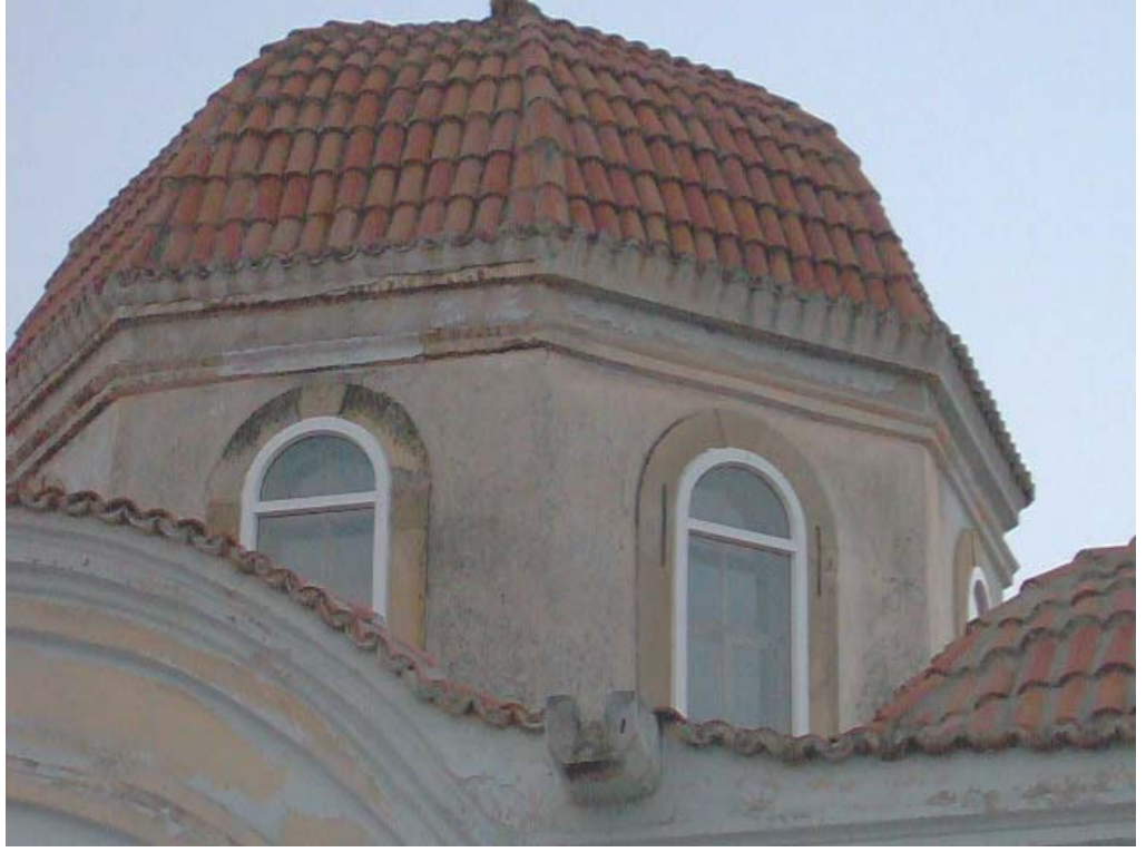
75. Resim: Hacı Ahmed Camii , Kubbe ve Kasnağı Dolaşan Silmeler
