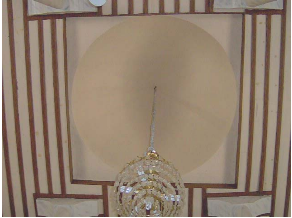
33. Resim: Hasan Ağa Camii , Ahşap Bağdadi Kubbesi
