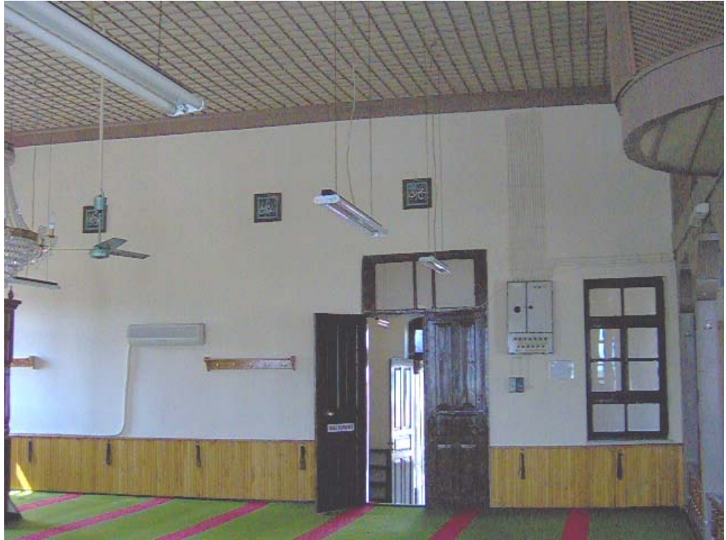
12. Resim Hanay Camii , Harim Kuzey Duvarı
