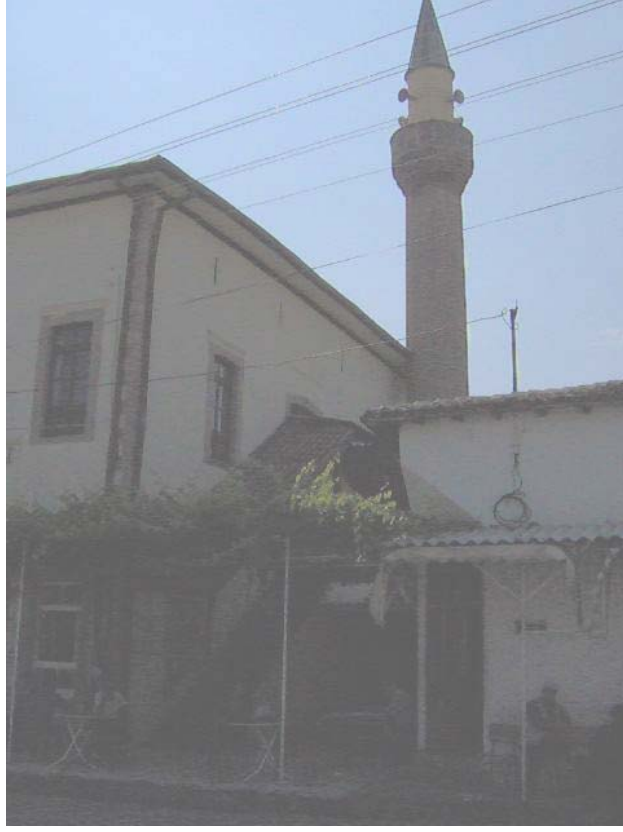
7. Resim: Hanay Camii , Batı Cephe
