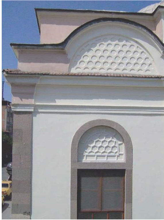
46. Resim: Koca Camii , Saçak ve Silme Tertibi
