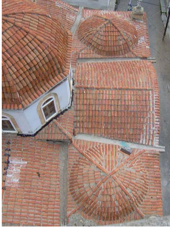
73. Resim: Hacı Ahmed Camii , Üst Örtü Sistemi
