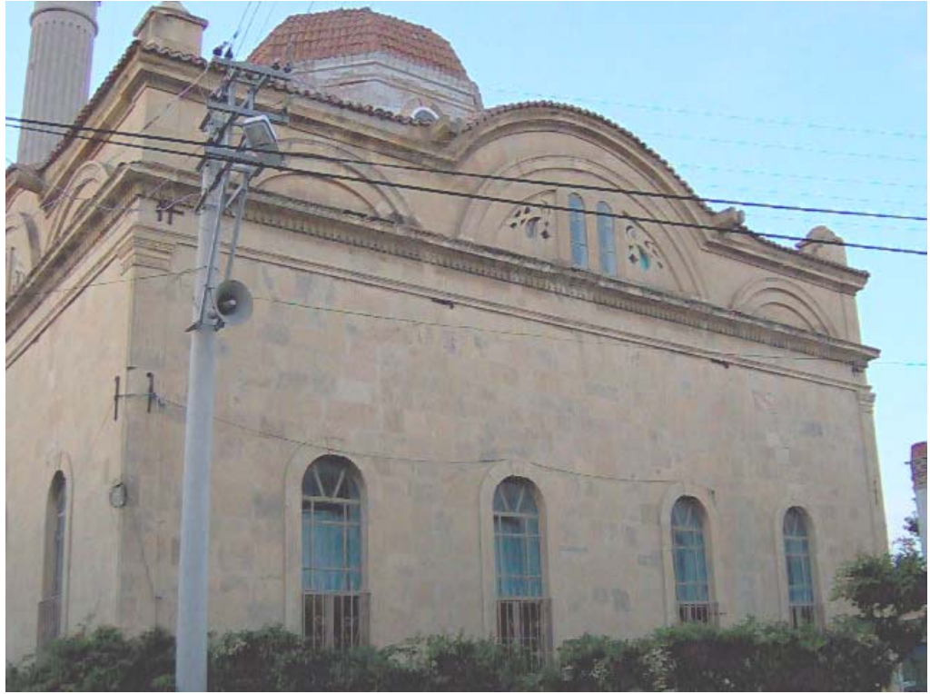
74. Resim: Hacı Ahmed Camii , Güney Cephe ve Silme Tertibi
