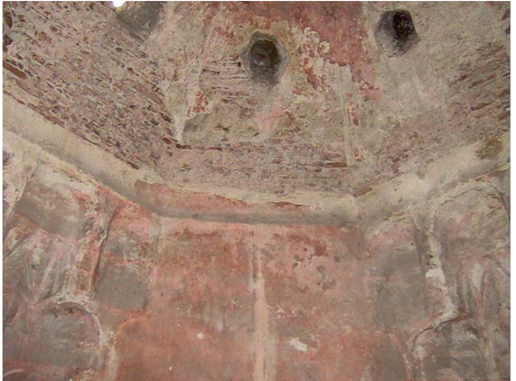
212. Resim: Burhaniye Hamamı , Ilıklık Güneydeki Kubbe Geçişleri
