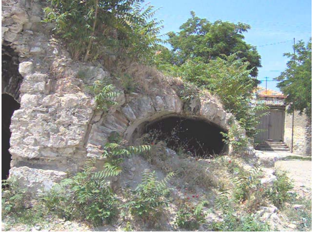
223. Resim: Burhaniye Hamamı , Tonozu Kısmen Yıkılmış Su Deposu
