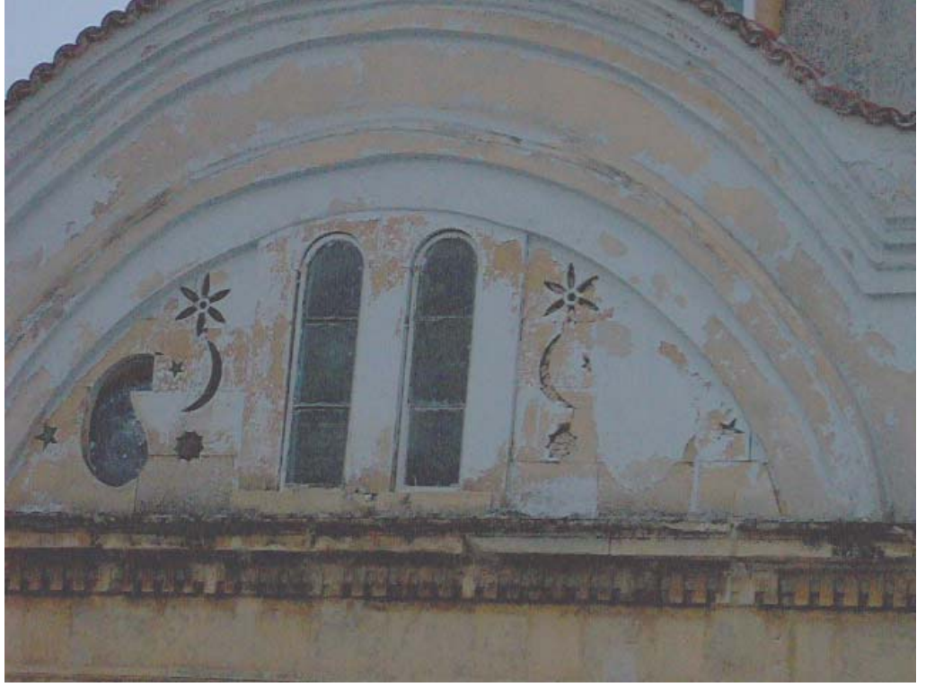
77. Resim: Hacı Ahmed Camii , Beşik Tonozların Dışa Bakan Yüzlerindeki Pencere ve Oyma Taş Süslemeler
