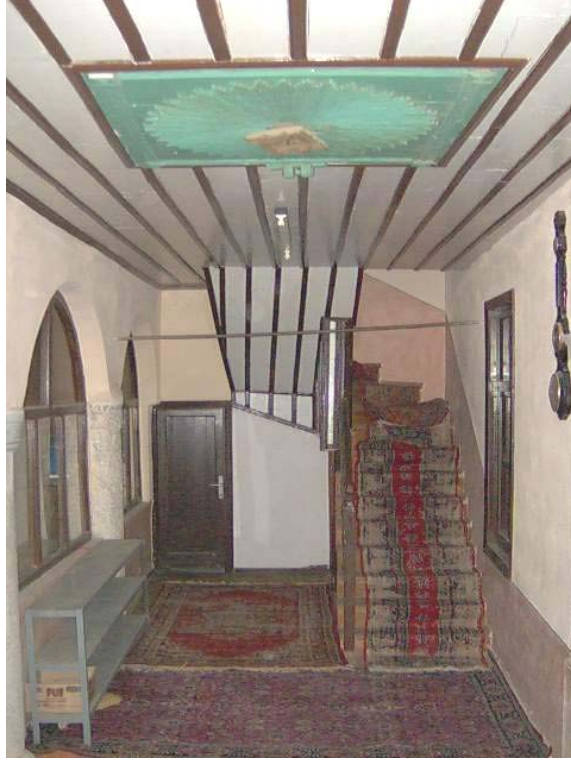
109. Resim: Şahinler Köyü Camii , İkinci Kata Çıkış Merdivenleri
