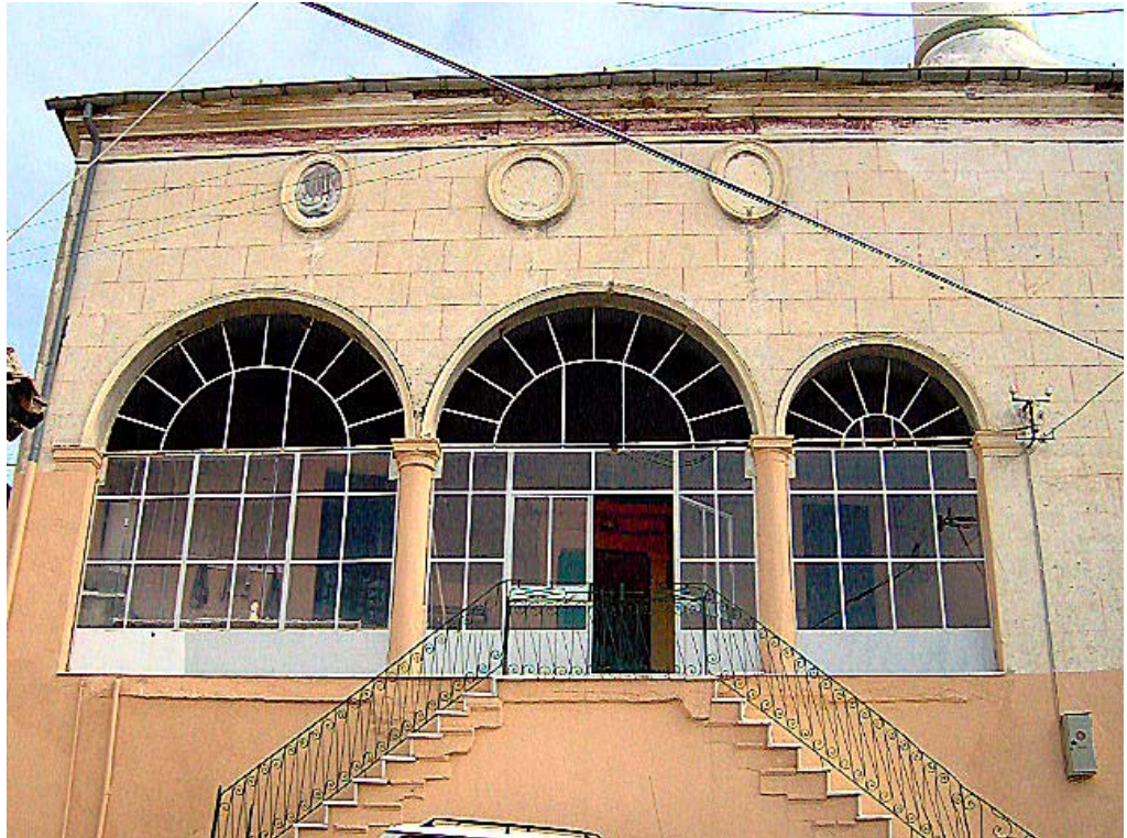
182. Resim: Ağacık Camii, Kuzey Cephe
