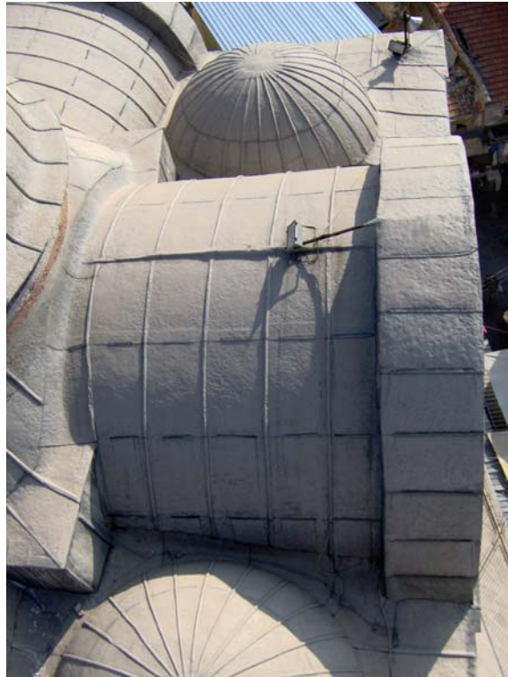
68. Resim: İzmir Kestane Pazarı Camii , Harimi Örtün Beşik Tonz ve Köşe Kubbeleri
