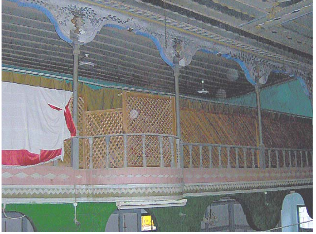
187. Resim: Ağacık Camii, Harim Kuzey Duvarı
