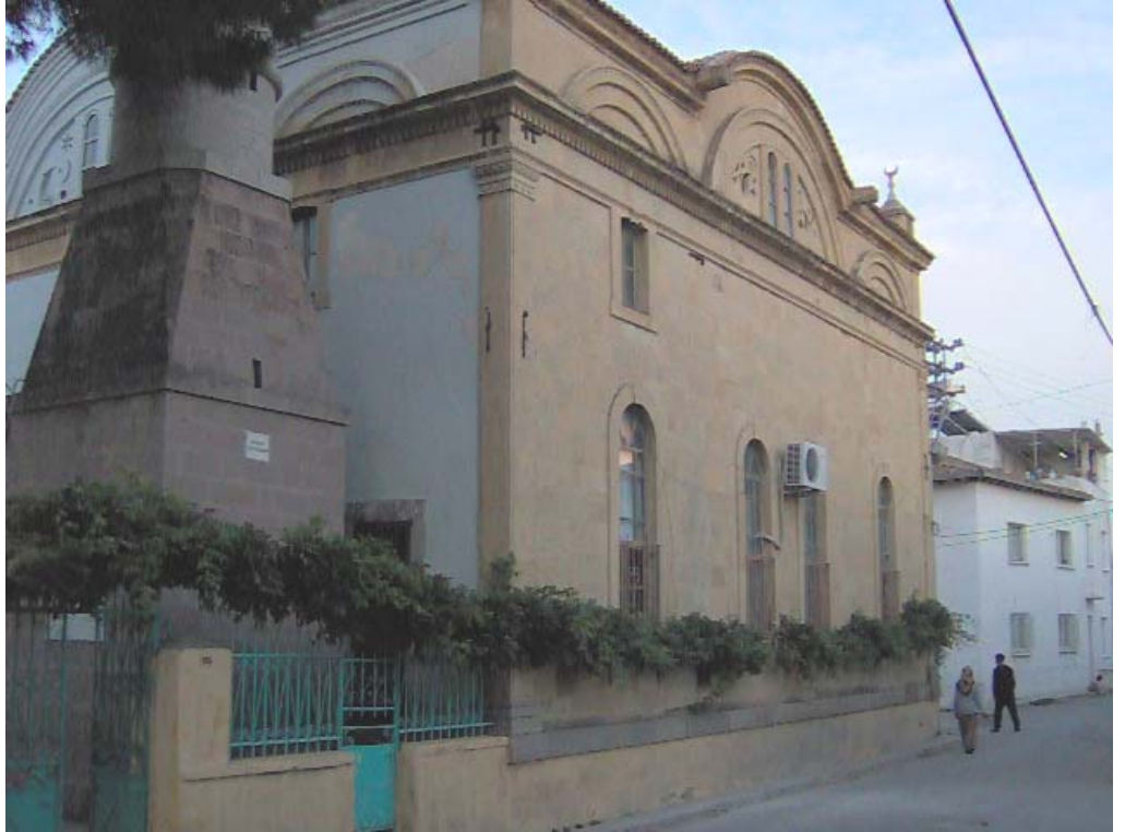
78. Resim: Hacı Ahmed Camii , Batı Cephe
