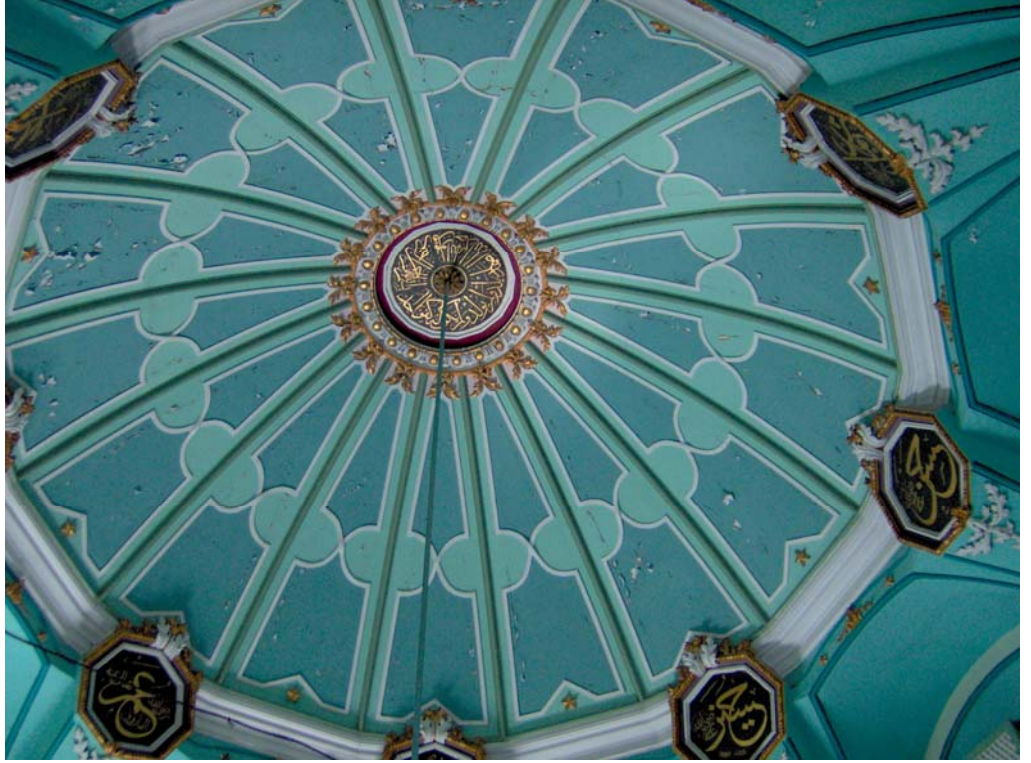
158. Resim: İzmir Damlacık Camii , Merkezi Bağdadi Kubbesi
