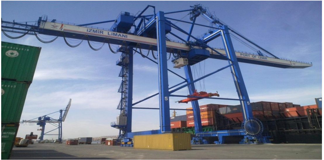
Şekil 34: Bakımı Tamamlanmış Rıhtım Vinci
