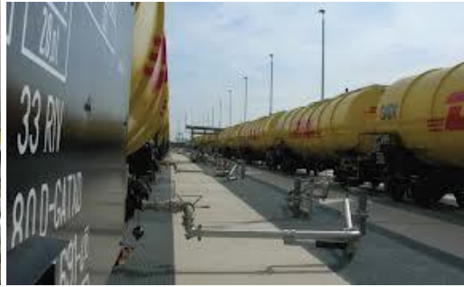
Şekil 25: Alttan yükleme kolu
