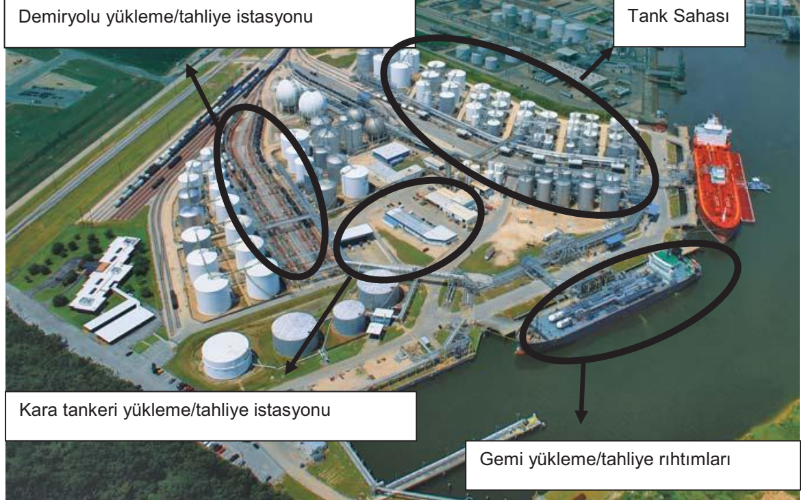
Şekil 26: Sıvı dökme yük terminali örnek yerleşim planı
