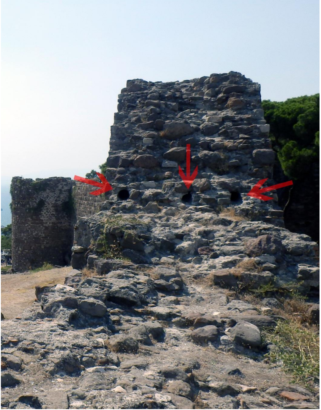
Şekil 55: Güney sur hattı Kule 7-28 arasındaki sur duvarı kesitinde görülen dikine uzanan ahşap hatıllara ait izler.
