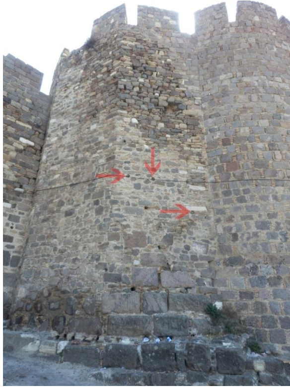
Şekil 54: Kule 9 ve ahşap iskelelere ait kalıntılar.
