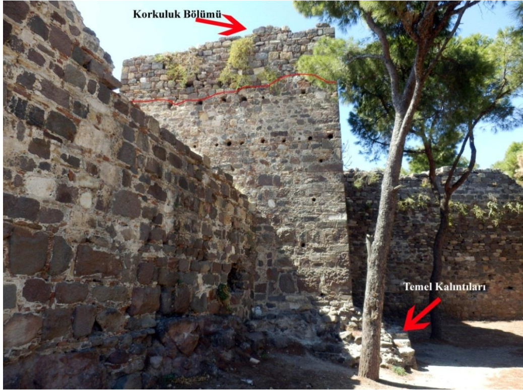
Şekil 80: Sur içinden kule 7 doğu cephesinin fotoğrafı ve daha erkene tarihli kule temel kalıntılarının konumu.
