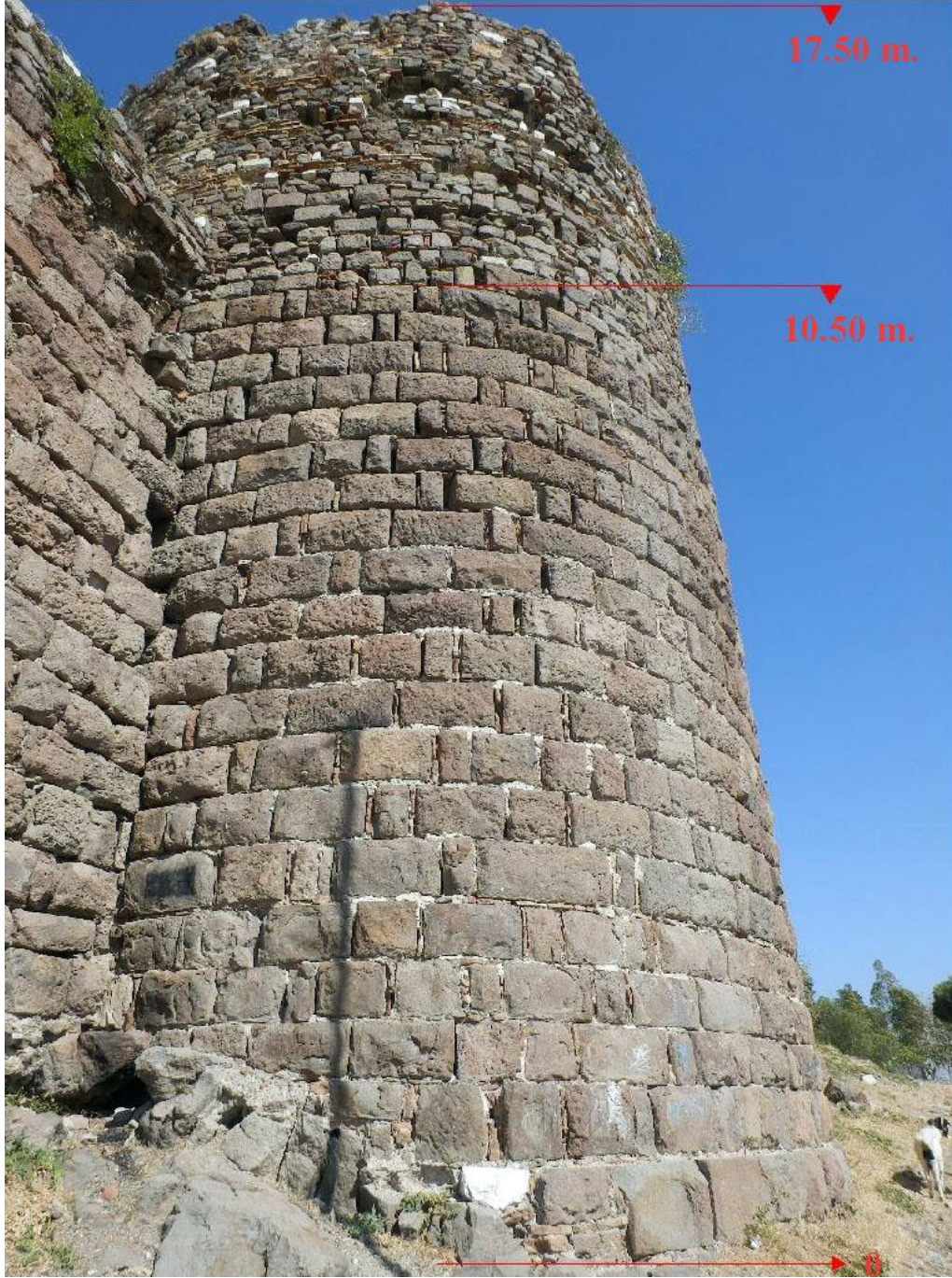
Şekil 31: Kule 1 batı cepheden fotoğrafı ve bölümlerinin yükseklik değerleri.
