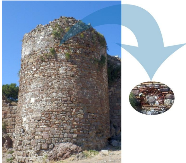
Şekil 52: Kule 2 ve güney cephesinde yer alan küçük tuğla kemer.
