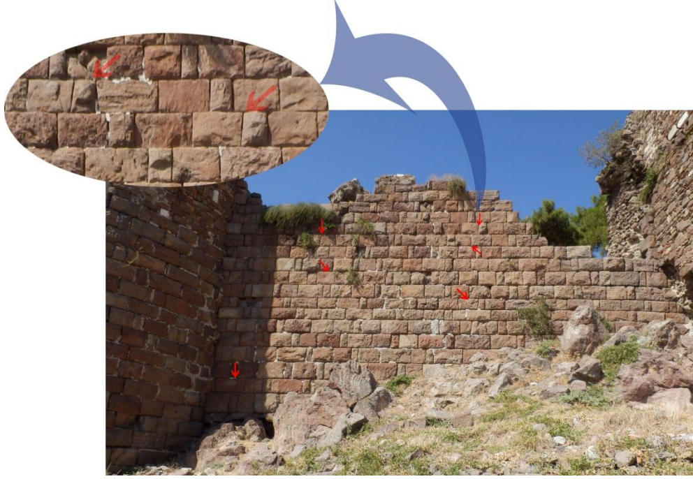
Şekil 69: Kule 1- kule iki sur duvarında yer alan trapezoidal bloklardan bazıları.
