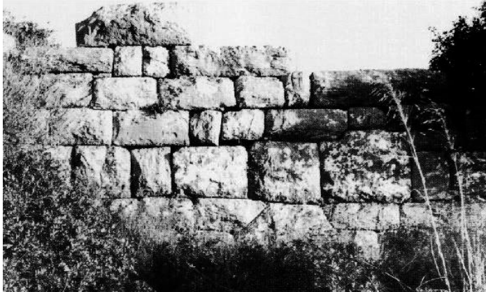
Şekil 27 A-B: Alabanda(Solda) ve Priene(Sağda) kentinden rektogonal ve trapezoidal blokların bir arada kullanıldığı sur duvarları örneği.
