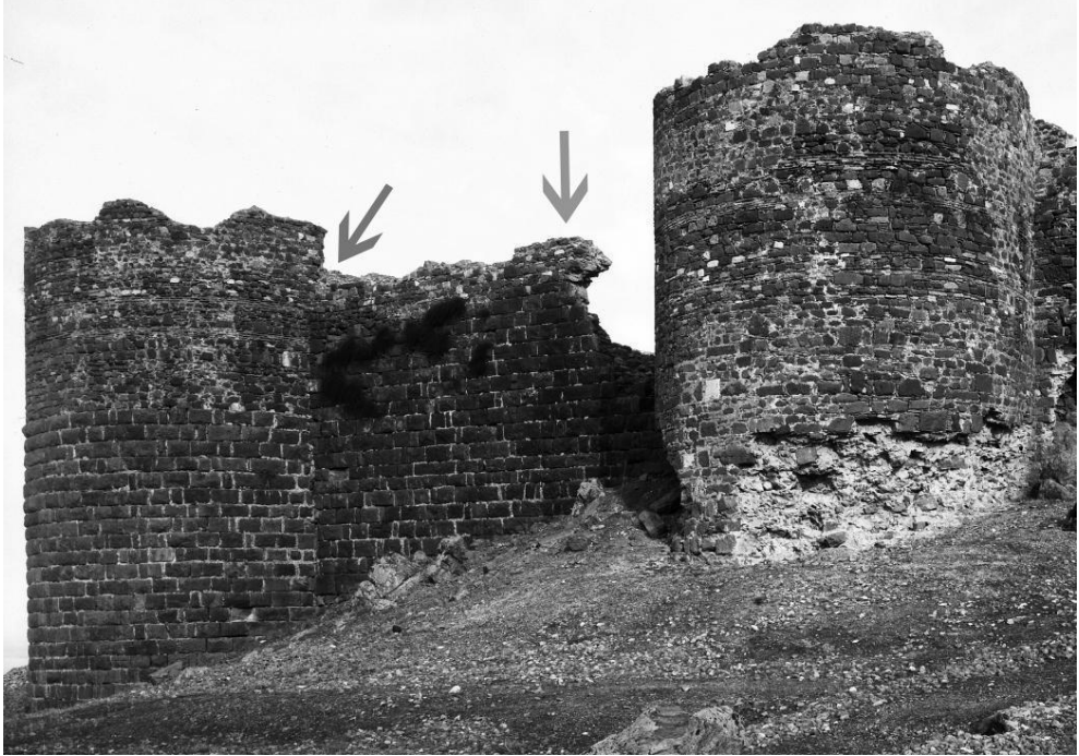
Şekil 70: 1900 yılında Kule 1, 2 arası bağlantı duvarı ve Teknik III ile oluşturulmuş bölümleri.
