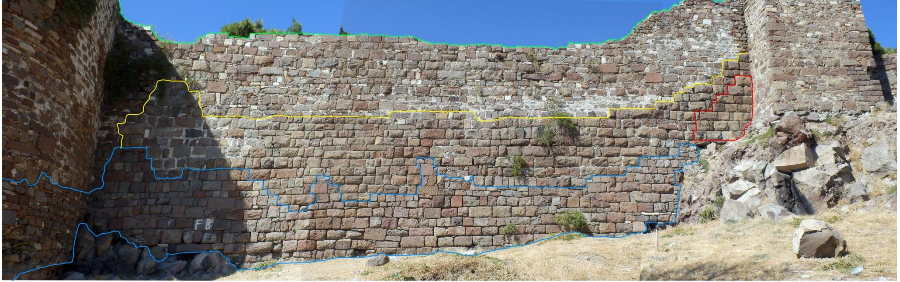
Şekil 30: Kule 2-Kule 7 arası sur duvarına ait fotoğraf üzerinde dönemsel ayrımların gösterimi.
