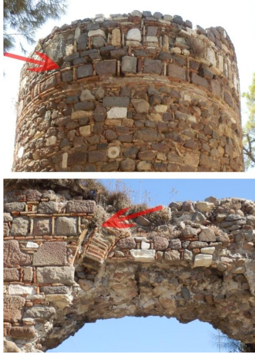
Şekil 43: Kule 3 (üstte) ve Güney Kapı' da (altta) yer alan tuğla kasetler (çerçevelemeler).
