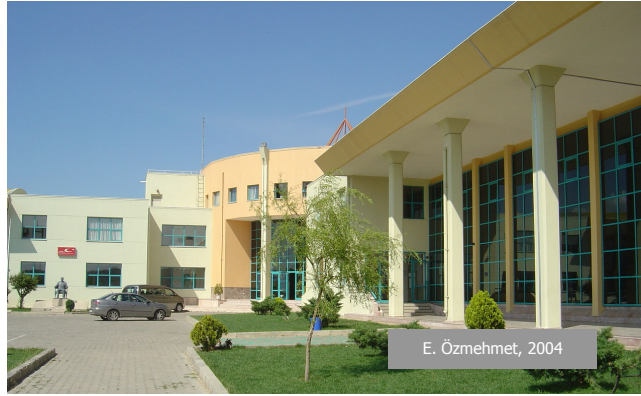
Şekil 6.12 Binanın kış rüzgarlarından korunmak amacı ile tasarlanmış güneye bakan bina girişi
