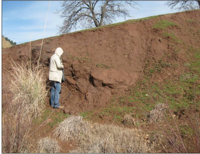
Şekil 2.12 Yağışlar nedeniyle parçalanmış-toprak zemin haline gelmiş kumtaşı birimi
