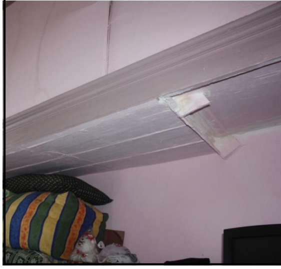
Şekil 5.194 Yapıda kaldırılmış ara kat merdiven izi.
