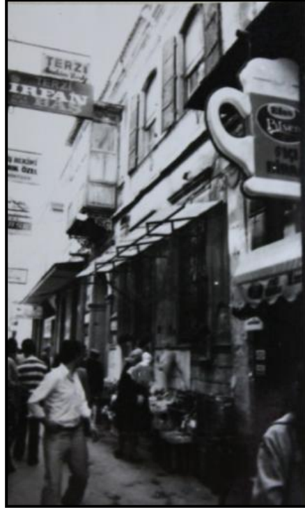
Şekil 5.116 Yapının 1980 yılındaki durumu (36 parsel).
