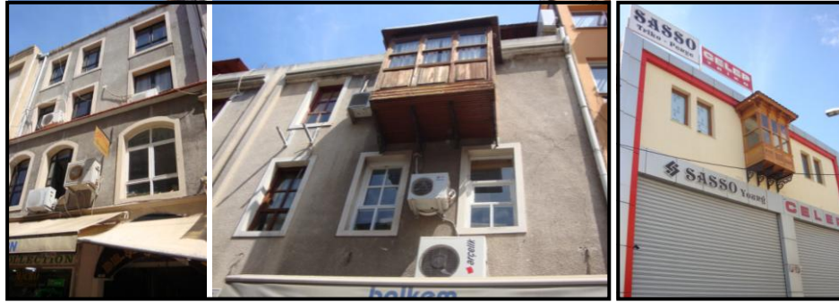
Şekil 6.3 Ticari bölgede bulunan taklit yapı örnekleri.
