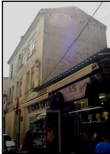
Şekil 5.153 Doğu cephesinin 2010 yılındaki durumu.
