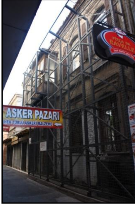
Şekil 5.117 Yapının 36 parselde yer alan bölümünün 2010 yılındaki durumu.
