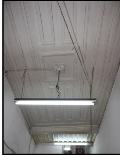
Şekil 5.150 Yapıda bulunan özgün tavan döşemesi.
