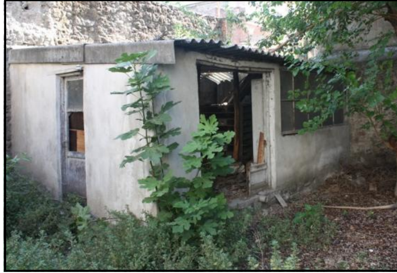
Şekil 5.241 Yapı bahçesinde oluşturulmuş ek birim.
