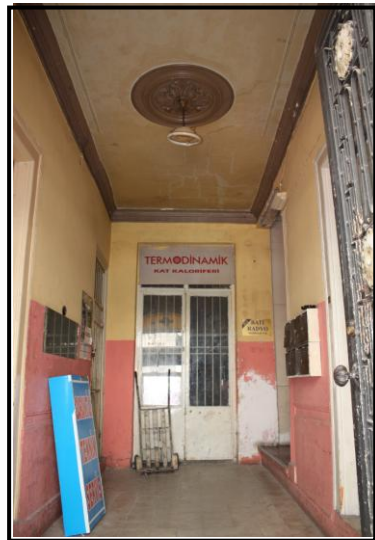
Şekil 5.21 Yapı iç mekanın günümüzdeki durumu.
