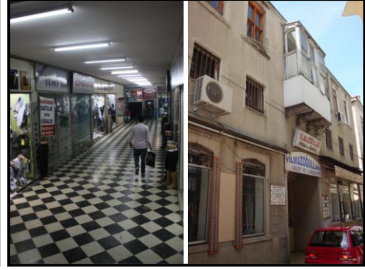
Şekil 6.18 Cephe korumalı restorasyon anlayışında izinsiz uygulama (180 ada 69 parsel ).
