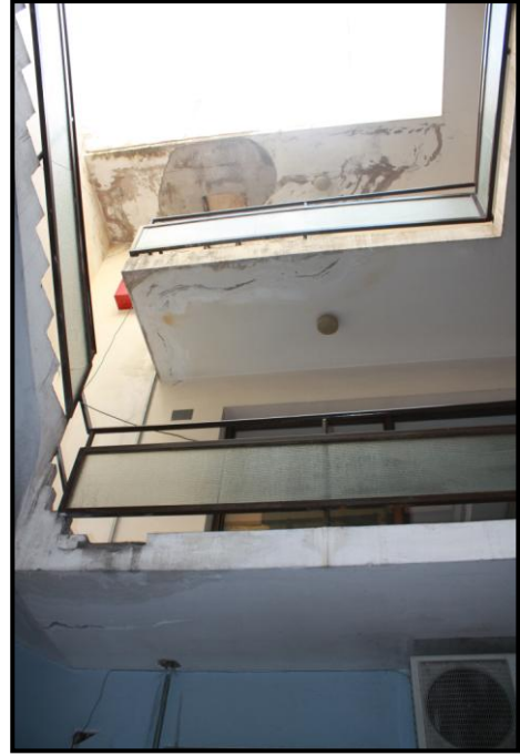
Şekil 5.65 Yapıda oluşturulmuş galeri.
