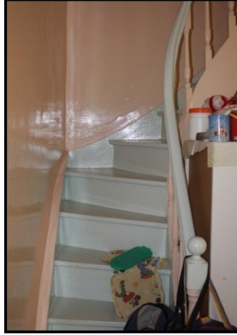
Şekil 5.201 Yapıda bulunan özgün ahşap merdiven
