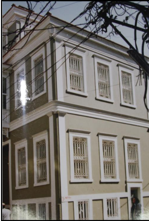
Şekil 5.27 Yapının 1994 yılındaki durumu. (İzmir 1 No'lu KTVKKBK arşivi).
