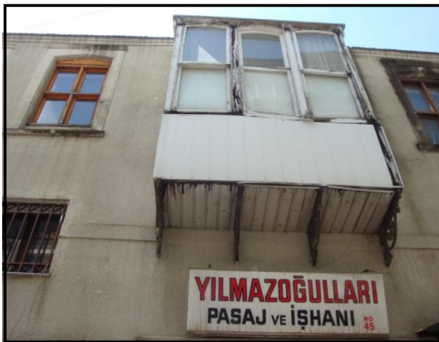
Şekil 5.165 Parsel üzerinde bulunan yapının doğu cephesi.
