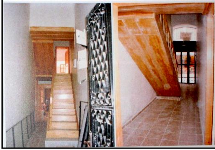
Şekil 5.179 Yapının uygulama sonrası durumu (İzmir 1 No'lu KTVKKBK arşivi).
