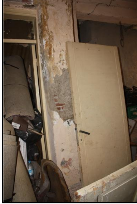
Şekil 5.146 Yapıda günümüzde kullanılmayan ek mekan.
