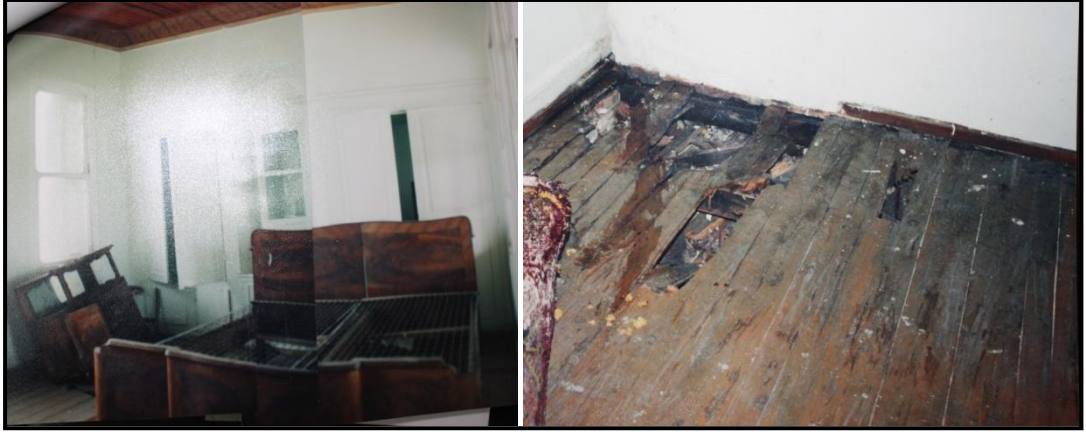
Şekil 5.286 Yapının restorasyon öncesindeki durumu (İzmir 1 No'lu KTVKKBK arşivi).
