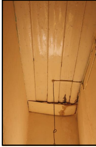
Şekil 5.281 Özgün ahşap döşemenin mevcut durumu.
