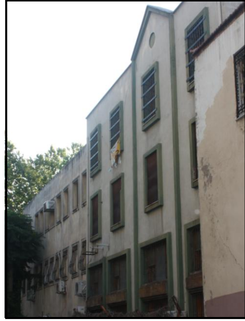
Şekil 5.11 56 ve 57 parsellerde bulunan yapıların 2010 yılındaki görünümü.
