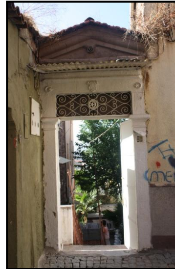
Şekil 5.292 Yapının özgün bahçe giriş kapısı.
