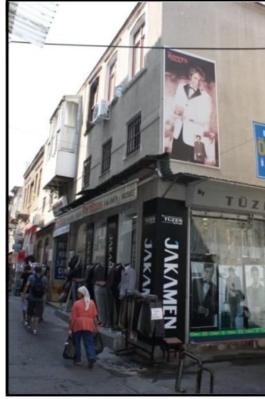
Şekil 5.164 Parselde yer alan mevcut yapı.
