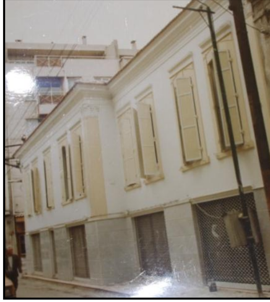
Şekil 5.174 Yapının 1993 yılı onarım sonrası durumu (İzmir 1 No'lu KTVKKBK arşivi).
