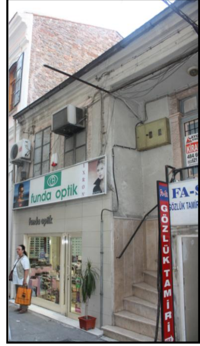
Şekil 5.83 Yapı cephesindeki niteliksiz ekler.
