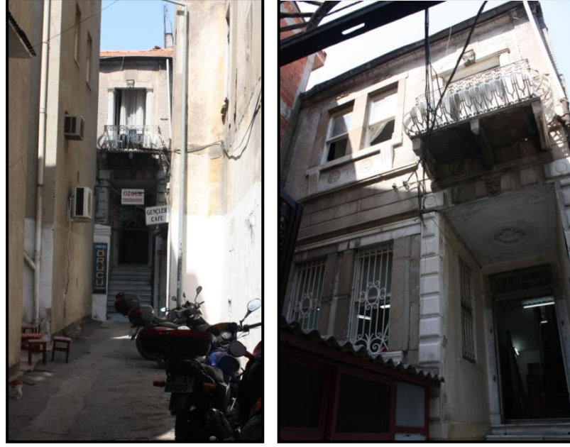
Şekil 5.145 Yapının cephesinin 2010 yılındaki durumu.
