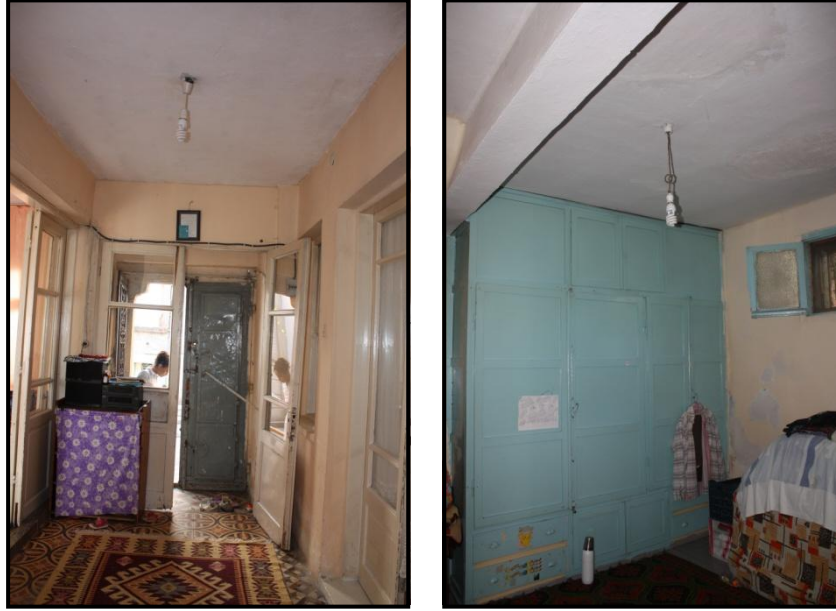
Şekil 5.290 Yapı iç mekânının mevcut durumu.
