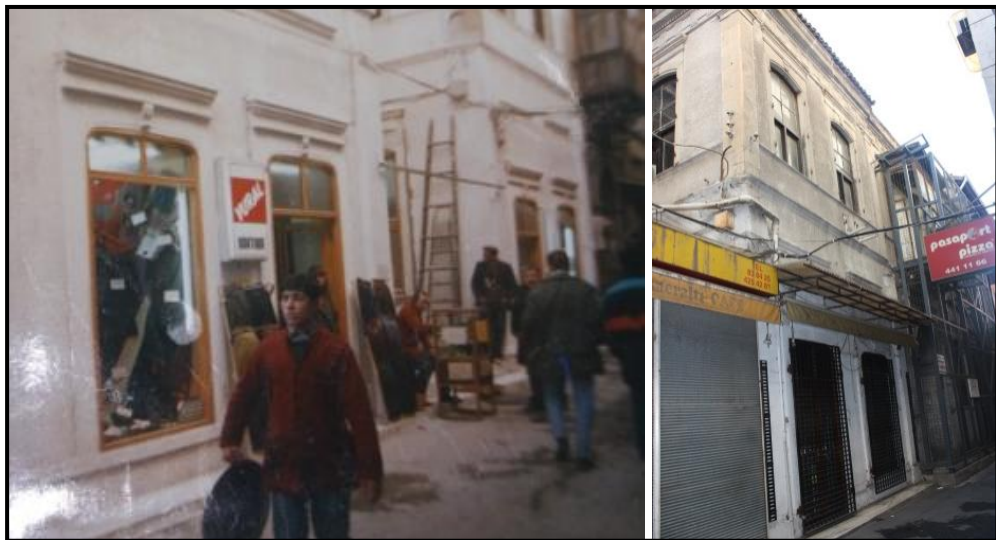
Şekil 5.119 37 parselin 1991 yılı onarım sonrası görünümü. Şekil 5.120 Yapının 2010 yılındaki durumu. (İzmir 1 No'lu KTVKKB arşivi).
