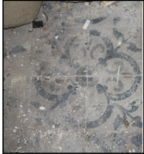
Şekil 5.151 Yapıda bulunan özgün karo siman kaplama.
