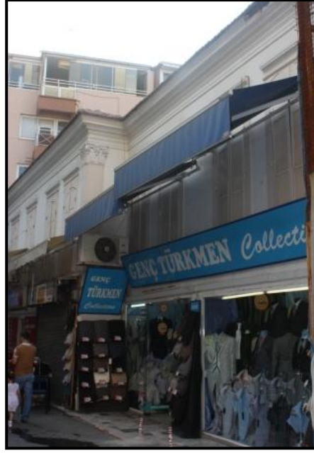
Şekil 5.171 74 parselde yapının 2010 yılındaki durumu.
