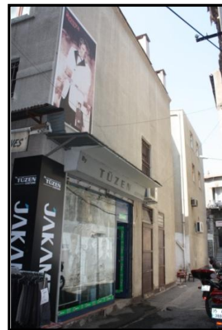
Şekil 5.166 Parsel üzerinde bulunan yapının kuzey cephesi.
