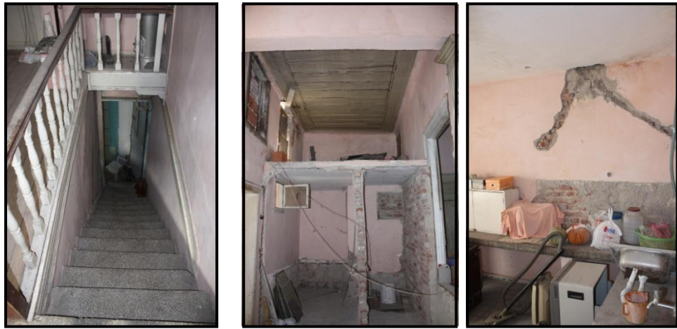
Şekil 5.262 Yapıya eklenen eklenen betonarme merdiven.
