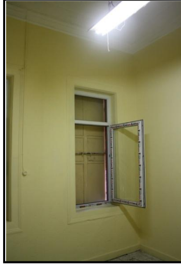
Şekil 5.211 Yapıda yapılan onarım.
