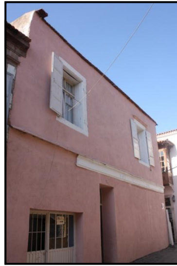
Şekil 5.188 Yapı cephesinde zemin katta özgün olmayan açıklık düzeni.
