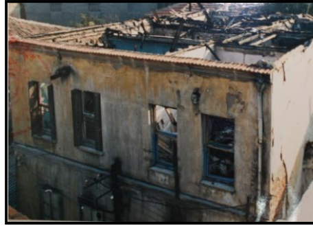
Şekil 6.32 1988 yılında yıkım kararı alınan tescilli yapı (178 ada, 57 parsel).
