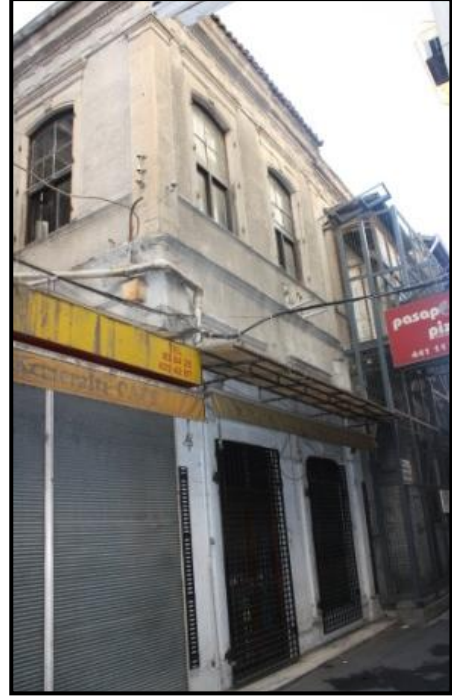
Şekil 5.118 Yapının 37 parselde yer alan bölümünün 2010 yılındaki durumu.
