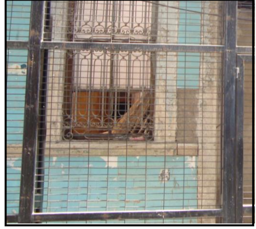
Şekil 5.88 Cephe önünde oluşturulan iskele.
