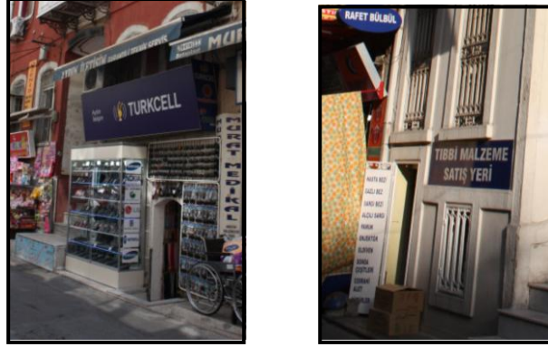
Şekil 6.13 Yol kotunun yükselmesi sonucu yapı bodrum kat girişlerinin durumu (178 ada; 62, 63 parsel).
