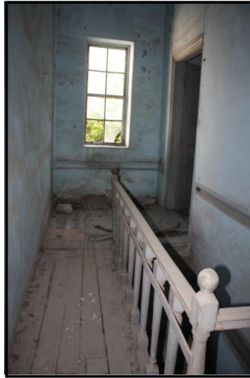
Şekil 5.237 Yapı iç mekanının günümüzdeki durumu.
