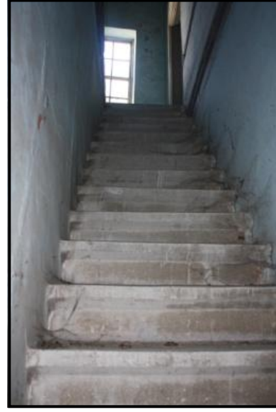
Şekil 5.240 Yapıya eklenen betonarme merdiven.
