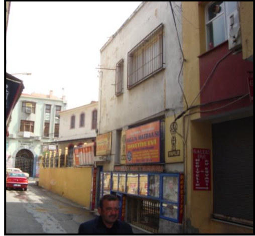
Şekil 5.33 65 parselde bulunan yapının 2010 yılındaki durumu.
