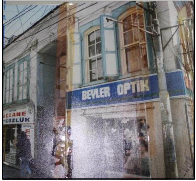
Şekil 5.173 Yapının onarım öncesi batı cephesi görünümü (İzmir 1 No’lu KTVKBK arşivi).
