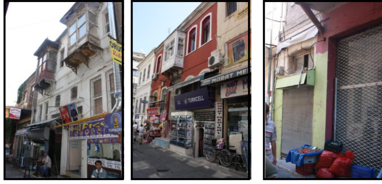
Şekil 6.9 Çoklu kullanımın yapılar üzerindeki etkisi (180 ada, 50 parsel; 178 ada, 62 parsel).
