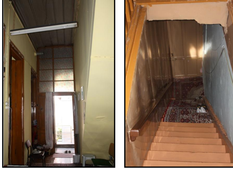
Şekil 5.254 Yapıda mevcut, özgün olmayan mekân organizasyonu.
