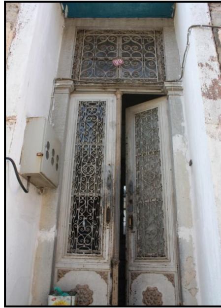
Şekil 5.192 Yapıya ait özgün giriş kapısı.
