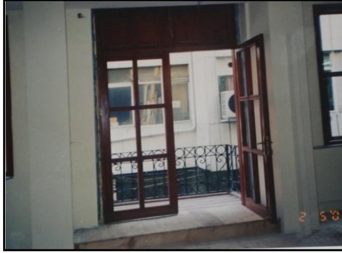
Şekil 5.114 Yapının restorasyon uygulaması sürecindeki durumu (İzmir 1 No’lu KTVKKBK arşivi).
