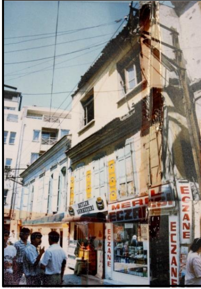
Şekil 5.172 Yapının onarım öncesi güney cephesi görünümü (İzmir 1 No’lu KTVKBK arşivi).
