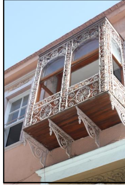
Şekil 5.234 Yapıda yer alan özgün ahşap cumba.
