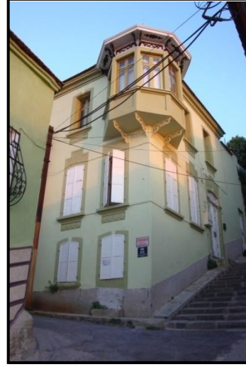
Şekil 5.204 Yapı cephesi genel görünümü.
