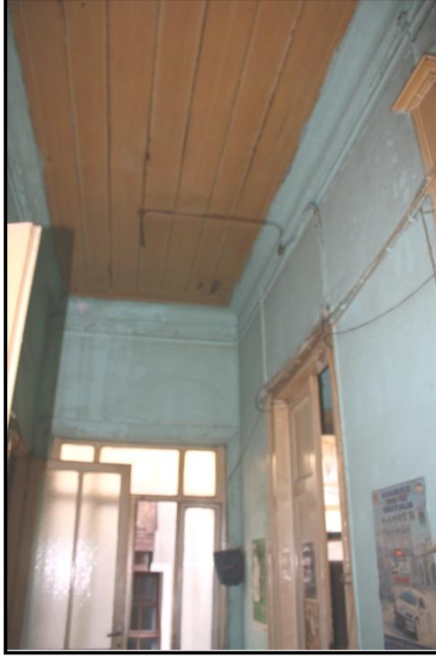
Şekil 5.161 Yapıda yer alan özgün tavan döşemesi.
