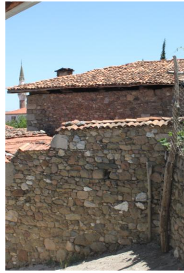
Üst sokaktan yapının yan cephesi
