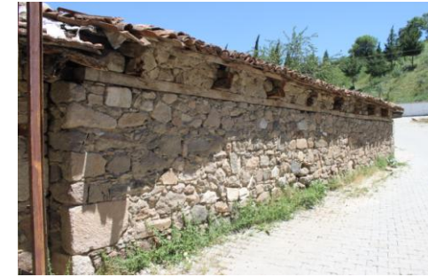
Masif taş duvarlı arka cephe
