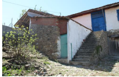
Tadilat geçirmiş bağımsız deponun avludan görünümü
