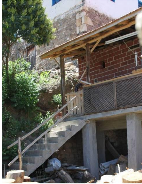
Şekil 5.4 1844 numaralı parselde yer alan yapının tadilat sonrası avludan görünümü
