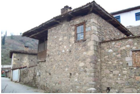
Tuğla duvar örülmeden önce ahşap korkuluklara sahip açık sofanın yoldan görünümü
