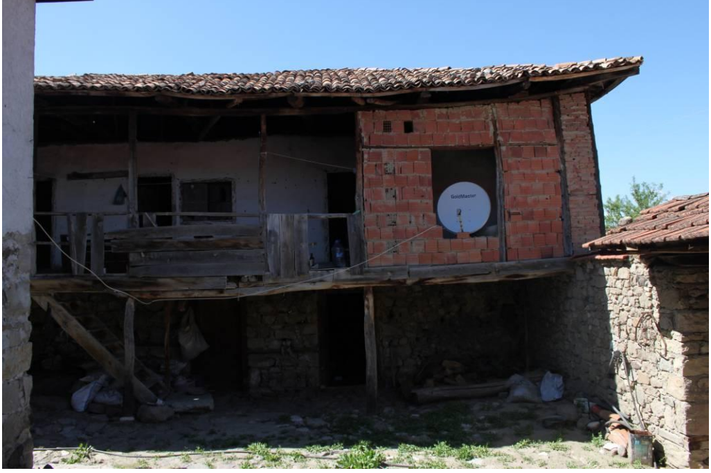
Şekil 4.25 Yapıya sonradan eklenen mekanın avludan görünümü
