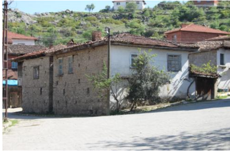
Yapının giriş cephesinden bir görünüm
