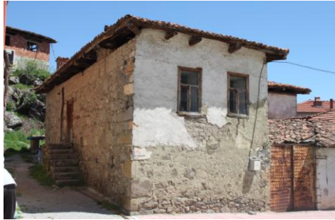
Yapının yan girişi ve ana giriş cephesi
