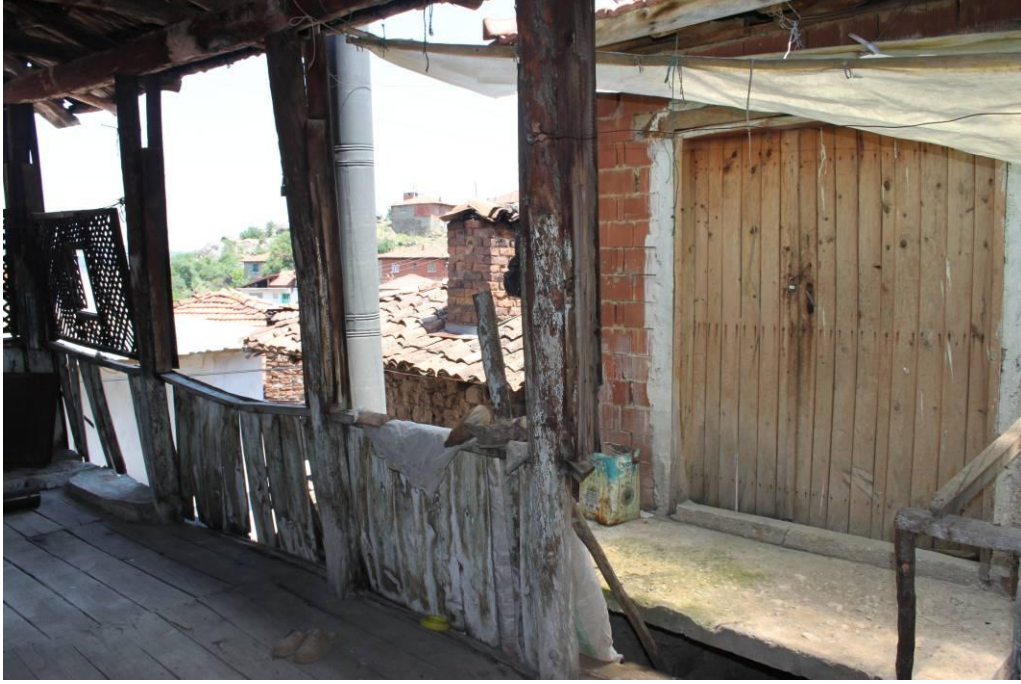
Şekil 4.48 1857 numaralı parselde bulunan yapının açık sofasından yeni betonarme yapıya geçiş
