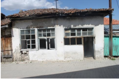
Yapının güneybatış cephesinden görünüm
