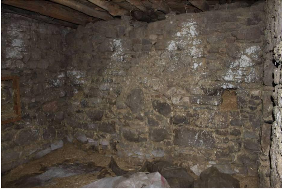
Şekil 4.47 Yapının giriş katında eskiden oda olarak kullanılan depo mekanında görülen ocak izi
