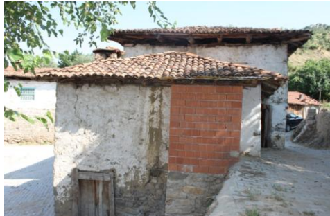
Din görevlisi odasının yanına sonradan eklenen tuğla duvarlı hela yapısı
