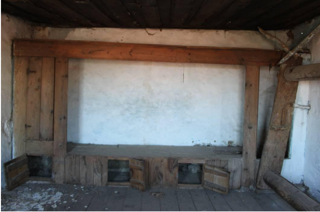
Şekil 4.11 Yüklük ve köşesindeki gusulhane ögesi
