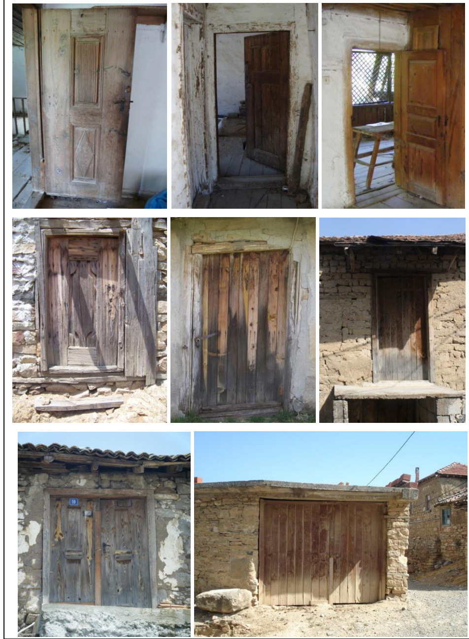
Şekil 2.30 Balıkesir kırsalından iç, giriş ve avlu kapısı örnekleri (Çorapçıoğlu ve diğer., 2010)
