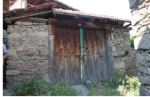
Avlu giriş kapısı
