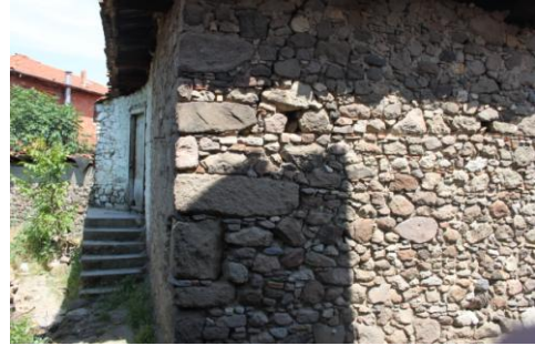
Yapının yan cepheden girişi
