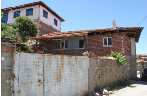
Avlu giriş kapısı
