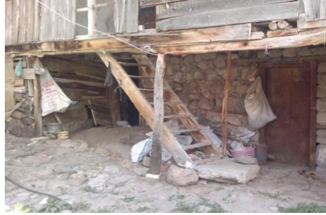
Zemin katta bulunan depolar ve sofaya çıkan ahşap merdiven
