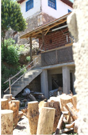
Betonarme kolonlarla desteklenen sofanın avludan görünümü
