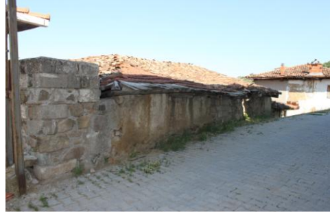
Üst yoldan arka cephenin görünümü
