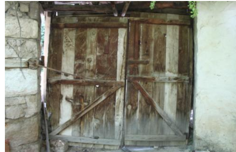
Avlu giriş kapısı
