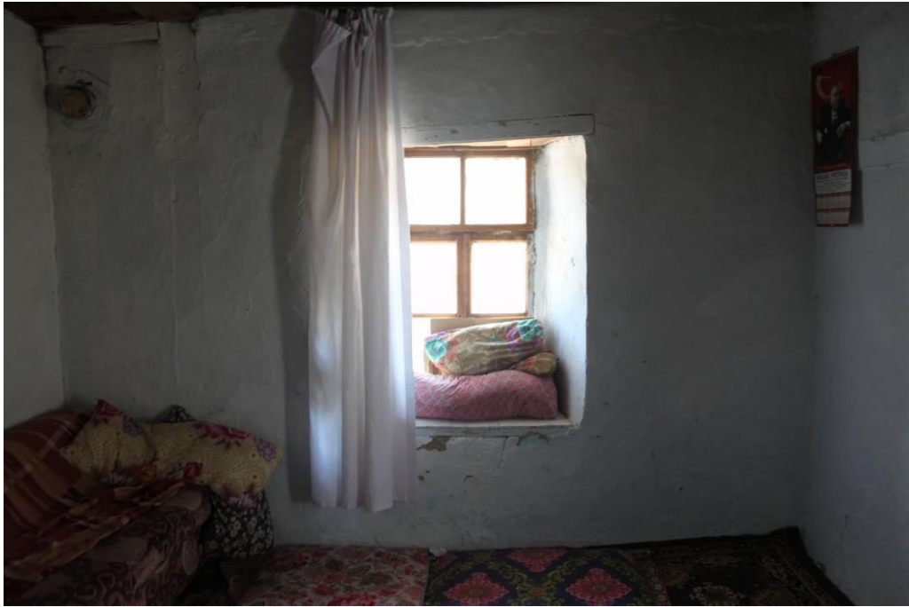
Şekil 4.45 Oda iç mekanından pencerenin görünümü
