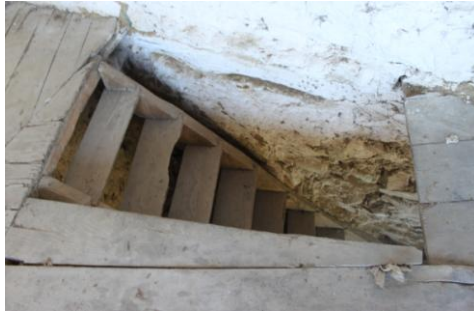
Dış sofaya çıkan merdivenin birinci kattan görünümü
