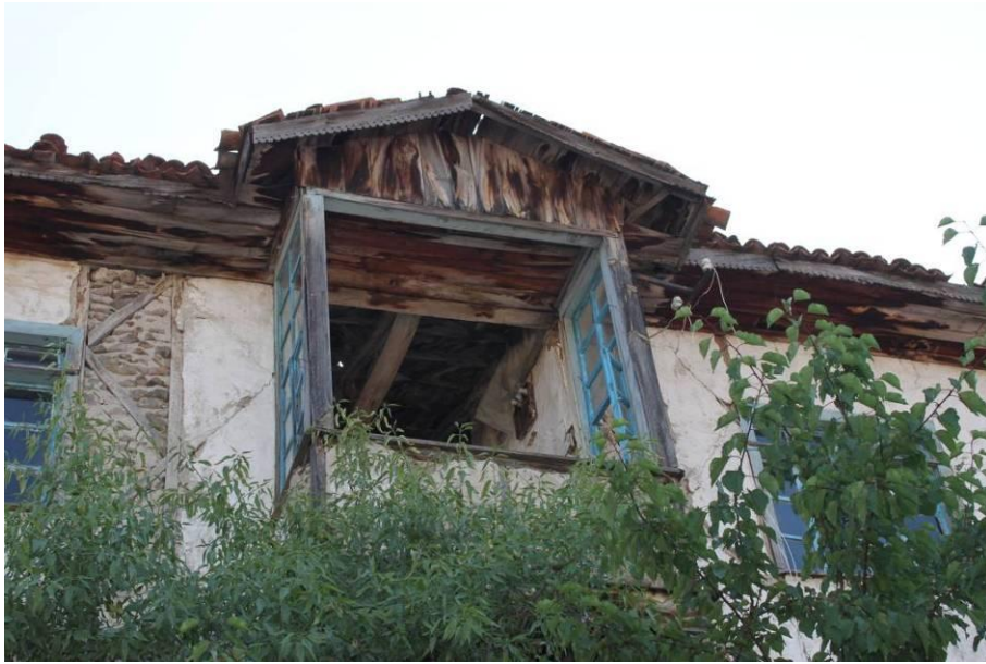
Şekil 3.69 1617 numaralı parseldeki yapının yalın bırakılmış saçak altı kaplaması ve saçak alın tahtası
