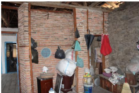
Odadaki tuğla duvar eklenti
