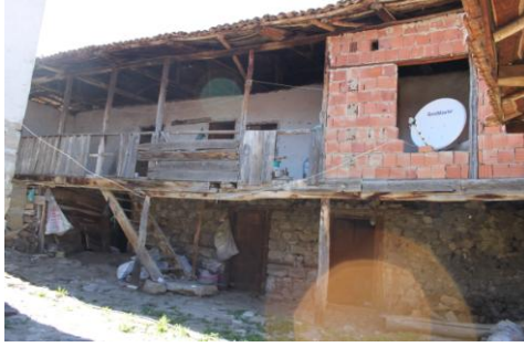
Avludan dış sofaya bakış ve zemin katta bulunan depoların görünümü
