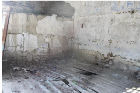
Yapı iç mekanından görünüm
