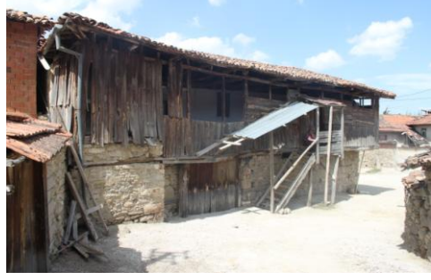
Dış sofalı ön cepheden görünüm
