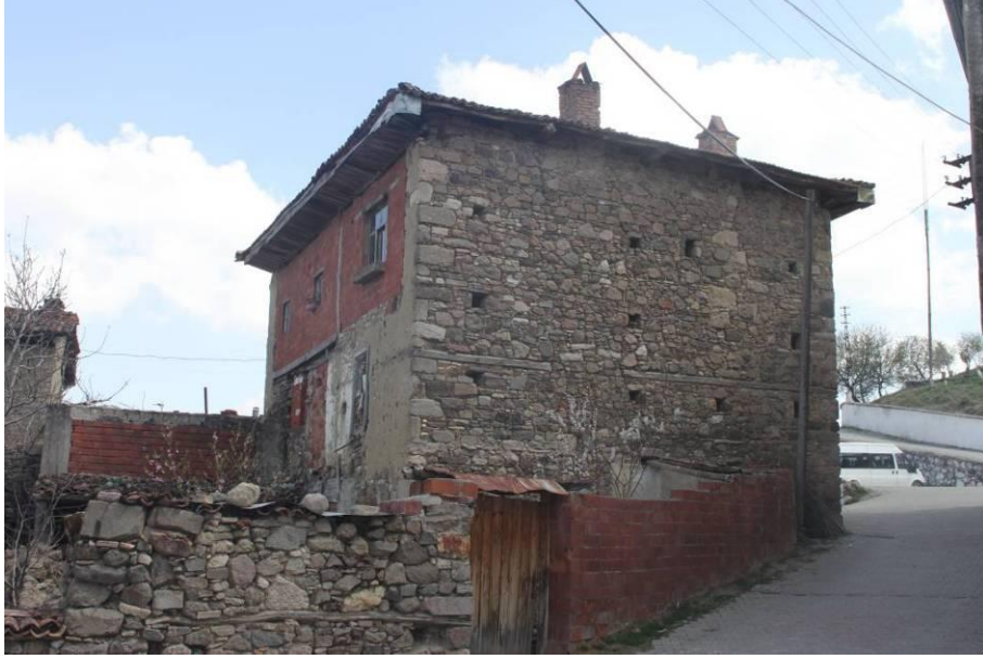
Şekil 5.5 Kayacık'ta geleneksel yapım teknik ve malzemeyle yapılmış bir yapının yapılan özensiz tadilat sonrası görünümü
