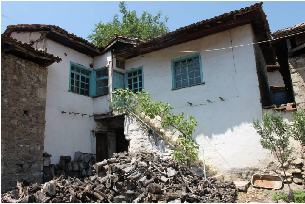
Şekil 4.29 1948 numaralı parselde bulunan yapının güneydoğu cephesinden görünüm
