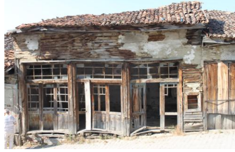
Yapının ana cephesi
