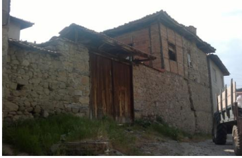
Avlu giriş kapısı ve yan cephe
