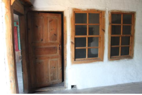
Odanın kapısı ve iç sofaya bakan pencereleri
