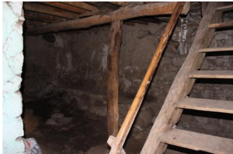
Zemin katta bulunan depo ve üst kata çıkan ahşap merdivenin görünümü
