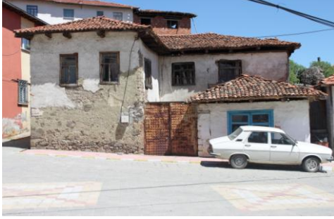
Yapının Cumhuriyet Meydanı'na bakan ana giriş cephesi
