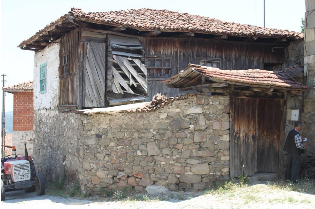
Şekil 4.14 1869 numaralı parselde bulunan yapının doğu cephesinden görünüm
