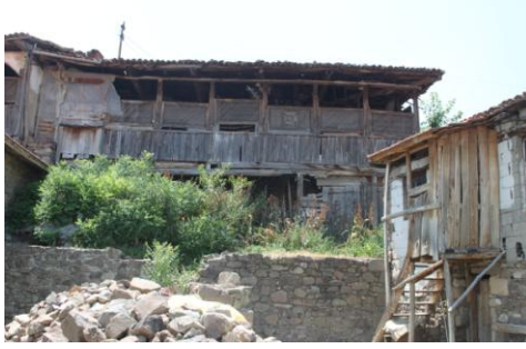
Ön cephe ve ahşap kafes panonun görünümü
