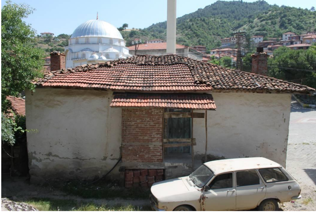
Şekil 4.38 Kuzey cephesinden görünüm
