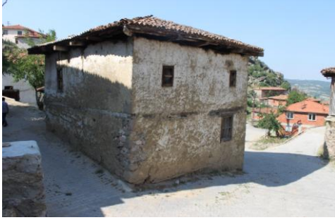
Üst yoldan yapının genel görünümü
