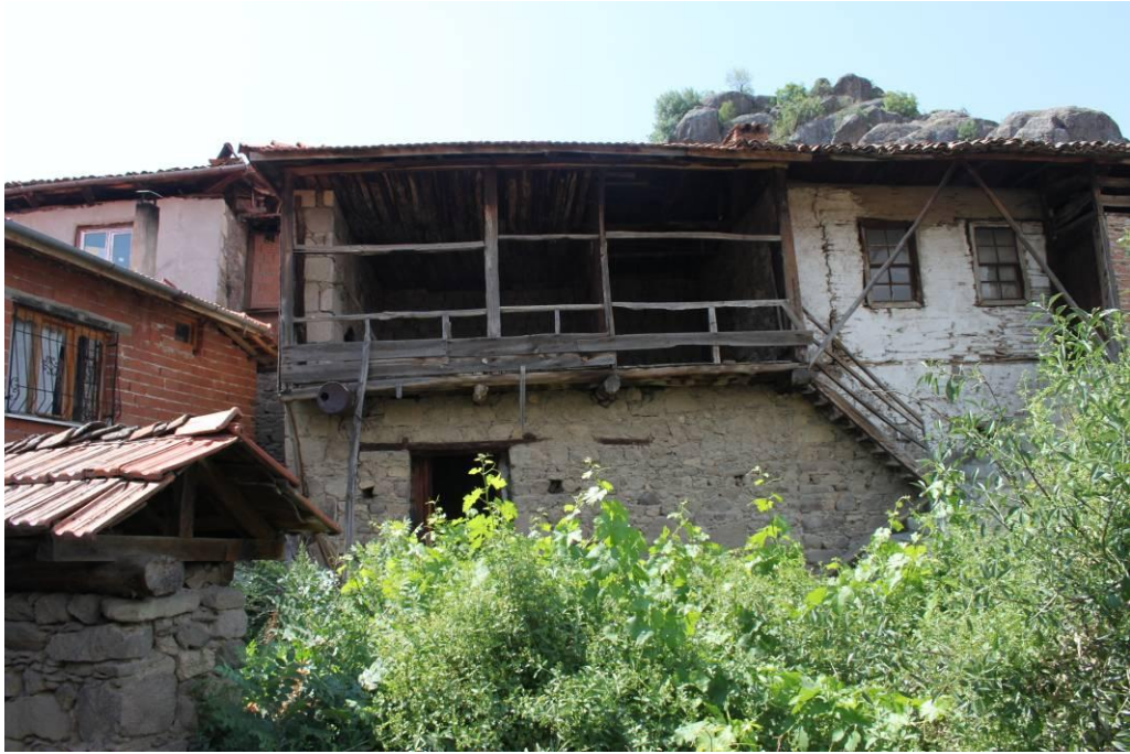
Şekil 3.65 1953 numaralı parseldeki yapıda hayatın devamı niteliğinde açık çıkma
