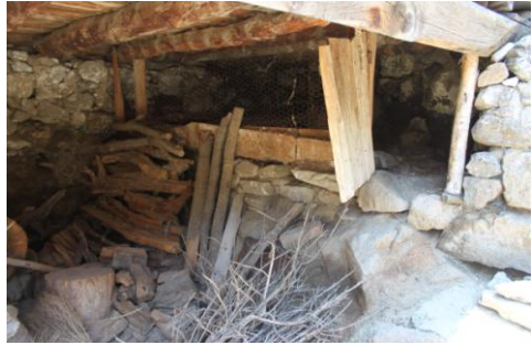
Merdiven altında bulunan kümes
