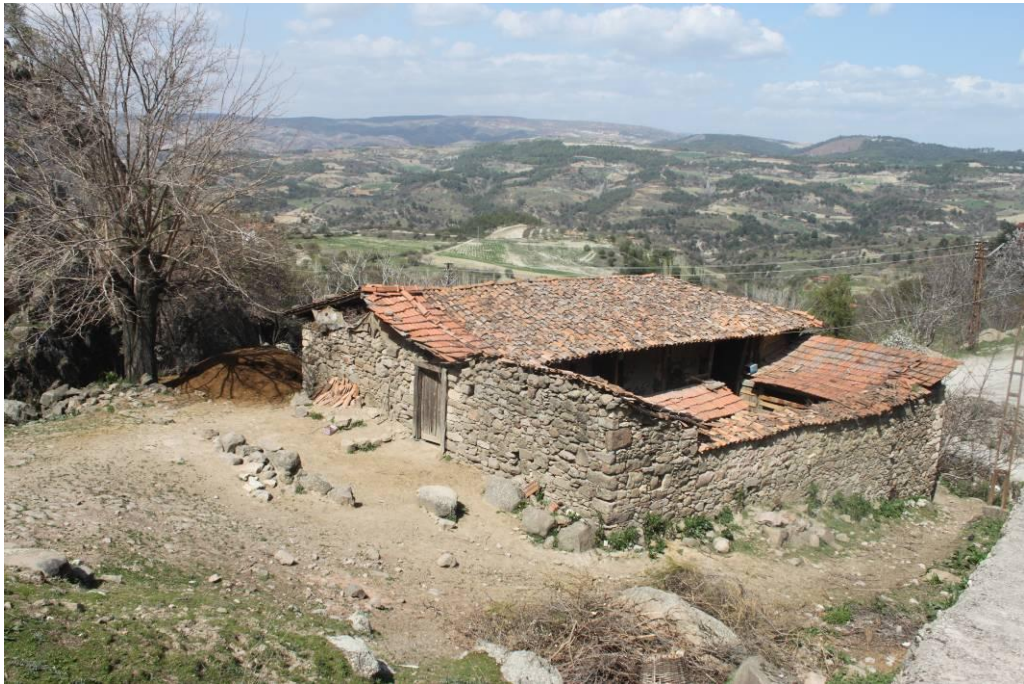
Şekil 3.52 1981 numaralı parselde bulunan eski Jandarma Binası
