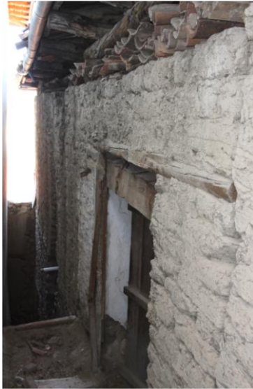
Yapının yan cephesinde bulunan hela
