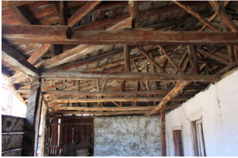
Dış sofadan ahşap çatı konstrüksiyonunun görünümü
