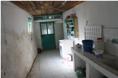
Sonradan eklenerek büyütülen yapı girişinin yan bölümünü oluşturan holden görünüm
