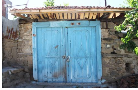
Avlu giriş kapısı
