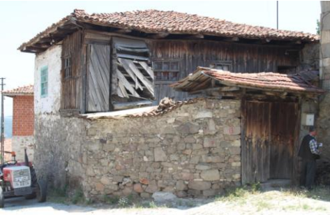
Ön cephe ve avlu kapısı
