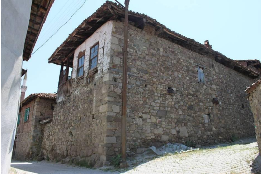
Şekil 4.46 1857 numaralı parselde bulunan yapıdan görünüm
