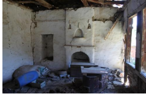
Dış sofanın köşesinde bulunan ocak ve niş
