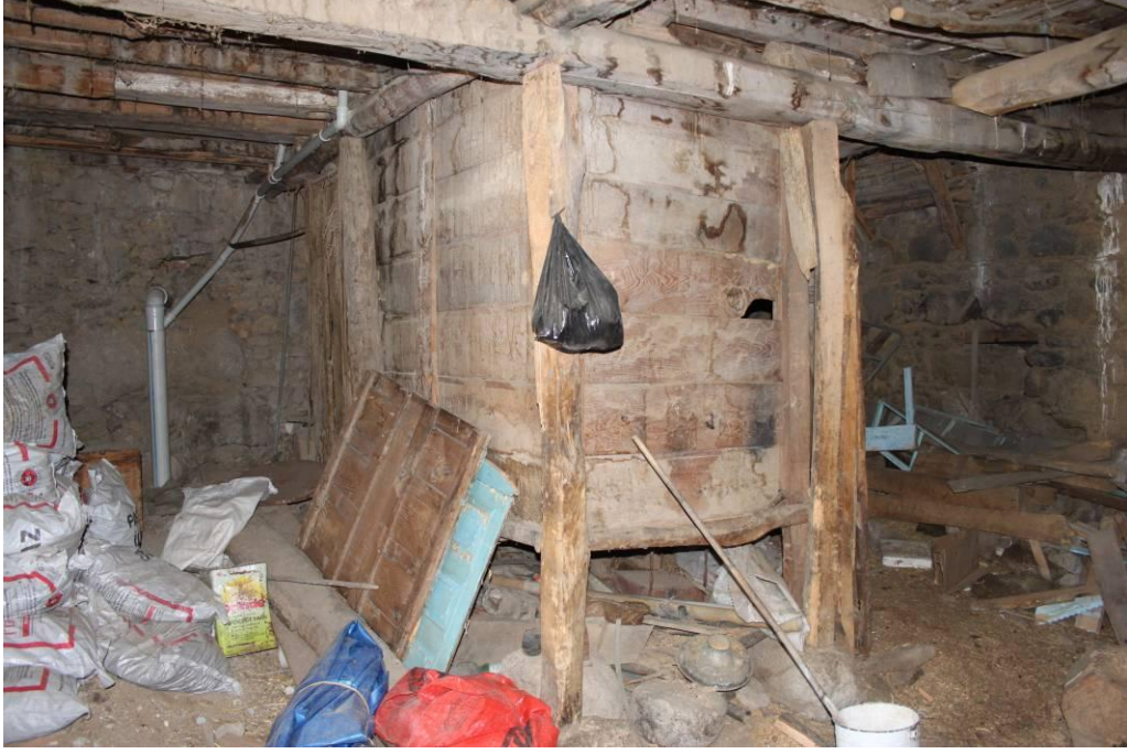
Şekil 4.40 Zemin kattaki depoda bulunan altı ahşap ayak üzerinde yükseltilmiş ekin ambarı
