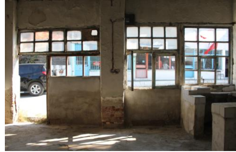
Yapı iç mekanından görünüm
