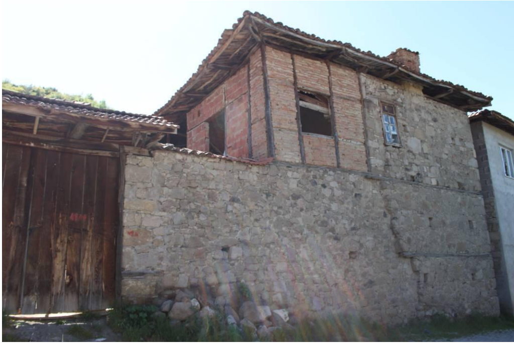
Şekil 4.23 1583-4 numaralı parsellerde bulunan yapının kuzeydoğu cephesinden görünüm
