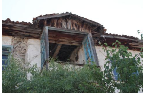
Ahşap çıkma ve saçakta ahşap dantel işleme
