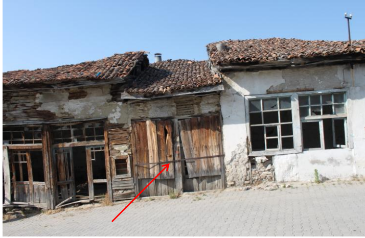
Yapının güneybatı cephesinden görünüm
