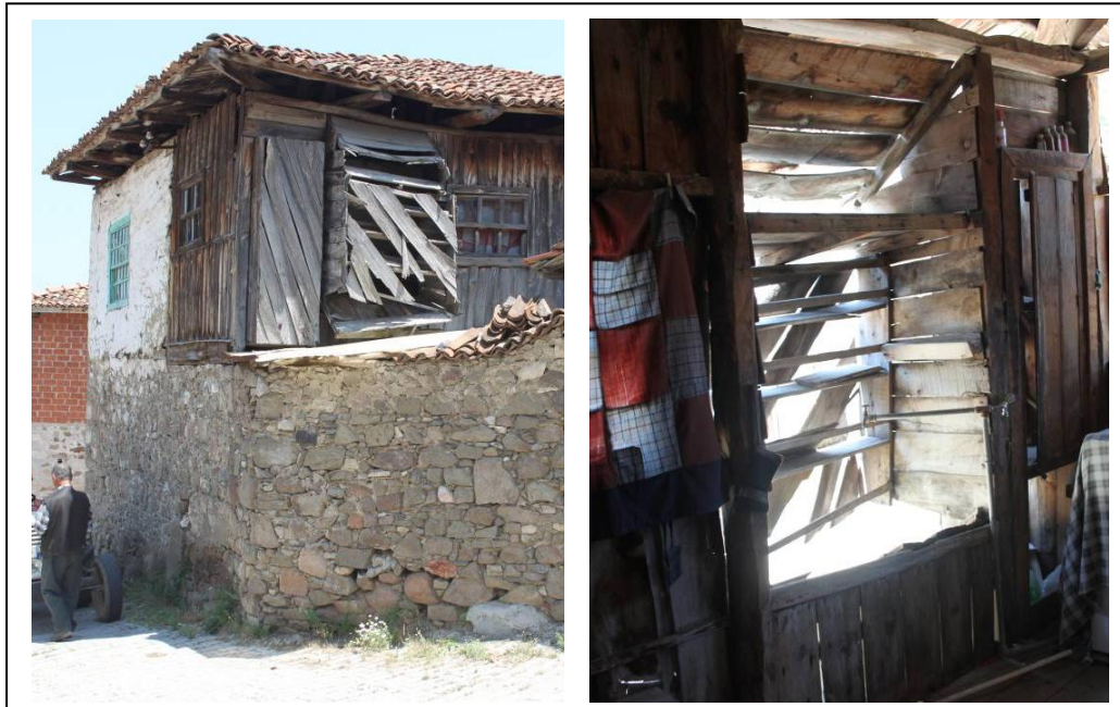
Şekil 3.58 1869 numaralı parselde bulunan kapalı sofalı yapıda abdestliğin dış mekandan ve iç mekandan görünümü
