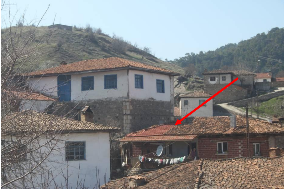
Şekil 3.68 1844 numaralı parseldeki tescilli yapının tadilat sonucu kısmen Marsilya Kiremit ile kaplanan çatısı
