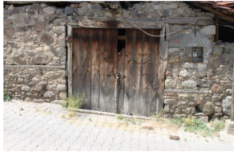
Avlu giriş kapısı
