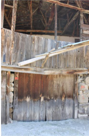
Zemin katta bulunan depo giriş kapısı
