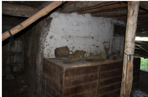
Zemin katta bulunan depo ve buğday ambarından görünüm
