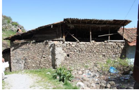
Üst yoldan arka cephenin görünümü
