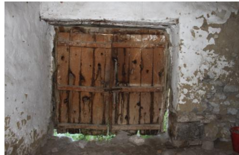
Zemin katta bulunan depoya giriş kapısı
