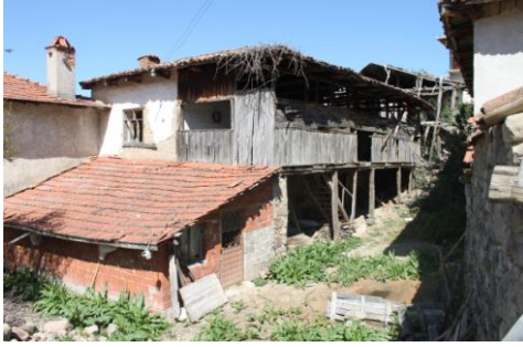
Yapının giriş cephesi ve depo mekanı
