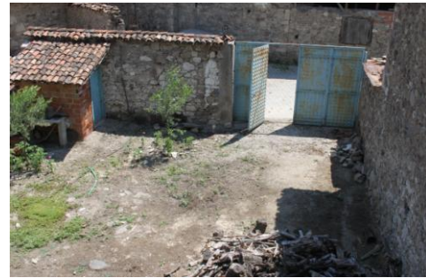
Avluda bulunan tuğla duvarlı ek hela yapısı ve avlu giriş kapısı
