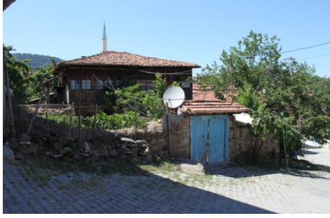
Yapının ana giriş cephesi ve avlu giriş kapısı
