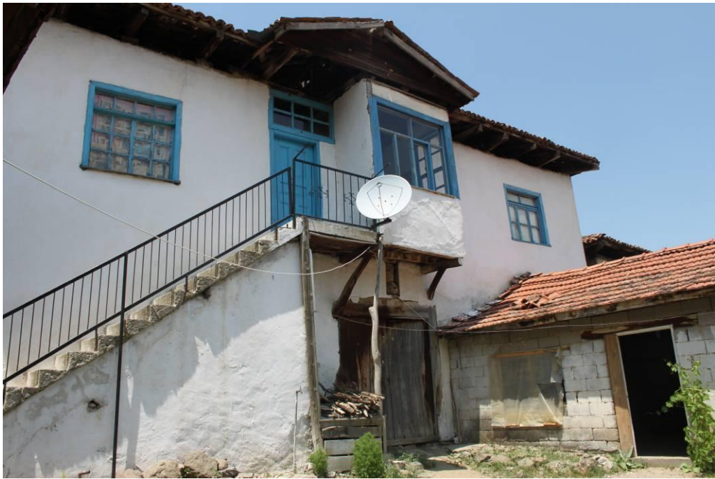
Şekil 3.64 1932 numaralı parselde yer alan yapıda payandalı çıkma örneği
