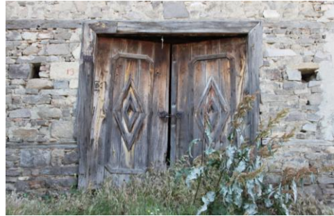
Depoya giriş kapısı
