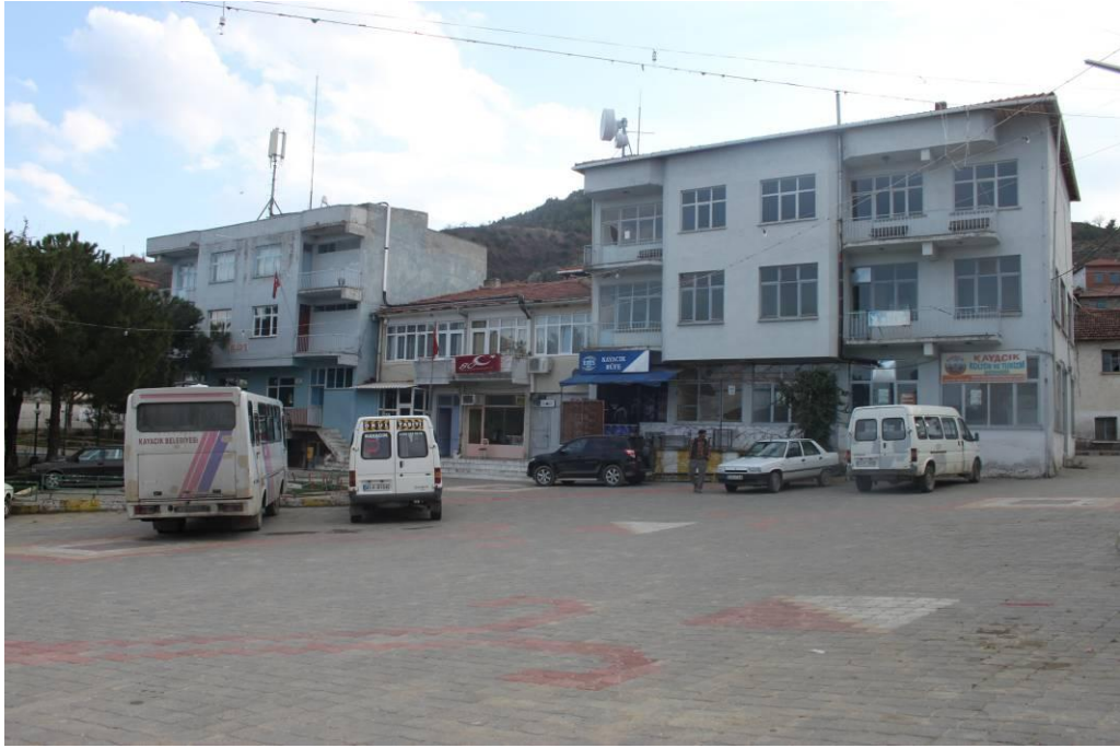
Şekil 3.19 Kayacık Belediye Hizmet Binası, Lojmanı ve Düğün Salonu ile Dükkanlar
