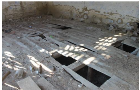
Yapının iç mekanından ahşap döşeme görünümü
