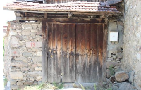
Avlu giriş kapısı
