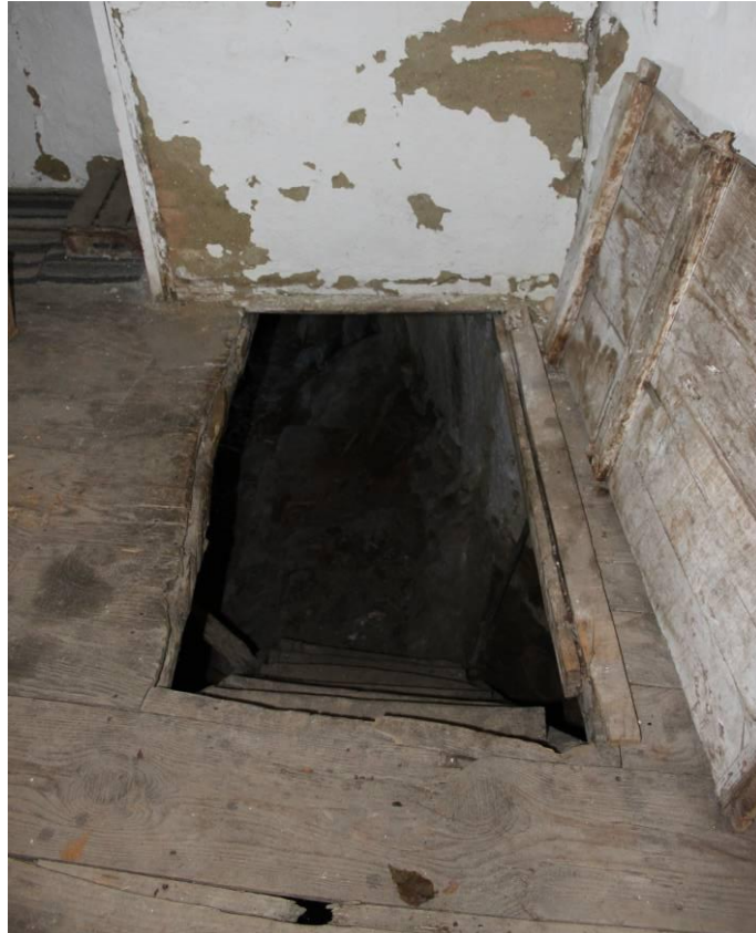
Şekil 3.60 1636 numaralı parselde sofanın içinden depoya inilen merdiven ve kapağı
