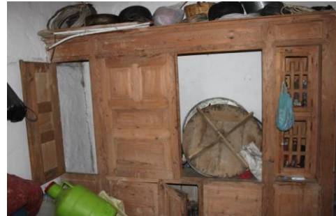
Yüklük ve köşesindeki gusülhane bölümü
