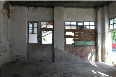
Yapı iç mekanından genel görünüm
