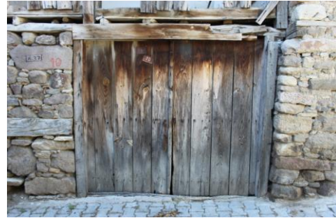
Taşlıktan geçilerek girilen yapının giriş kapısı
