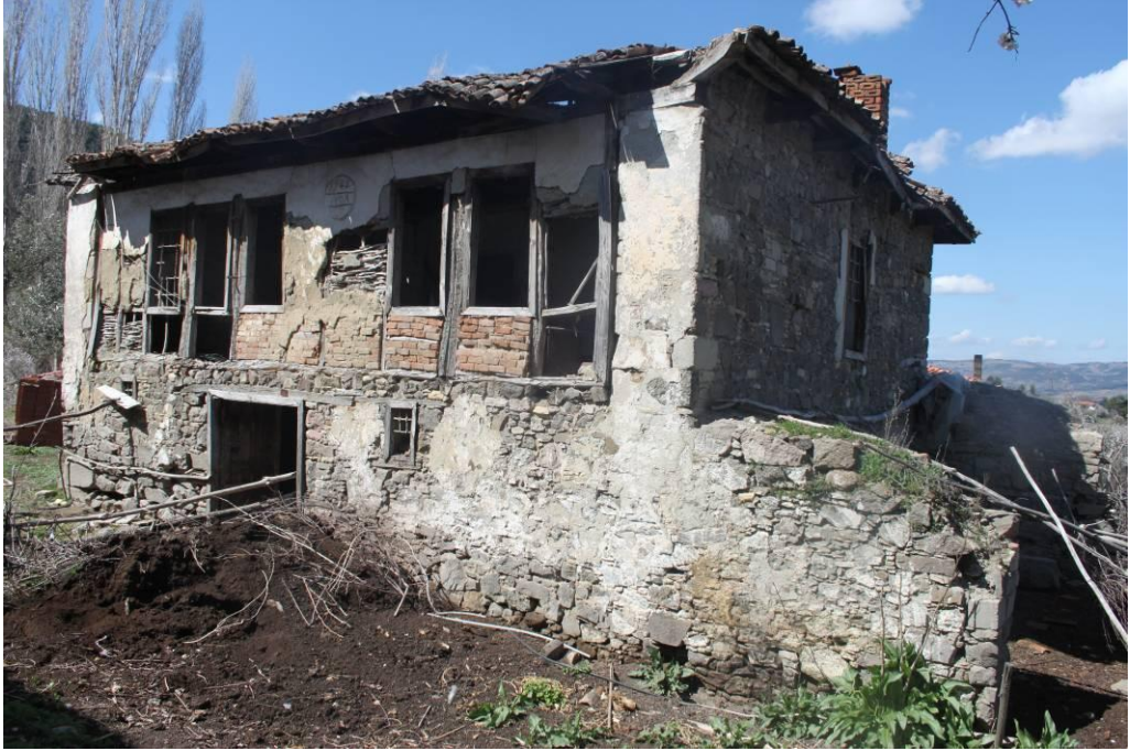
Şekil 3.54 2058 numaralı parselde bulunan kilisenin günümüzdeki harap durumu
