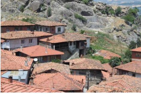
Ön cephe ve yapının birinci katına çıkan merdiven
