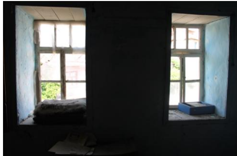
Oda iç mekanından pencerelerin görünümü
