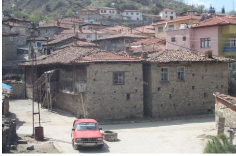
Yapının giriş cephesinden bir perspektif
