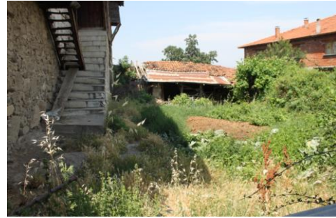
Yapıya çıkan merdivenler
