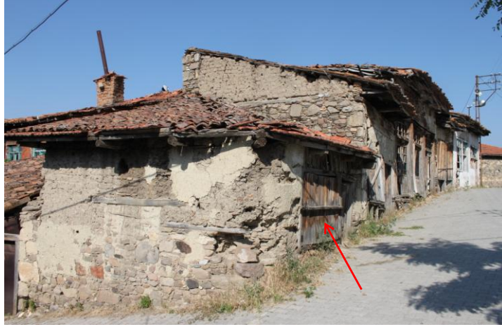
Yapının batı cephesinden görünüm
