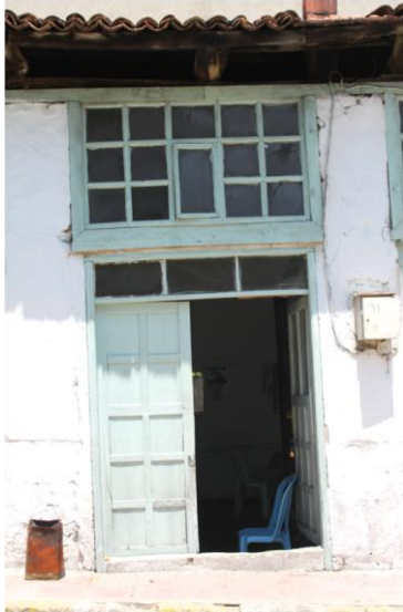
Yoldan yan giriş kapısının görünümü
