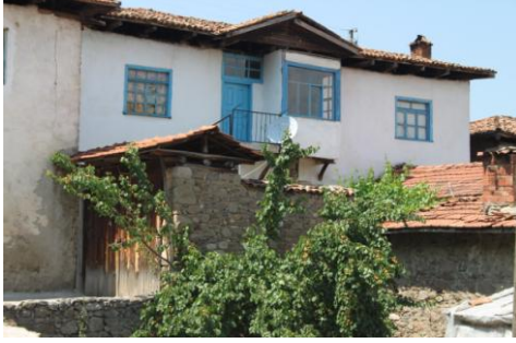
Ön cephe ve avlu kapısı
