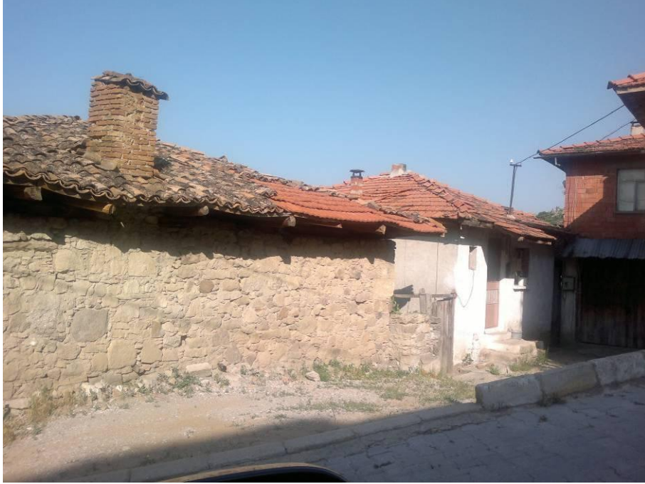
řekil 4.24 Yapının gneybatı cephesinde bulunan ikinci avlu kapısı ve hemen yanında 1969 Gediz Depremi Evi
