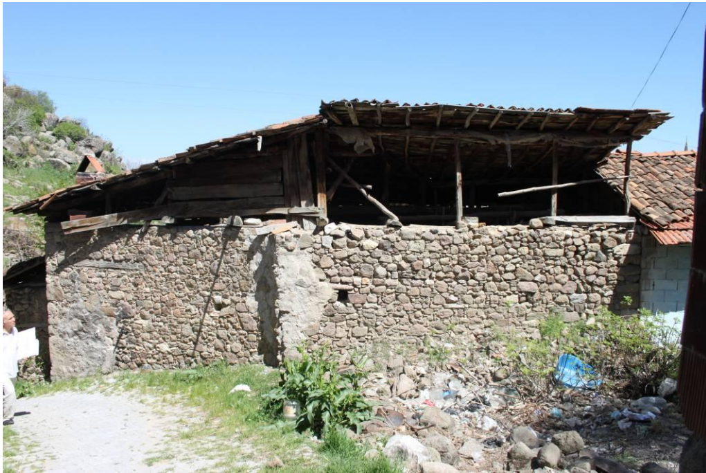
Şekil 4.6 Yapının batı cephesinden görünüm
