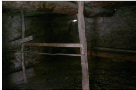
Zemin katta bulunan hayvan damı
