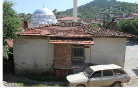
Yapının arka cephe girişi
