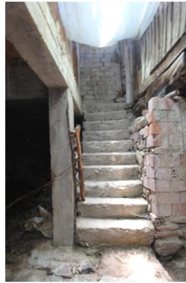
Birinci kata çıkan betonarme merdiven
