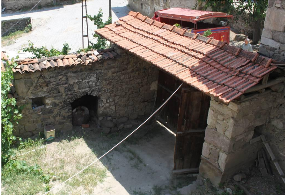
Şekil 3.77 1932 numaralı parseldeki yapıda avlu duvarında bulunan ocak
