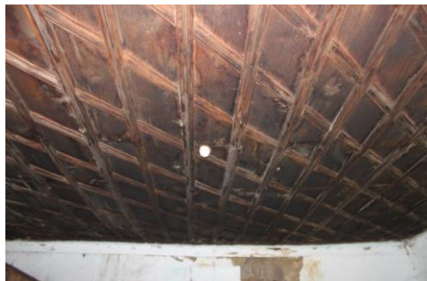
Odadan çıtalı, baklavalı düzendeki ahşap tavan örneği
