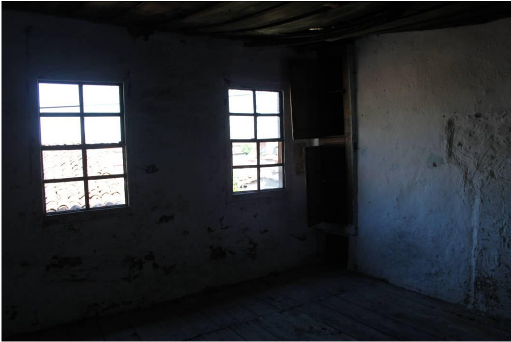
Şekil 4.12 Kapatılmış ocak izi, kapaklı dolap nişleri ve dikey sürgülü ahşap pencereler
