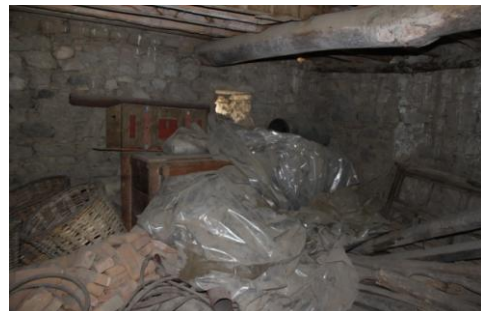
Zemin katta bulunan depolardan iç mekanın görünümü
