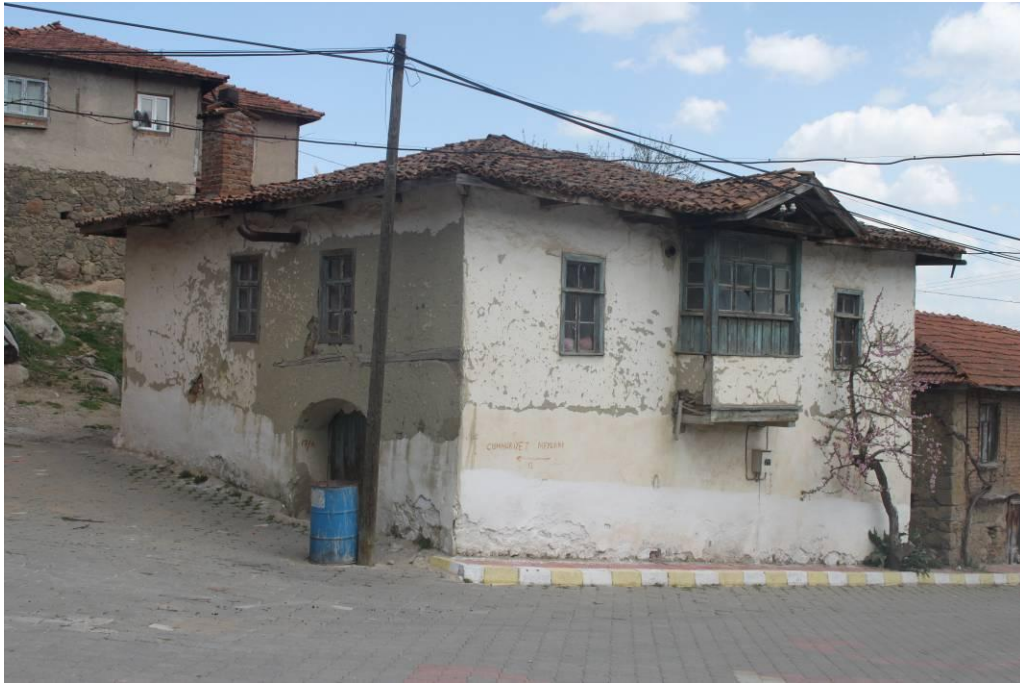
Şekil 4.37 1823 numaralı parselde bulunan yapının güneydoğu cephesinden görünüm
