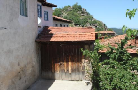
Avlu giriş kapısı
