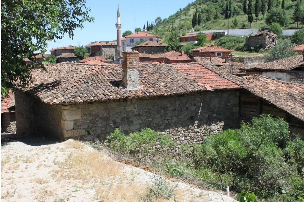
Şekil 4.30 Yapının kuzeybatı cephesinden görünüm
