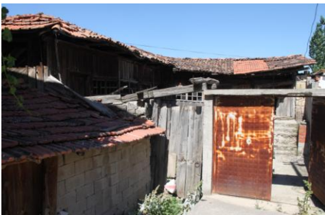
Avlu giriş kapısı
