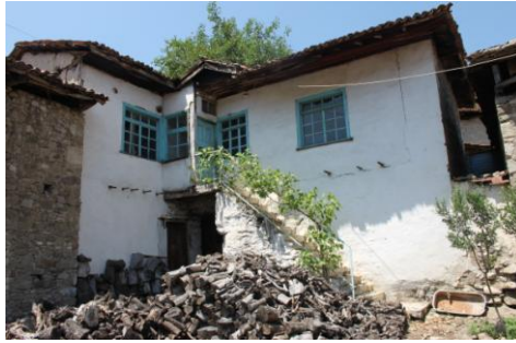
Yapıya çıkan merdiven ve zemin katta bulunan depo girişi
