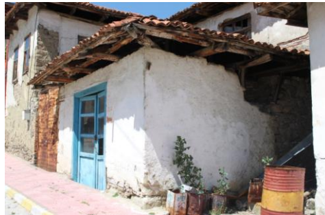
Yapının ticari amaçla kullanılan depo mekanı
