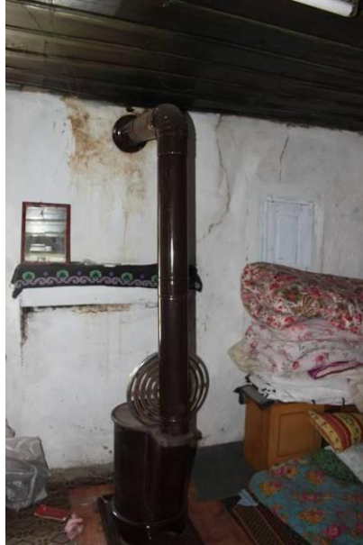
Şekil 4.44 Tuğla duvar örülerek kapatılmış ocak duvarı
