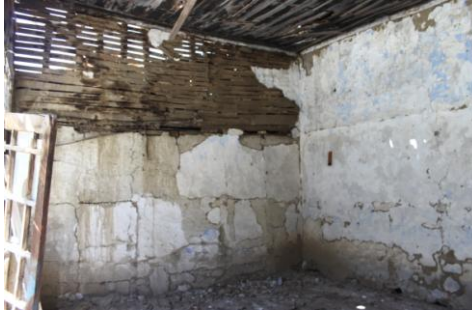
Yapının içinden ahşap karkas (bağdadi) duvar görünümü
