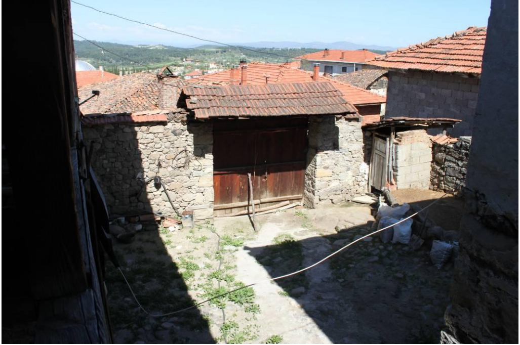
Şekil 4.26 Yapının kuzeydoğu cephesinde bulunan ve kullanılmayan avlu kapısı ile avluda yer alan helanın dış sofadan görünümü
