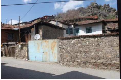
Ana giriş cephesi ve avlu giriş kapısı
