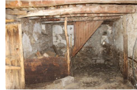
Zemin katta bulunan deponunve üst kata çıkan merdivenin görünümü
