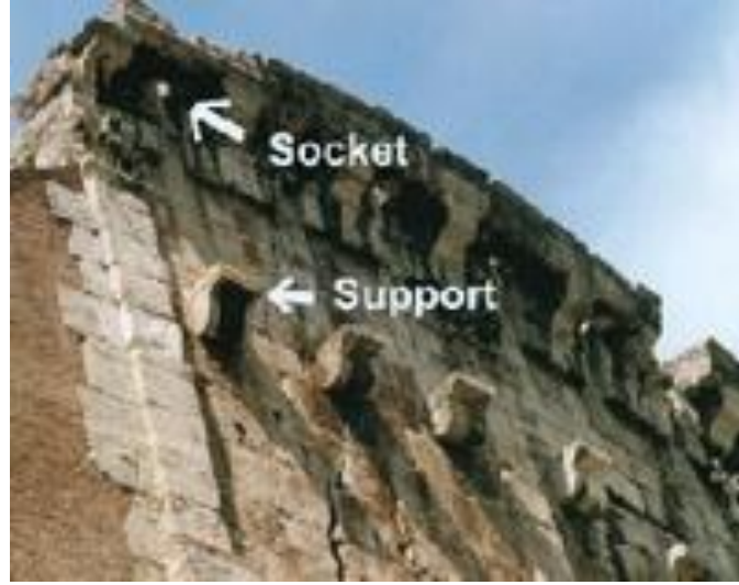
Şekil 3.137 Colosseum hareketli çatı için çıkma destekleri (Mezher, 2003)
