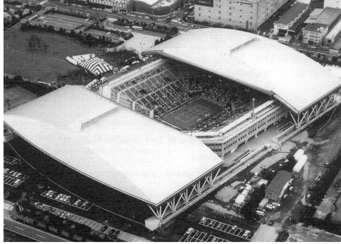
Şekil 3.100 Yapı strüktüründen tamamen bağımsız çatı strüktürü (Valcarcel, 2011)
