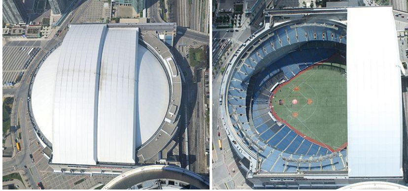
Şekil 3.102 Toronto Sky Dome hareketli çatısı (Rogers Centre, 2011)
