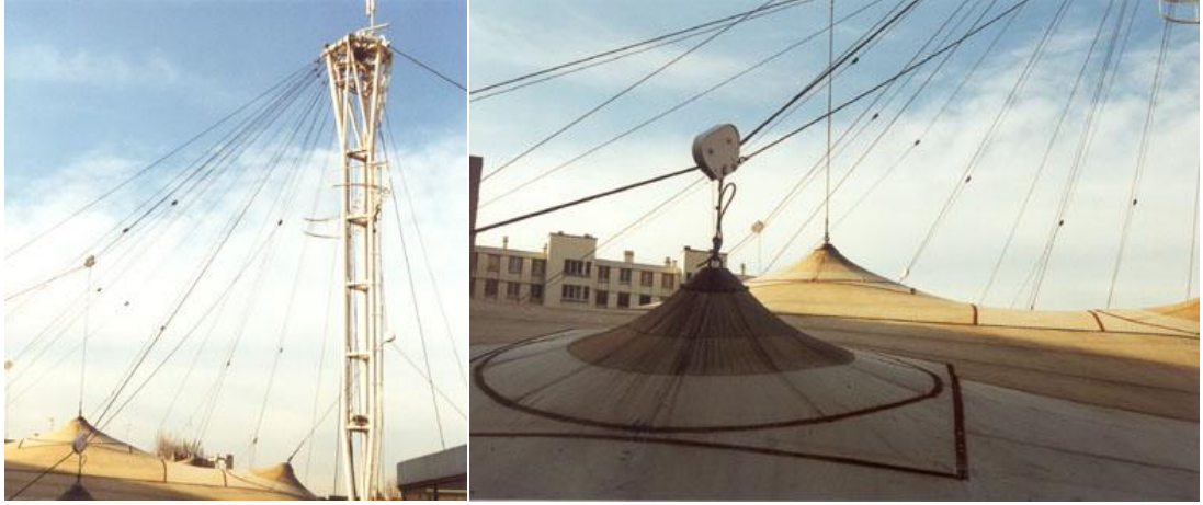
Şekil 3.127 Üst örtü askı noktaları ve hareket kabloları (Swimming-pool: Experimental Swimming-pools – 1970-1971, 2011)
