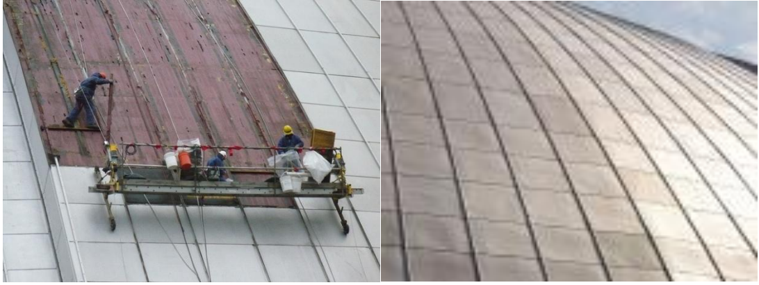
Şekil 3.134 Pittsburgh Civic Arena çelik kaplama işçiliği (A Civic Renewal, 2007)
