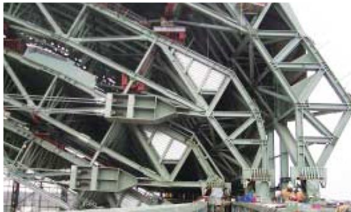
Şekil 3.48 Hareketli çatı panelleri ray kirişi (Jenkins, 2002)
