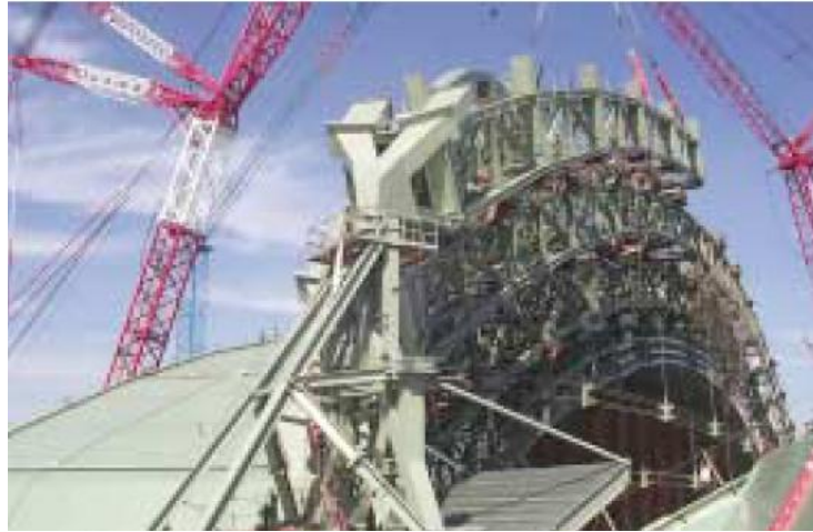
Şekil 3.47 Hareketli çatı panelleri pivot çerçeve (Jenkins, 2002)
