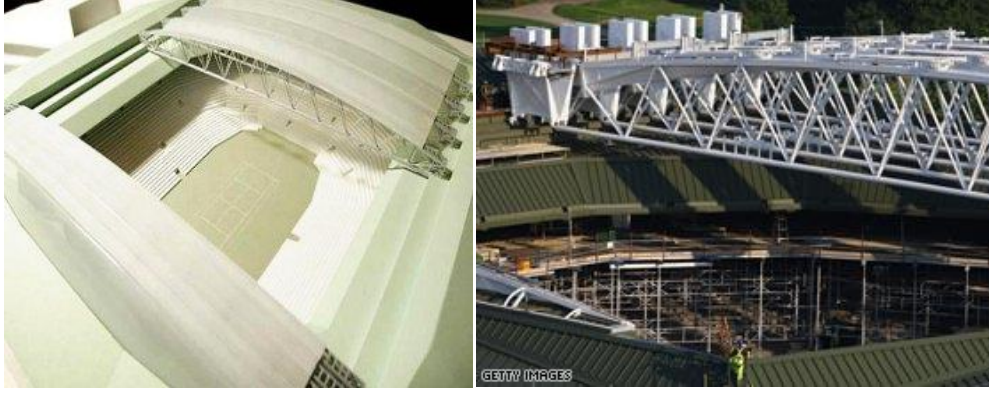
Şekil 3.16 Wimbledon Merkez Kortu üst örtüsü hareket kirişleri (Wimbledon Centre Court Retractable Roof, 2011)
