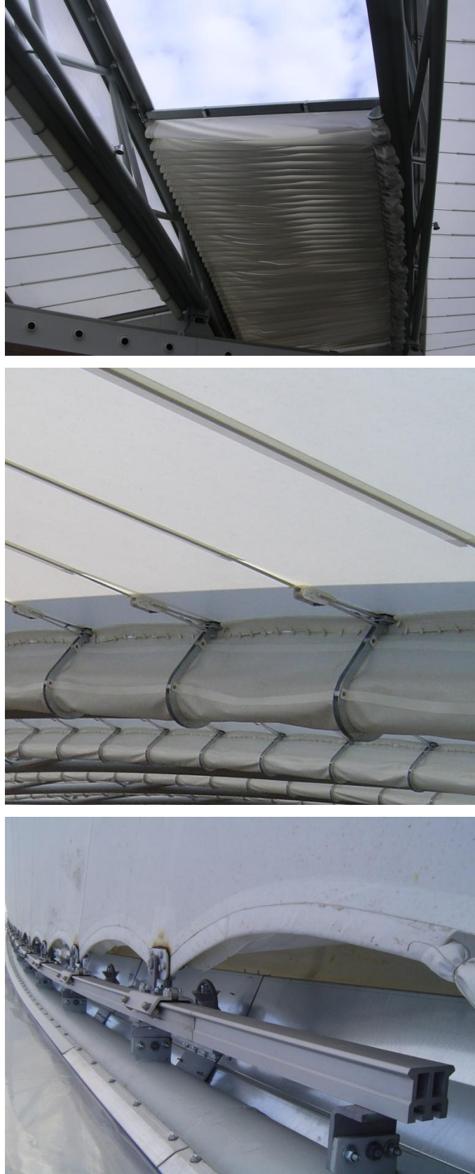
Şekil 3.98 Üst örtünün kullanımı ve destekleri (Athens Heart Shopping Mall, 2012)
