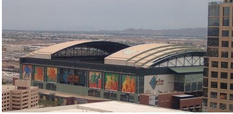
Şekil 3.65 Bağımsız çatı panelleri (Frazer, 2005)
