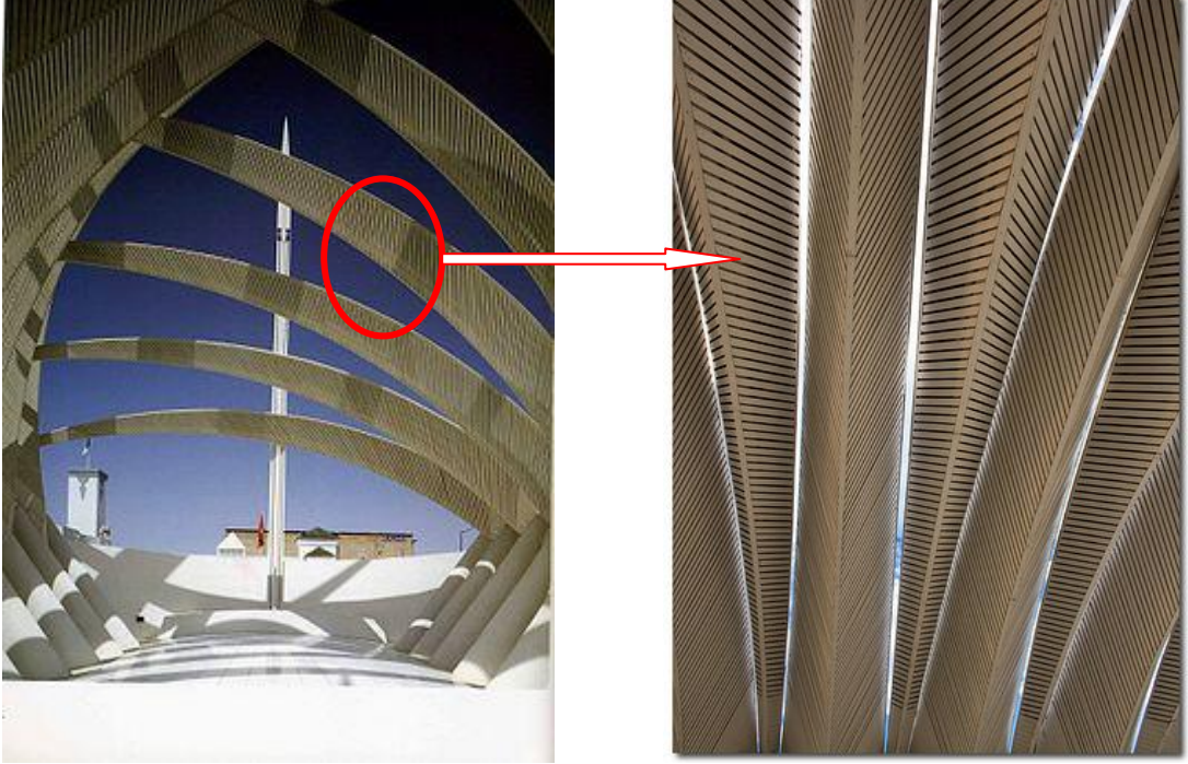
Şekil 3.92 Yay formu ve üçgen kesitli ahşap kaburgalar (Kuwait Pavilion Expo'92, 2011)
