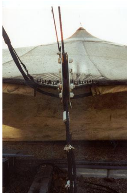
Şekil 3.128 Üst örtü hareket makaraları (Swimming-pool: Experimental Swimming-pools – 1970-1971, 2011)
