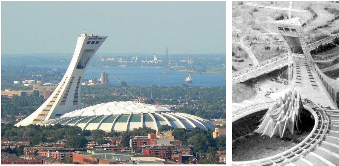
Şekil 3.114 Montreal Olimpiyat Stadı örtü malzemesinde hareketli çatısı
