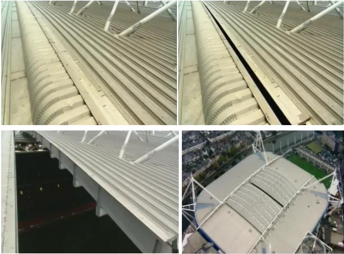
Şekil 3.63 Hareketli çatı panellerinde kayma hareket özelliğiyle açılma (Parkour At Millenium Stadium, 2011)
