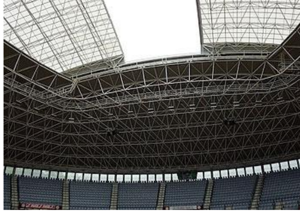
Şekil 3.60 Sabit ve hareketli çift tabakalı uzay çatı strüktürü (Plaza de Illumbe, 2012)
