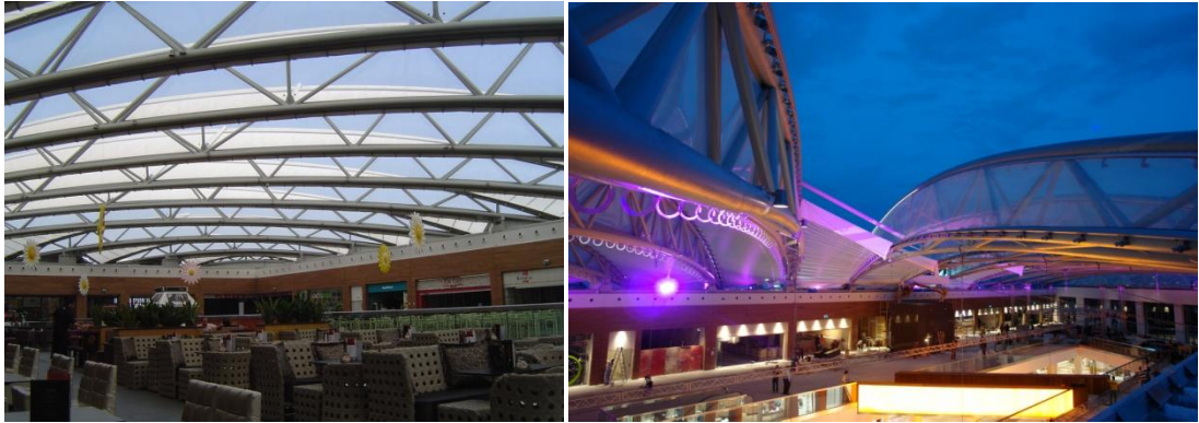
Şekil 3.96 Hareketli çatıda boru profillerden oluşan makaslar (Athens Heart Shopping Mall, 2012)
