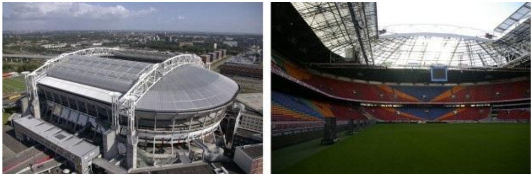
Şekil 3.76 Amsterdam Stadyumu hareketli paneller (Access To Super Structure Amsterdam Arena, 2011)
