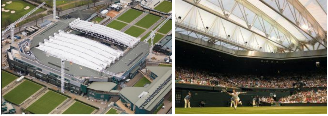
Şekil 3.15 Wimbledon Merkez Kortu üst örtüsü (Wimbledon Centre Court Retractable Roof, 2011)
