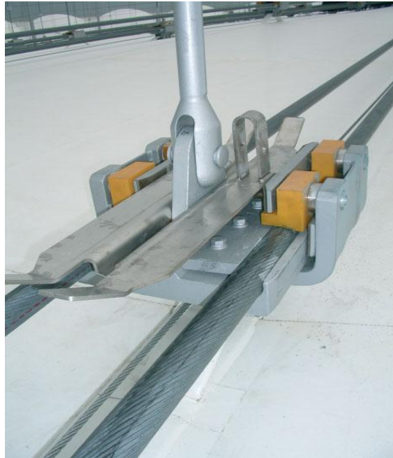
Şekil 3.27 Hareketli çatının mekanik tekerlekleri (Structural Engineering International, 2007)
