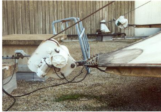
Şekil 3.127 Üst örtü askı noktaları ve hareket kabloları (Swimming-pool: Experimental Swimming-pools – 1970-1971, 2011)
