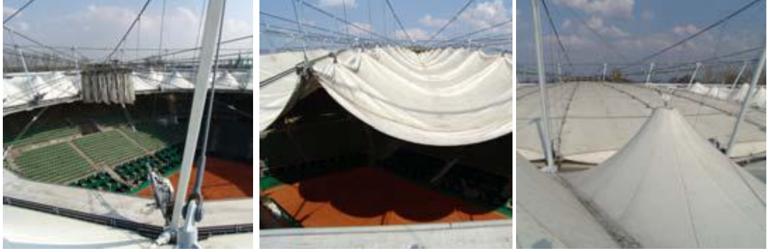
Şekil 3.67 Membran üst örtünün kılavuz halatlar üzerinde hareketi (Rothenbaum Tennis Centre Court, 2012)
