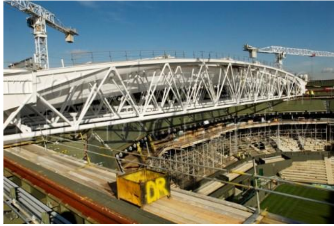
Şekil 3.16 Wimbledon Merkez Kortu üst örtüsü hareket kirişleri (Wimbledon Centre Court Retractable Roof, 2011)
